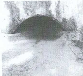
Carretera Iquitos - Nauta; Limpieza de Alcantarillas (colmatao con arena y exceso de vegetación)
