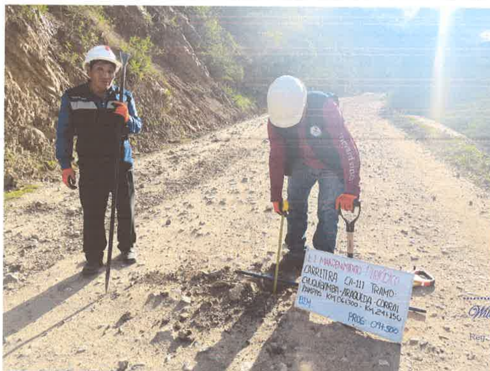
FOTO N° 14: MEDICIÓN DE ESPESOR DE AFIRMADO
