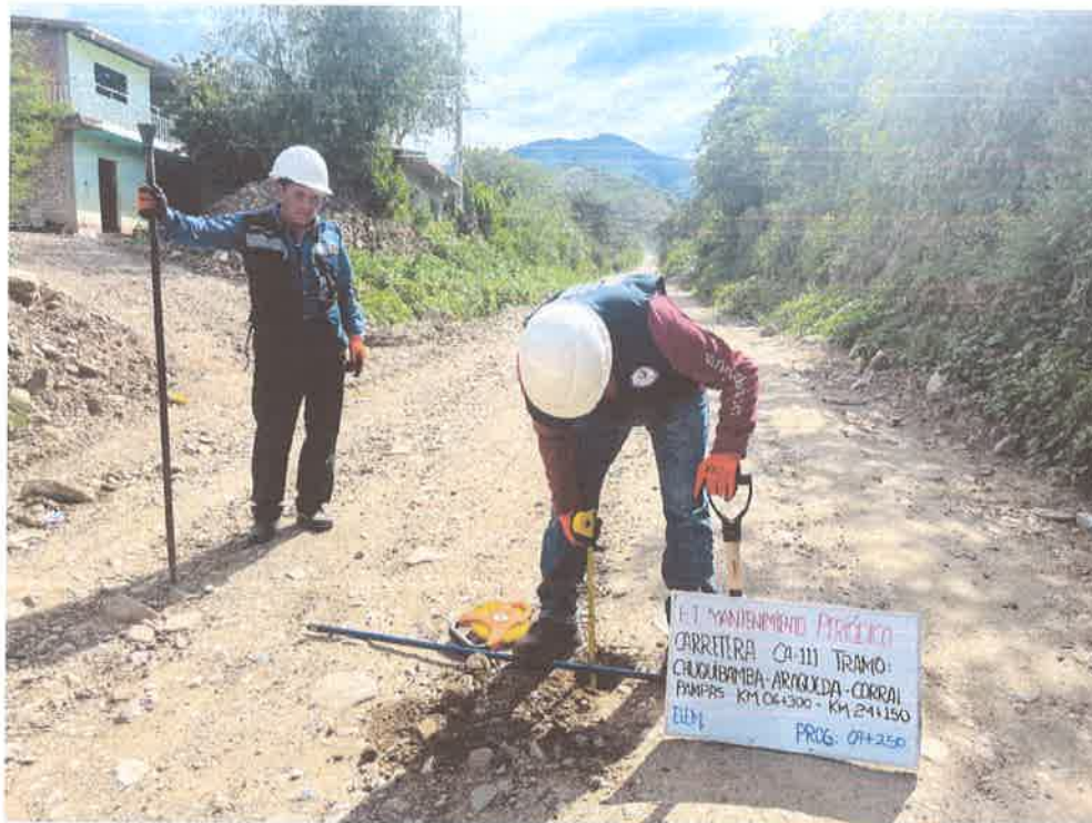
FOTO N° 05: MEDICIÓN DE ESPESOR DE AFIRMADO
