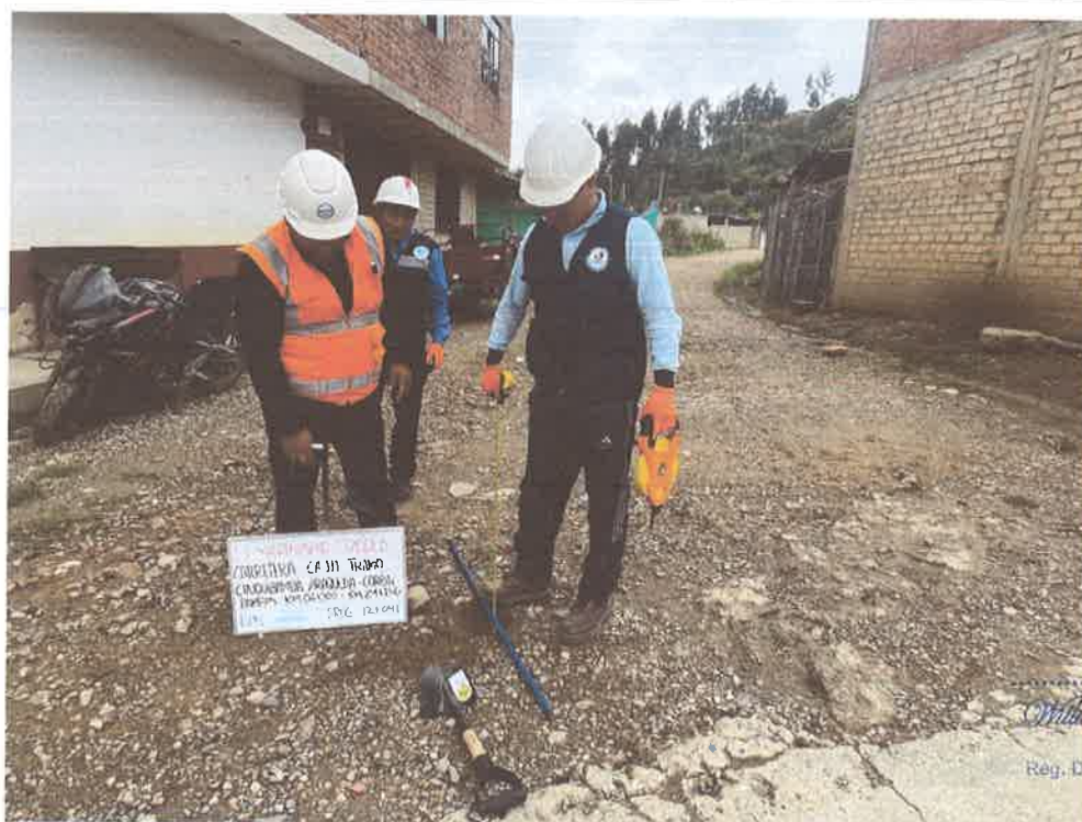
FOTO N° 26: MEDICIÓN DE ESPESOR DE AFIRMADO
