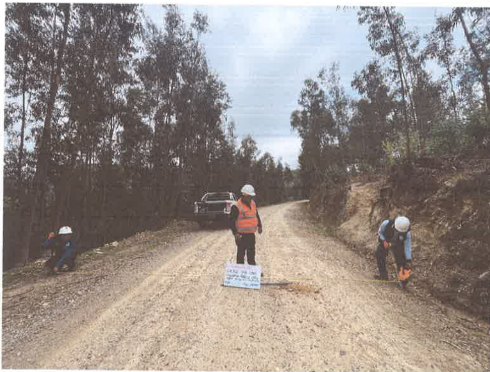
FOTO N° 67: MEDIDA DE ANCHO DE VIA
