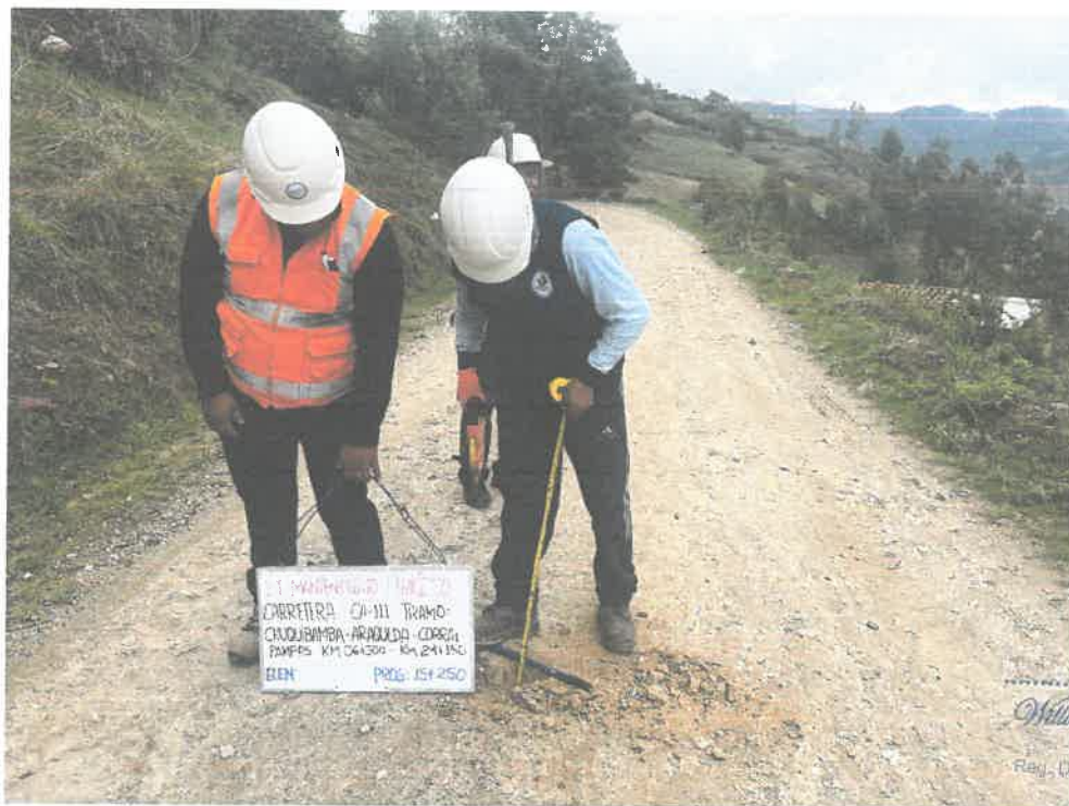
FOTO N° 38: MEDICIÓN DE ESPESOR DE AFIRMADO
