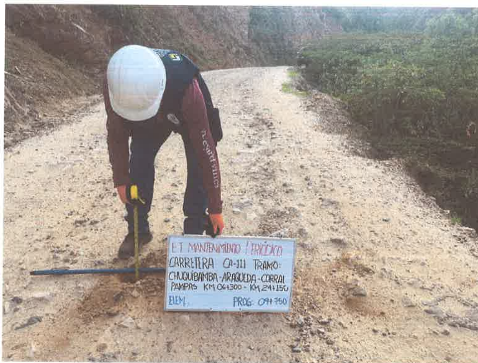
FOTO N° 15: MEDICIÓN DE ESPESOR DE AFIRMADO
