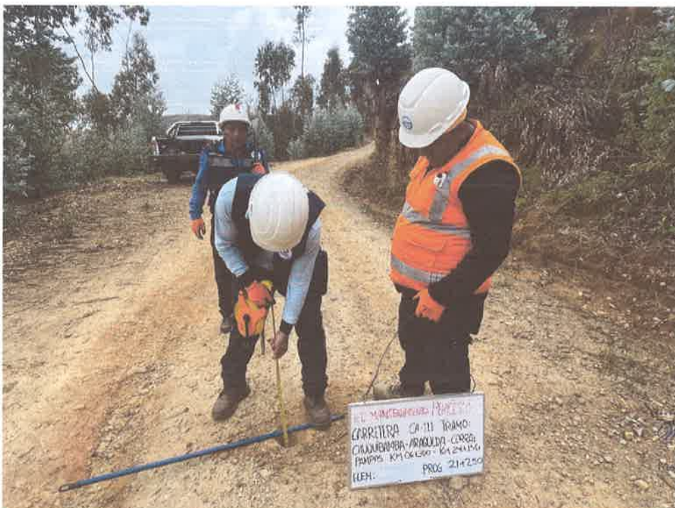
FOTO N° 62: MEDICIÓN DE ESPESOR DE AFIRMADO
