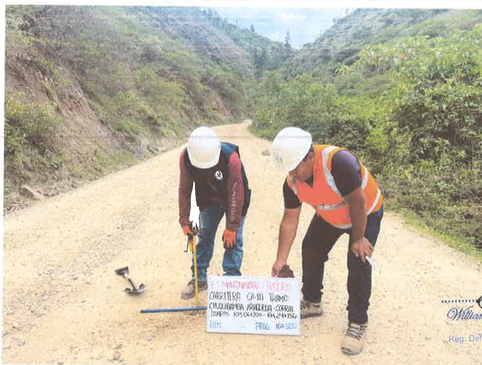
FOTO N° 18: MEDICIÓN DE ESPESOR DE AFIRMADO
