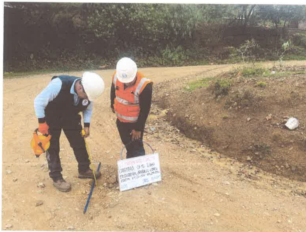
FOTO N° 29: MEDICIÓN DE ESPESOR DE AFIRMADO
