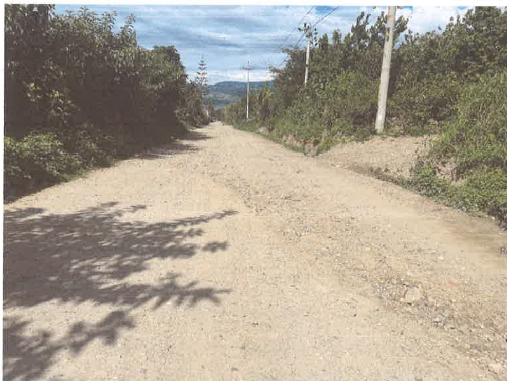
FOTO N° 02: EROSIÓN DEL AFIRMADO
