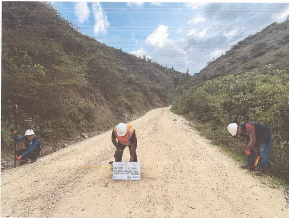
FOTO N° 18: MEDIDA DE ANCHO DE VIA
