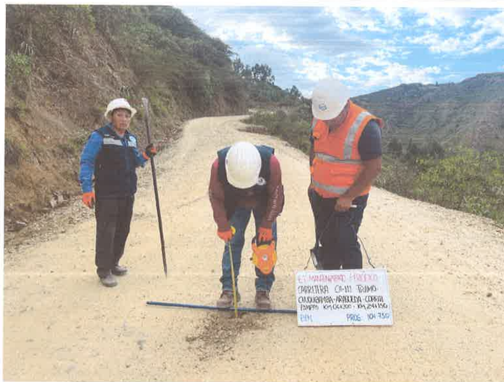
FOTO N° 19: MEDICIÓN DE ESPESOR DE AFIRMADO
