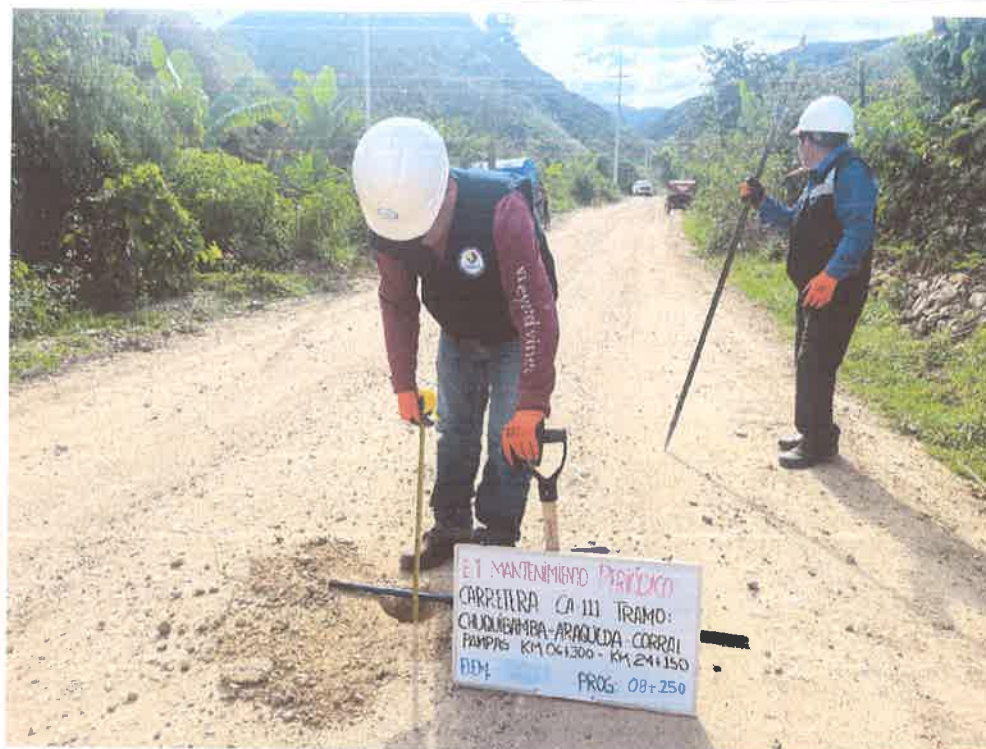
FOTO N° 09: MEDICIÓN DE ESPESOR DE AFIRMADO
