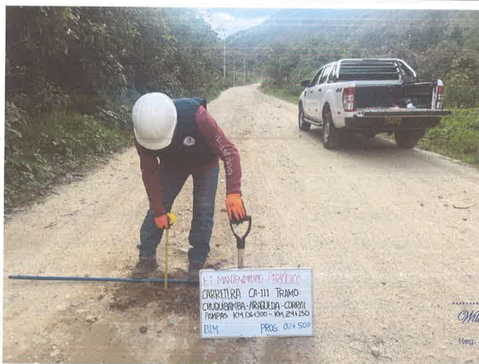
FOTO N° 10: MEDICIÓN DE ESPESOR DE AFIRMADO
