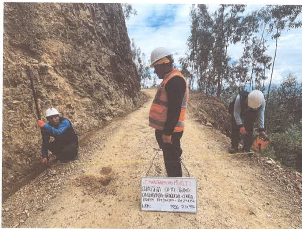
FOTO N° 63: MEDIDA DE ANCHO DE VIA
