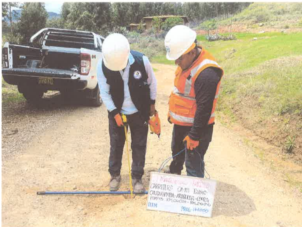
FOTO N° 45: MEDICIÓN DE ESPESOR DE AFIRMADO
