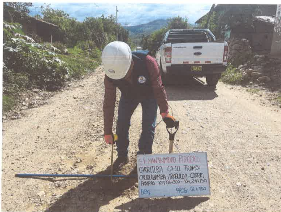
FOTO N° 03: MEDICIÓN DE ESPESOR DE AFIRMADO
