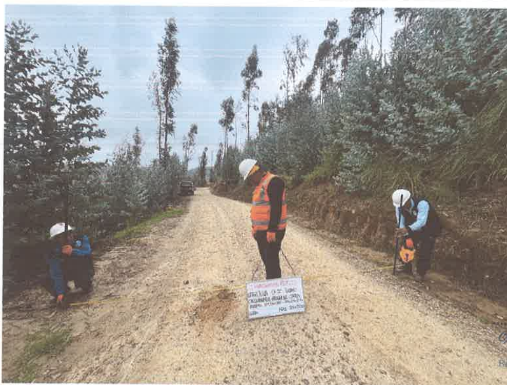
FOTO N° 62: MEDIDA DE ANCHO DE VIA
