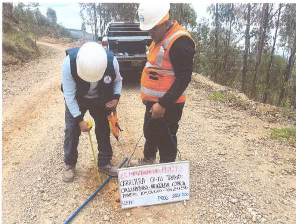
FOTO N° 65: MEDICIÓN DE ESPESOR DE AFIRMADO
