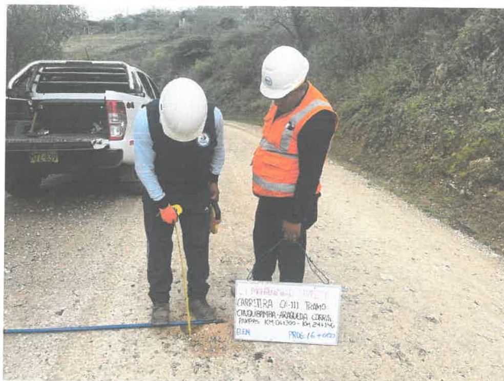
FOTO N° 41: MEDICIÓN DE ESPESOR DE AFIRMADO
