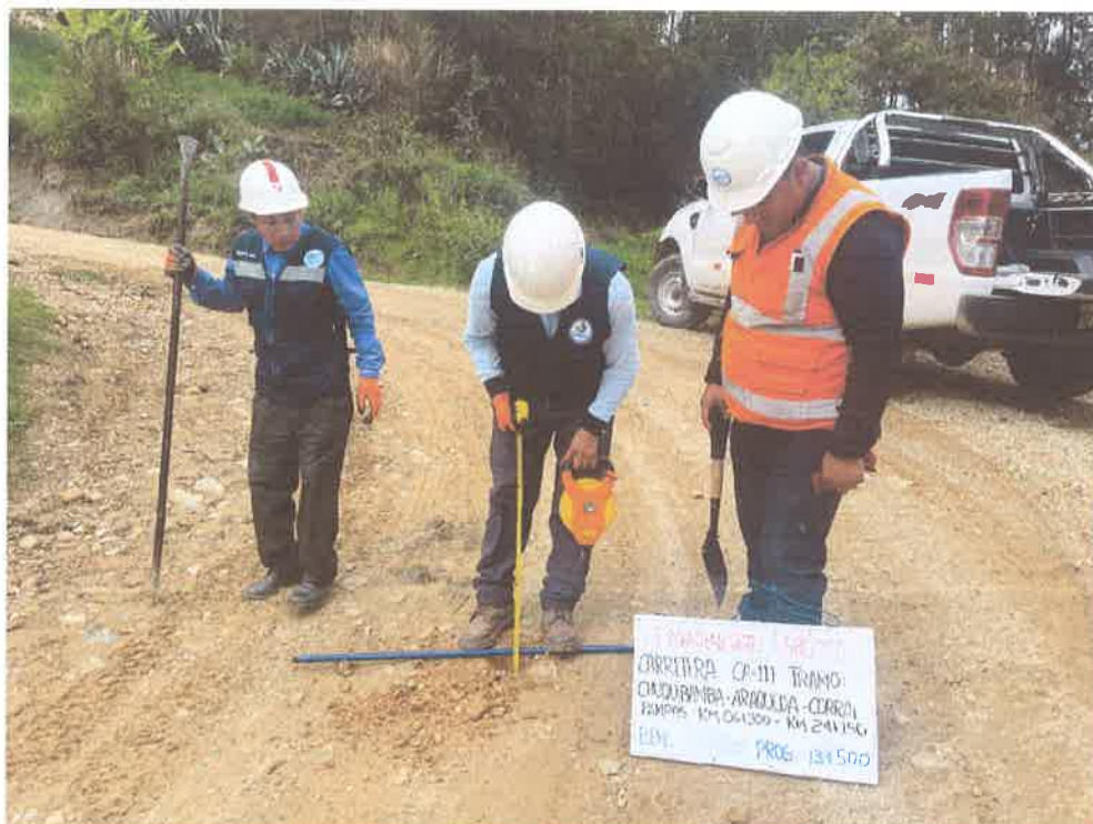
FOTO N° 31: MEDICIÓN DE ESPESOR DE AFIRMADO
