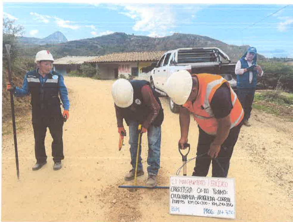
FOTO N° 23: MEDICIÓN DE ESPESOR DE AFIRMADO
