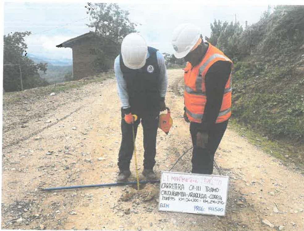
FOTO N° 35: MEDICIÓN DE ESPESOR DE AFIRMADO
