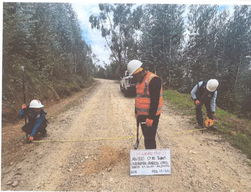
FOTO N° 51: MEDIDA DE ANCHO DE VIA
