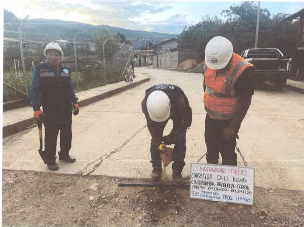
FOTO N° 25: MEDICIÓN DE ESPESOR DE AFIRMADO
