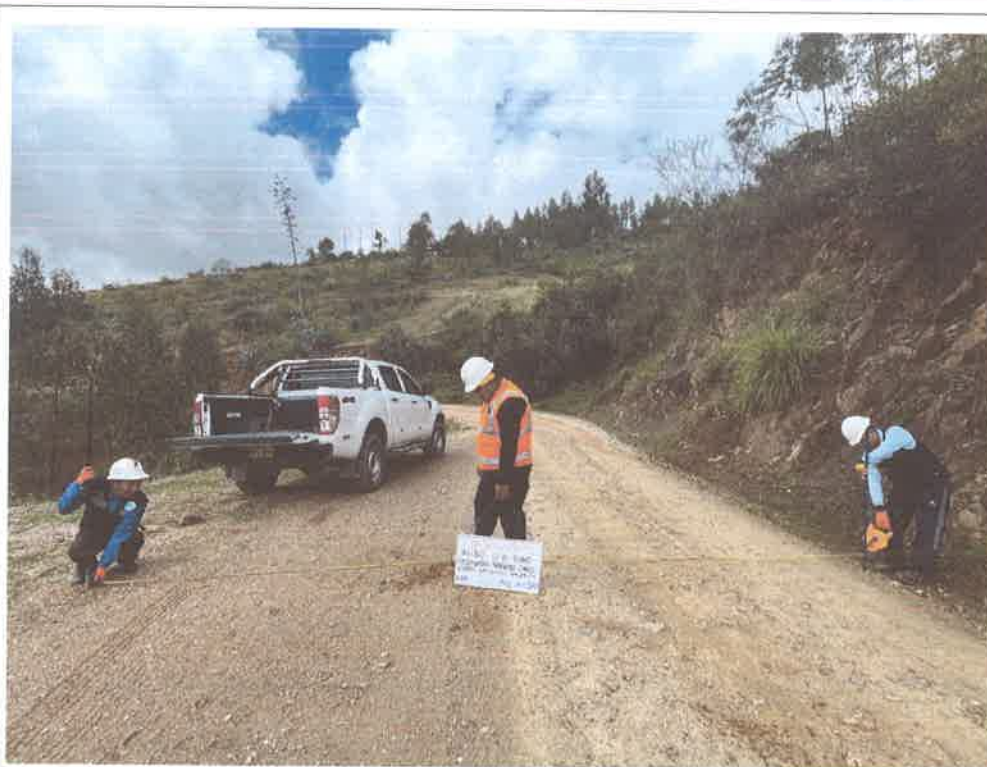
FOTO N° 43: MEDIDA DE ANCHO DE VIA
