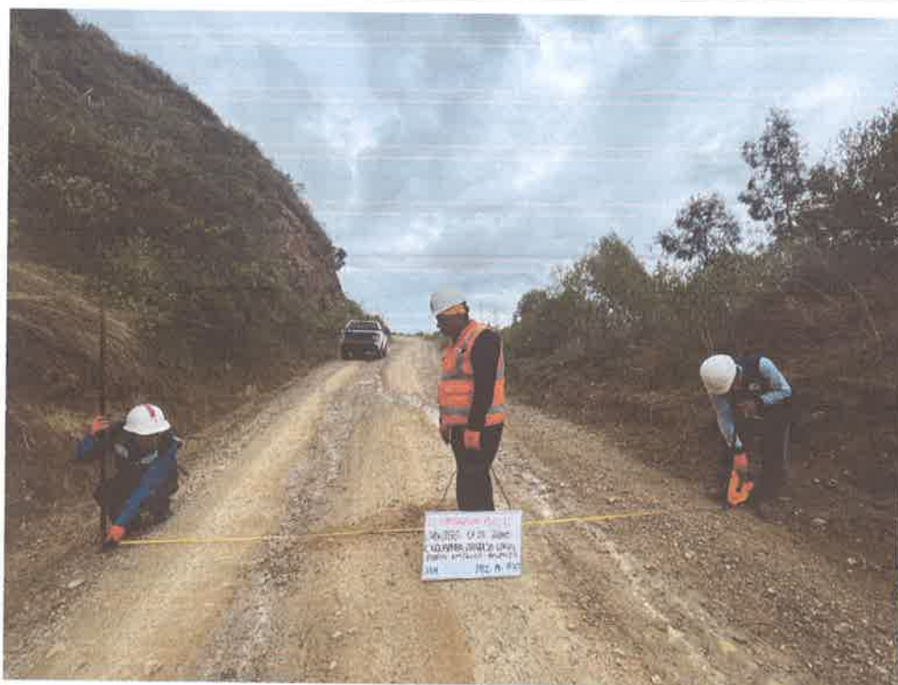
FOTO N° 56: MEDIDA DE ANCHO DE VIA
