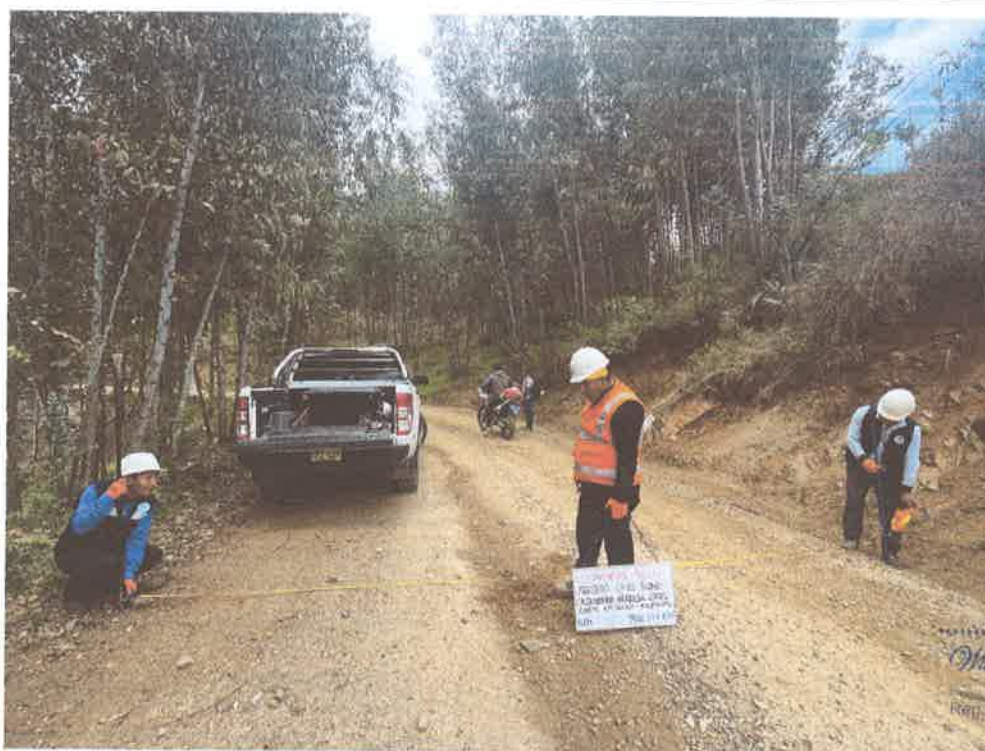
FOTO N° 48: MEDIDA DE ANCHO DE VIA
