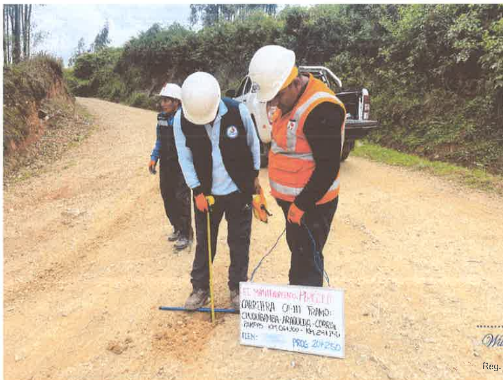
FOTO N° 58: MEDICIÓN DE ESPESOR DE AFIRMADO
