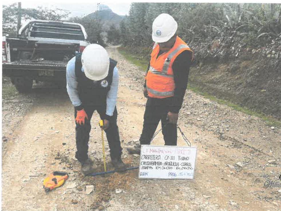
FOTO N° 40: MEDICIÓN DE ESPESOR DE AFIRMADO
