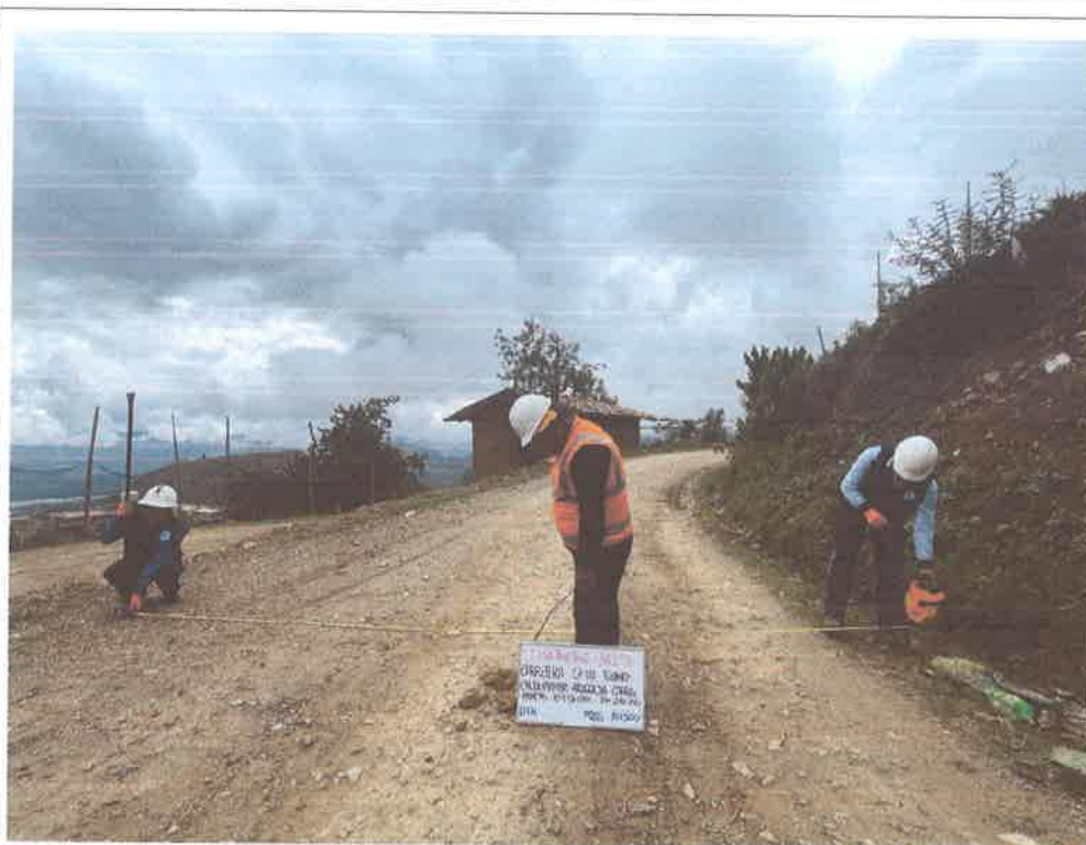
FOTO N° 35: MEDIDA DE ANCHO DE VIA
