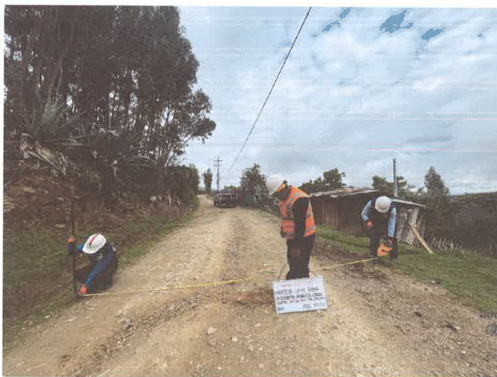
FOTO N° 34: MEDIDA DE ANCHO DE VIA
