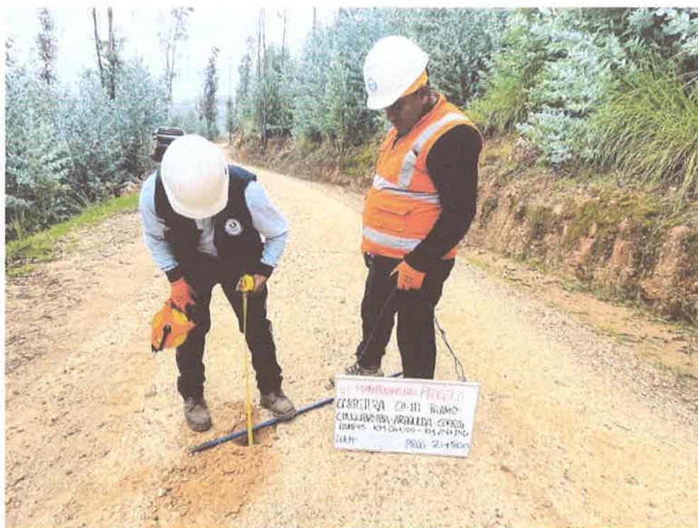
FOTO N° 63: MEDICIÓN DE ESPESOR DE AFIRMADO
