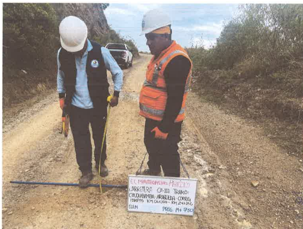
FOTO N° 56: MEDICIÓN DE ESPESOR DE AFIRMADO
