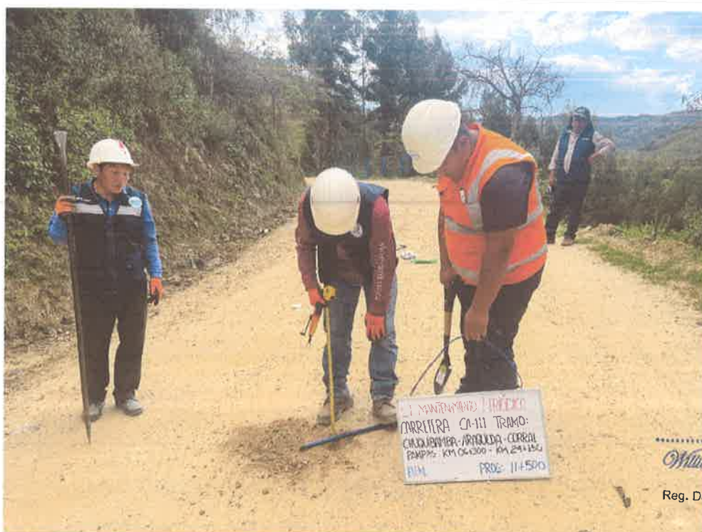
FOTO N° 22: MEDICIÓN DE ESPESOR DE AFIRMADO
