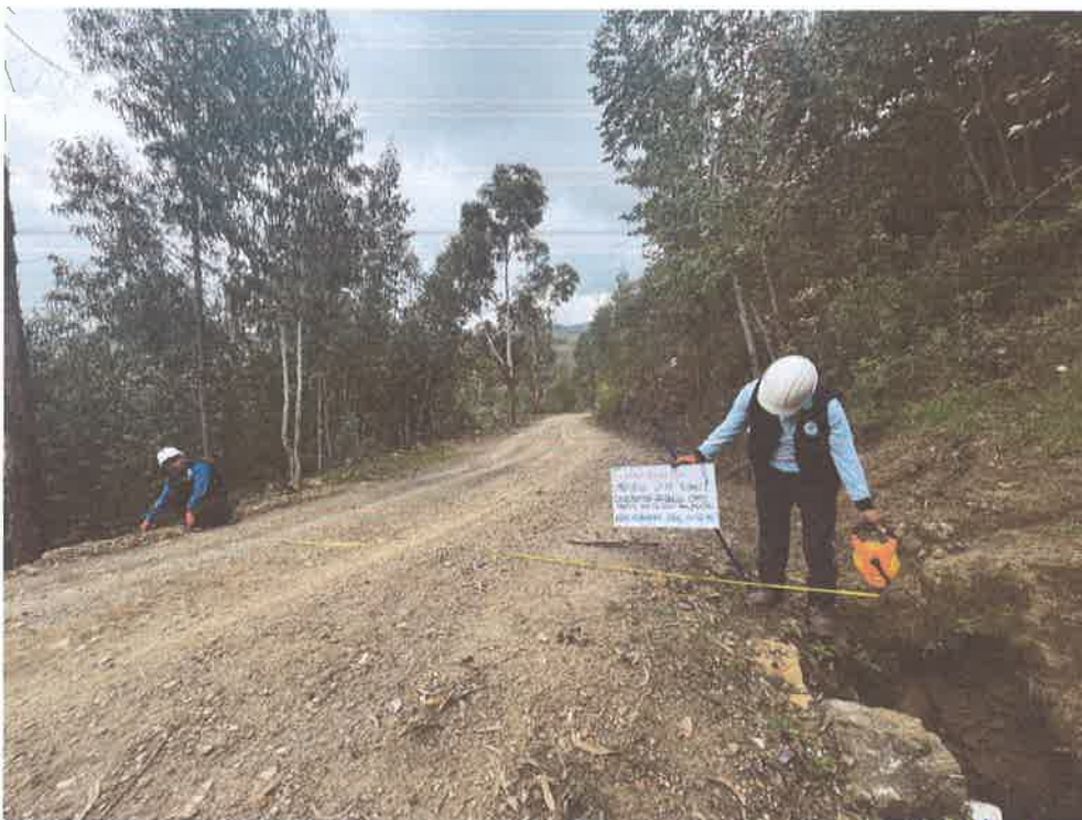
FOTO N° 18: EROSIÓN DEL AFIRMADO
