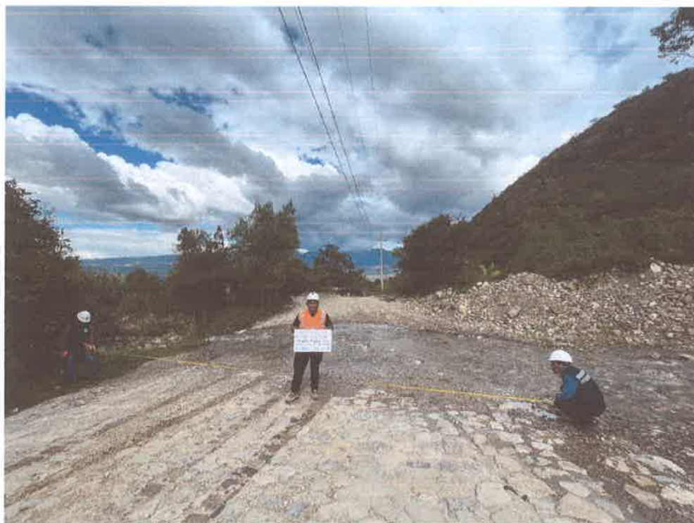
FOTO N° 01: BADEN MAMPOSTERIA PIEDRA - MAL ESTADO REQUIERE RECONSTRUCCION
