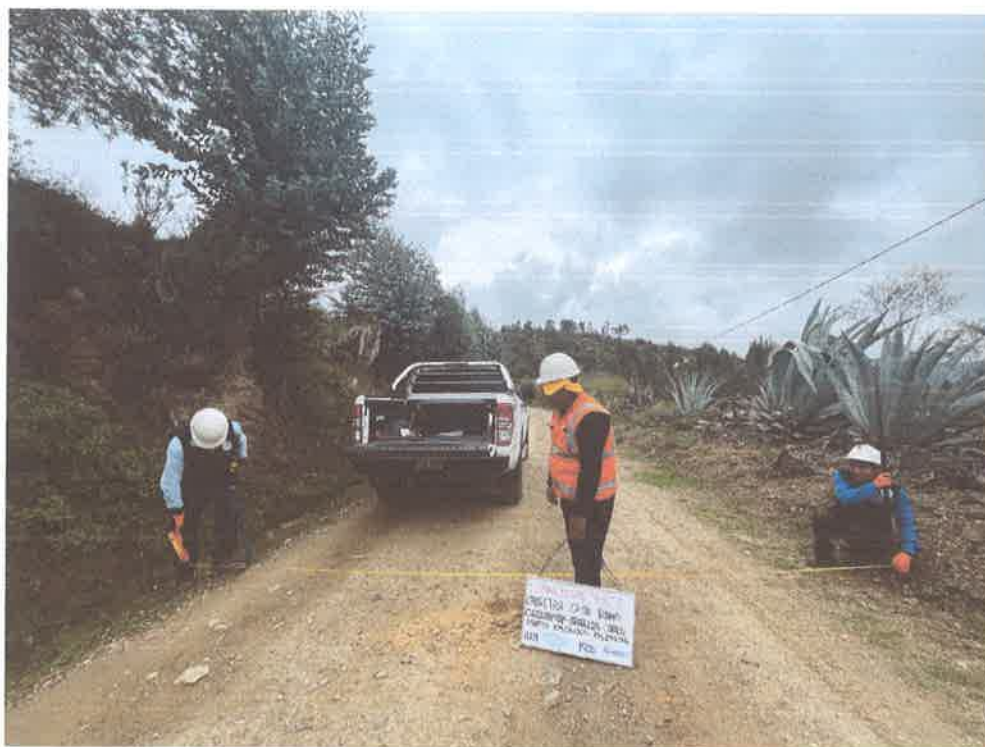
FOTO N° 33: MEDIDA DE ANCHO DE VIA
