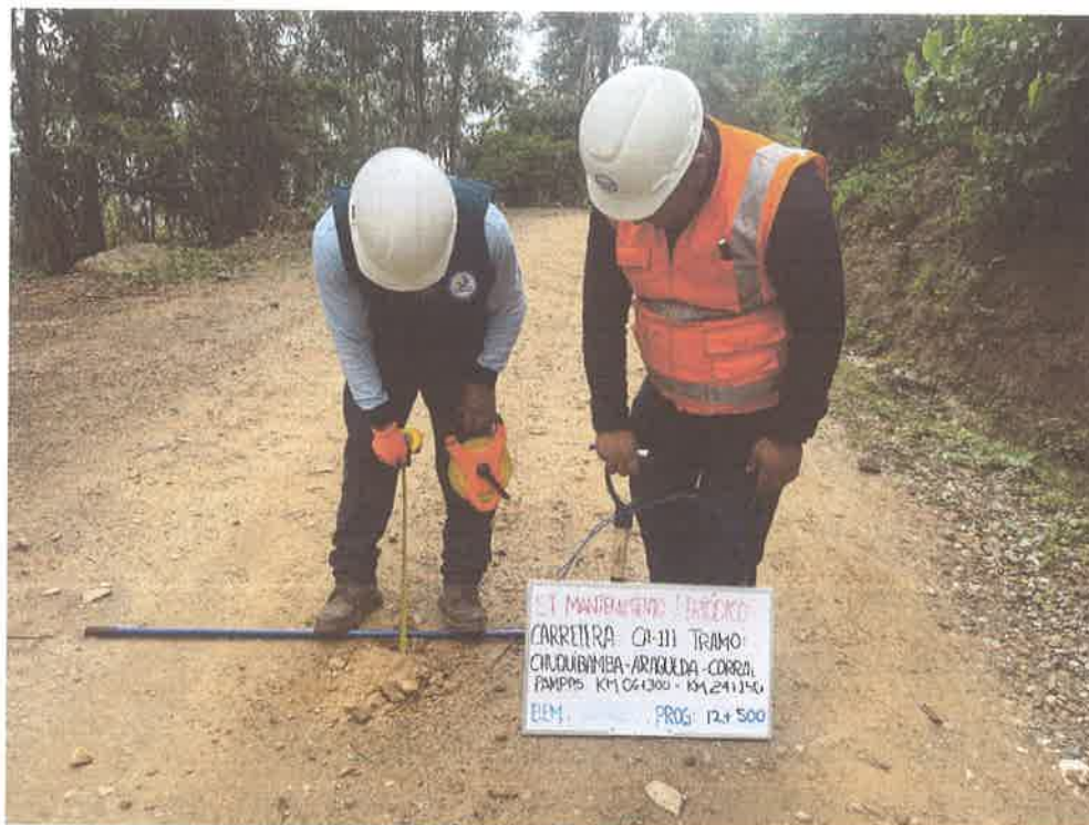
FOTO N° 27: MEDICIÓN DE ESPESOR DE AFIRMADO
