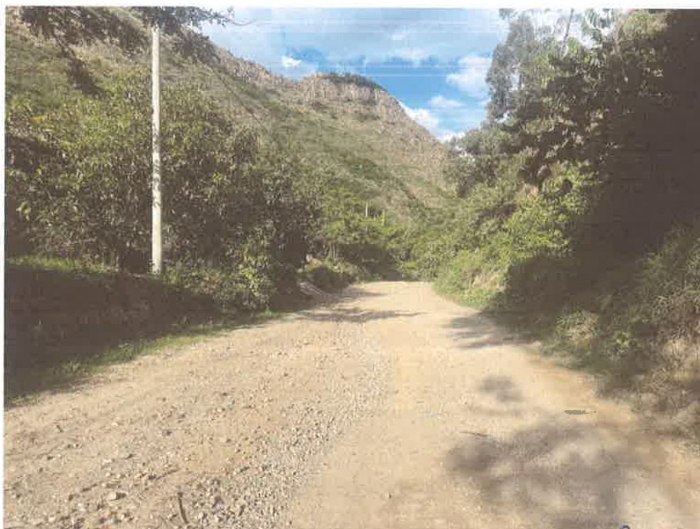
FOTO N° 08: EROSIÓN DEL AFIRMADO
