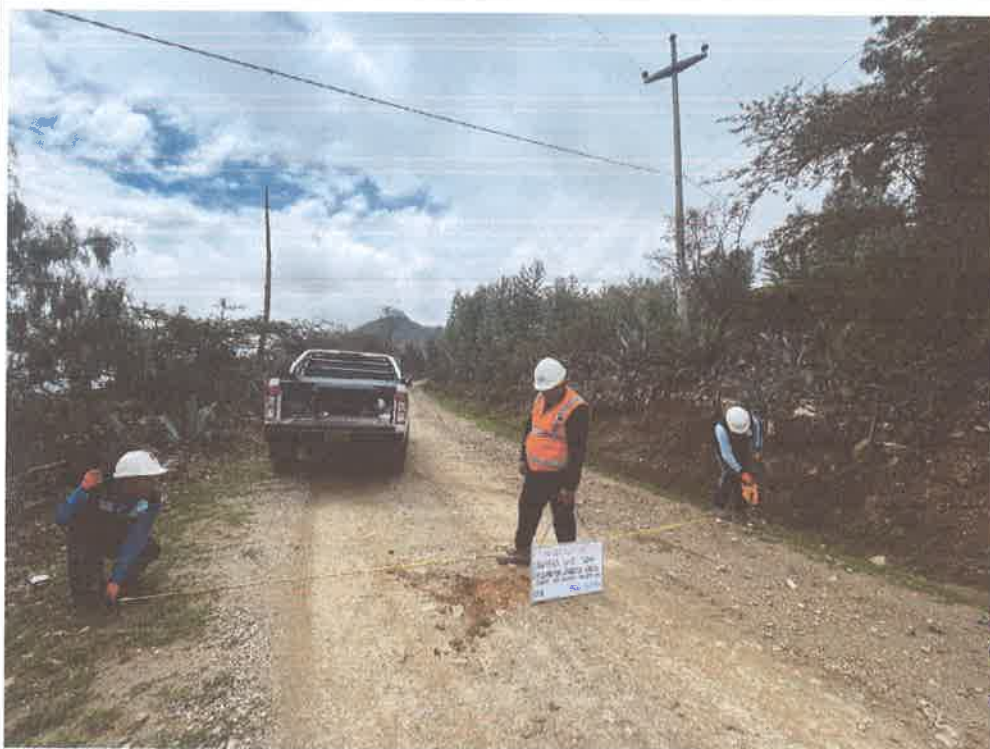
FOTO N° 40: MEDIDA DE ANCHO DE VIA
