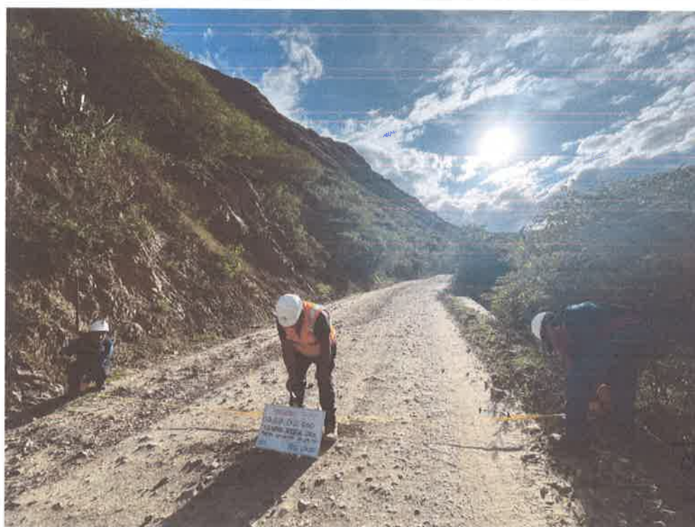
FOTO N° 14: MEDIDA DE ANCHO DE VIA
