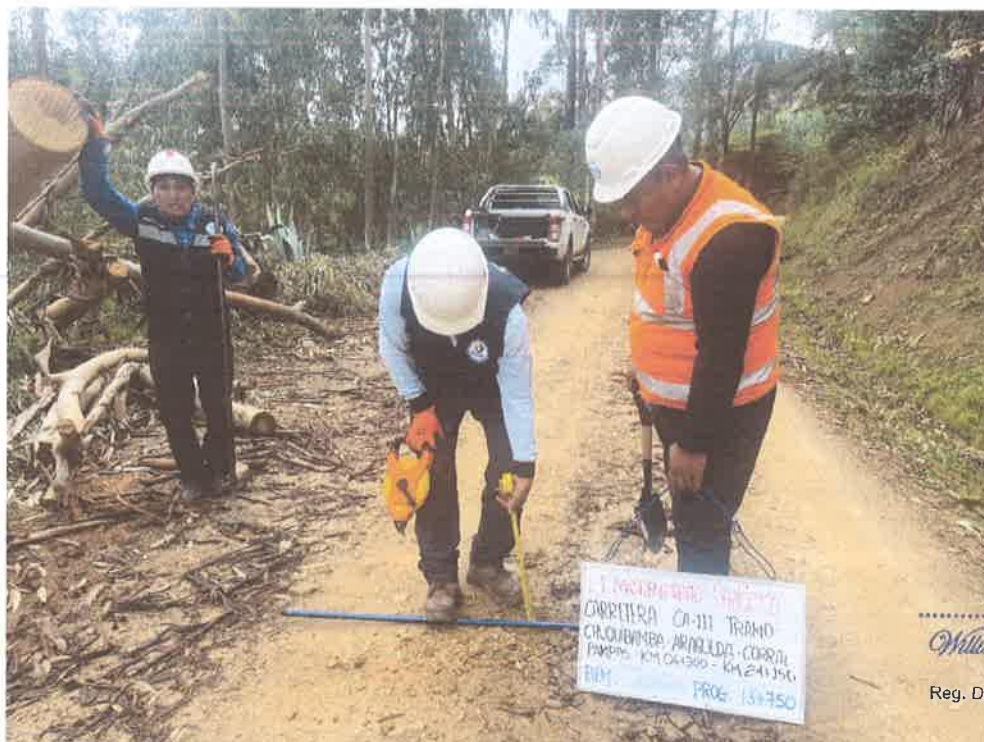
FOTO N° 32: MEDICIÓN DE ESPESOR DE AFIRMADO
