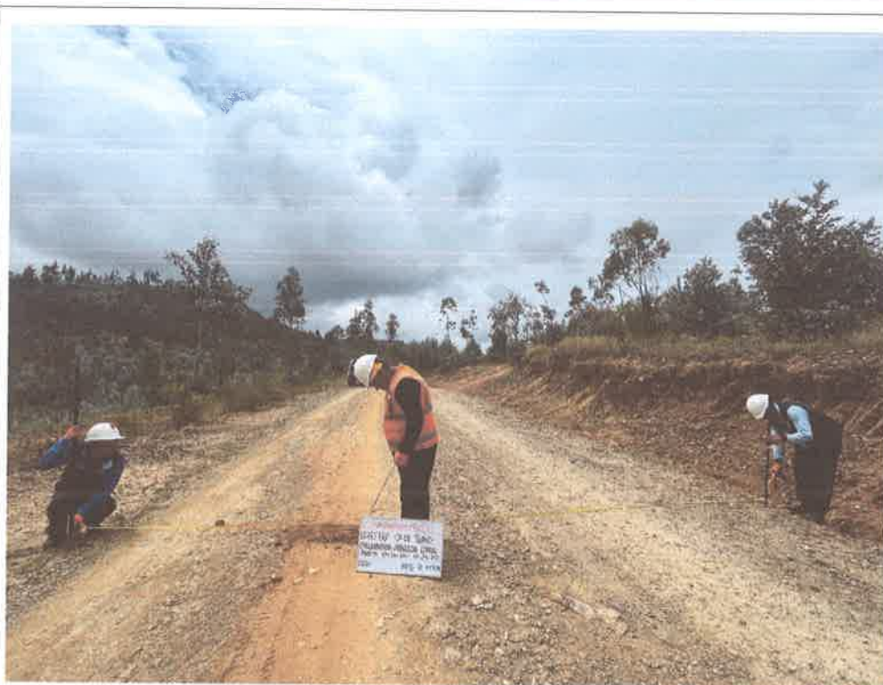
FOTO N° 61: MEDIDA DE ANCHO DE VIA
