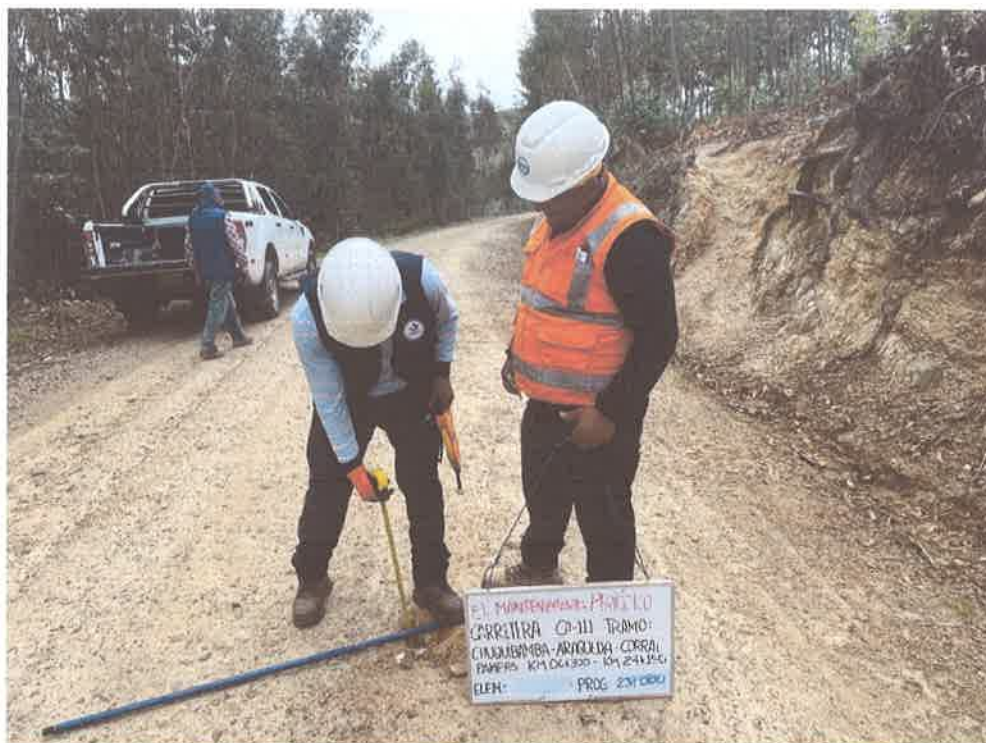
FOTO N° 69: MEDICIÓN DE ESPESOR DE AFIRMADO
