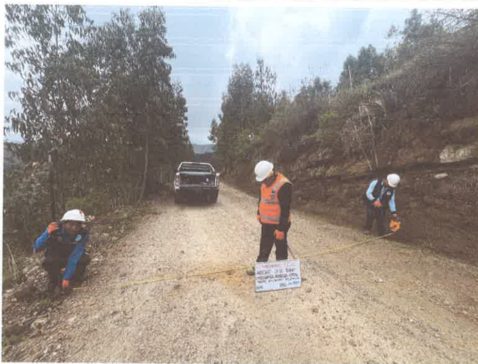
FOTO N° 47: MEDIDA DE ANCHO DE VIA
