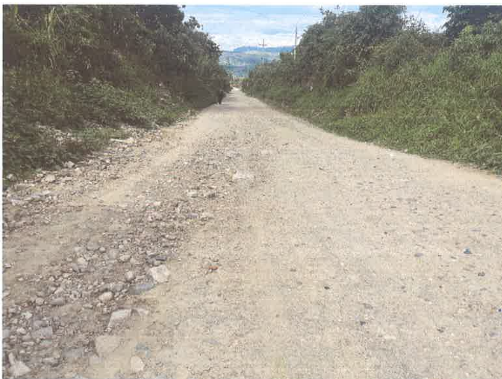
FOTO N° 04: EROSIÓN DEL AFIRMADO
