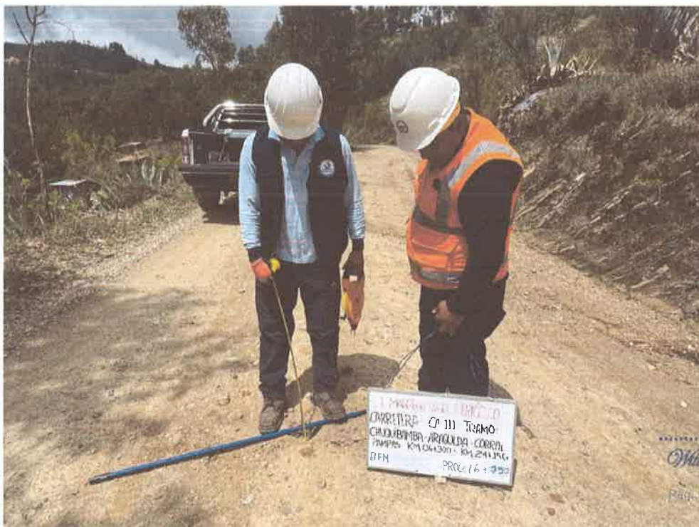
FOTO N° 44: MEDICIÓN DE ESPESOR DE AFIRMADO
