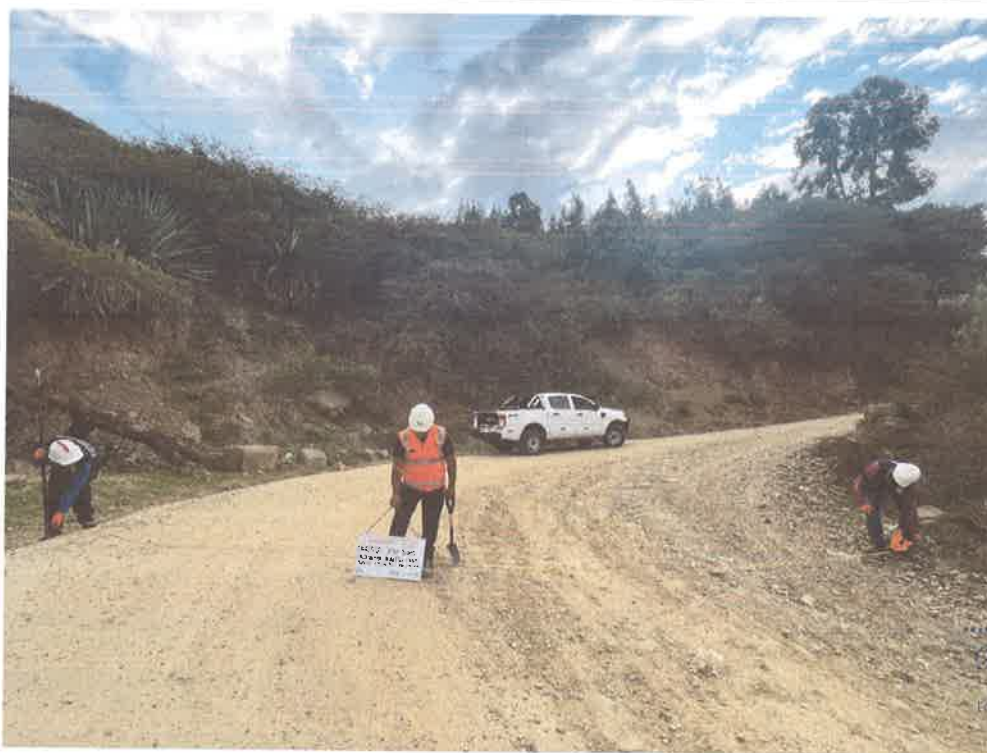
FOTO N° 20: MEDIDA DE ANCHO DE VIA
