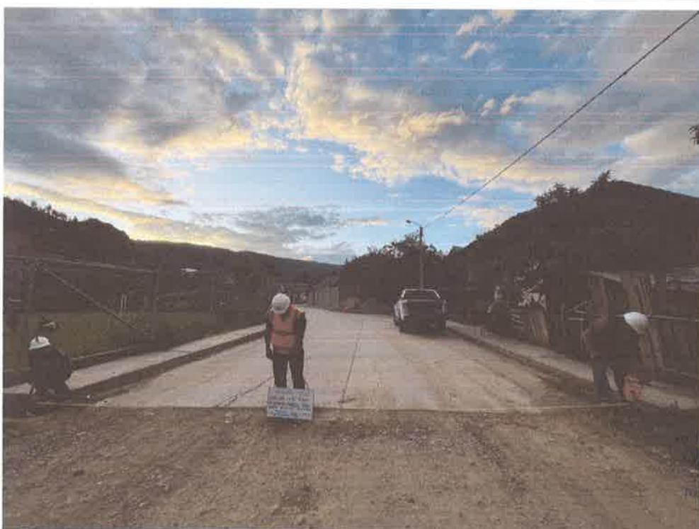
FOTO N° 24: MEDIDA DE ANCHO DE VIA
