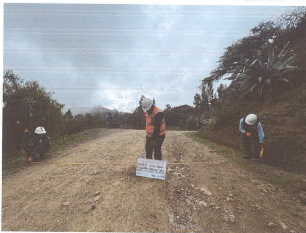
FOTO N° 28: MEDIDA DE ANCHO DE VIA
