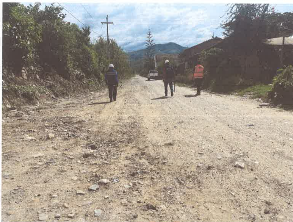
FOTO N° 01: EROSIÓN DEL AFIRMADO
