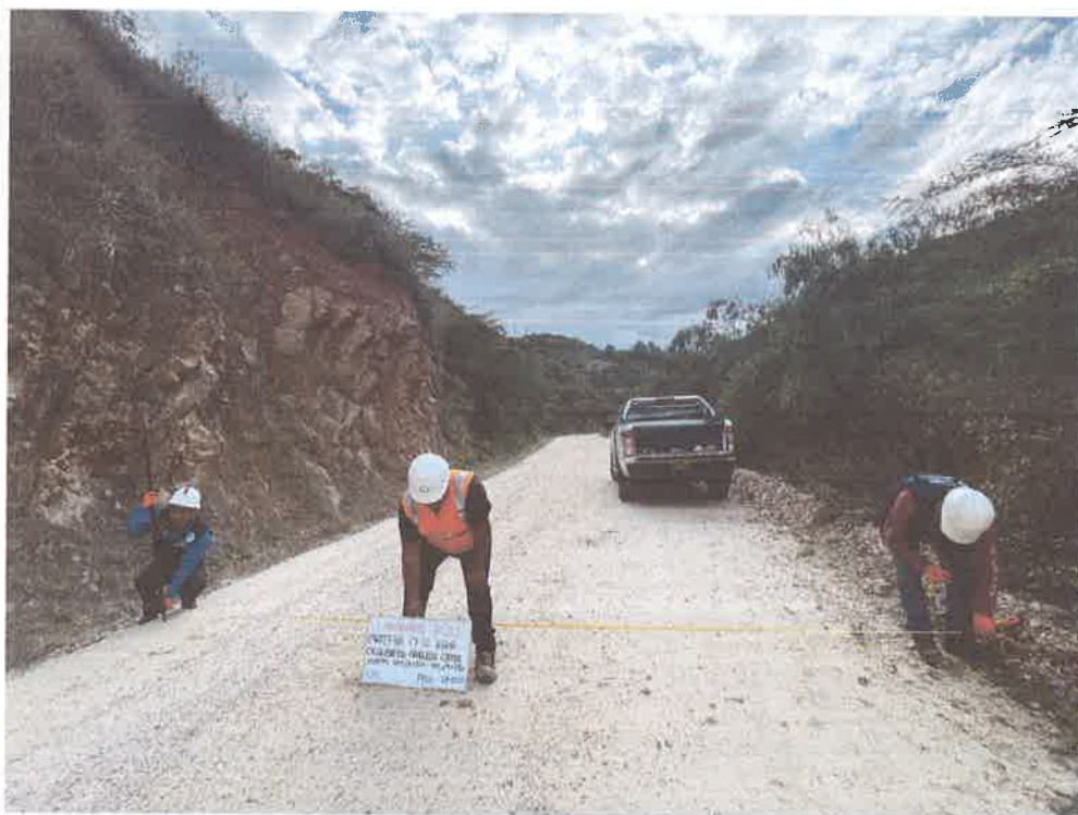
FOTO N° 16: MEDIDA DE ANCHO DE VIA
