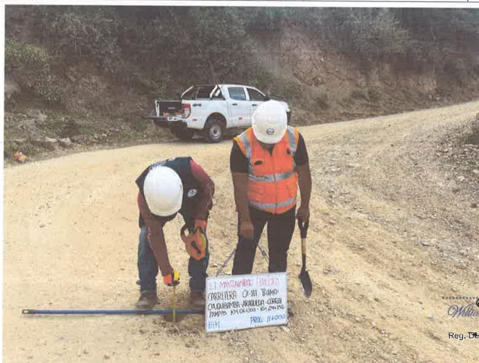
FOTO N° 20: MEDICIÓN DE ESPESOR DE AFIRMADO
