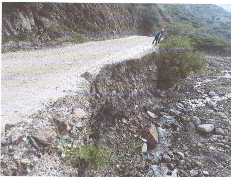
Figura n° 1: Socavamiento de la rasante, km 09+920 al 09+930 (13 m)
