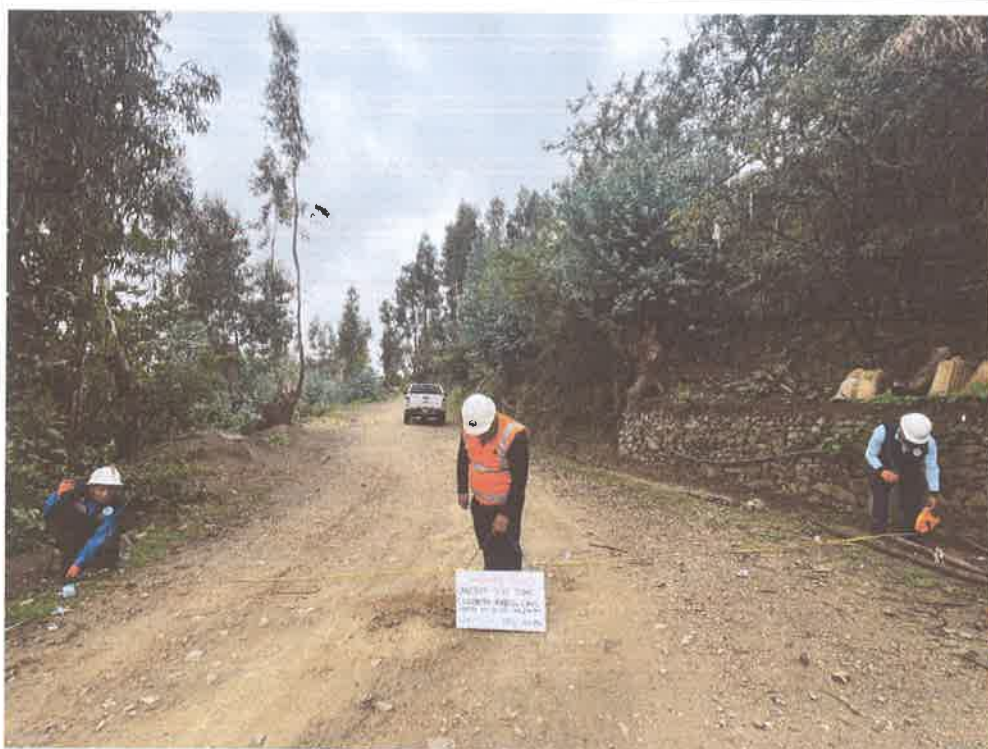
FOTO N° 26: MEDIDA DE ANCHO DE VIA
