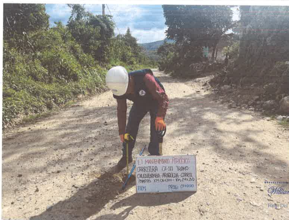
FOTO N° 04: MEDICIÓN DE ESPESOR DE AFIRMADO
