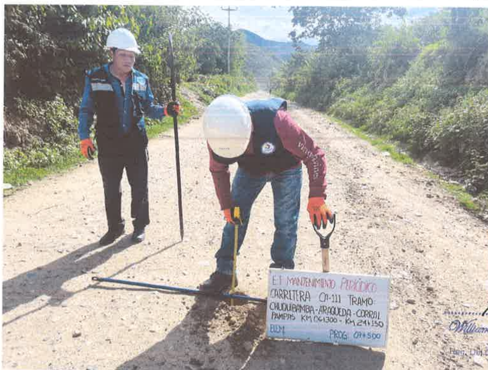
FOTO N° 06: MEDICIÓN DE ESPESOR DE AFIRMADO
