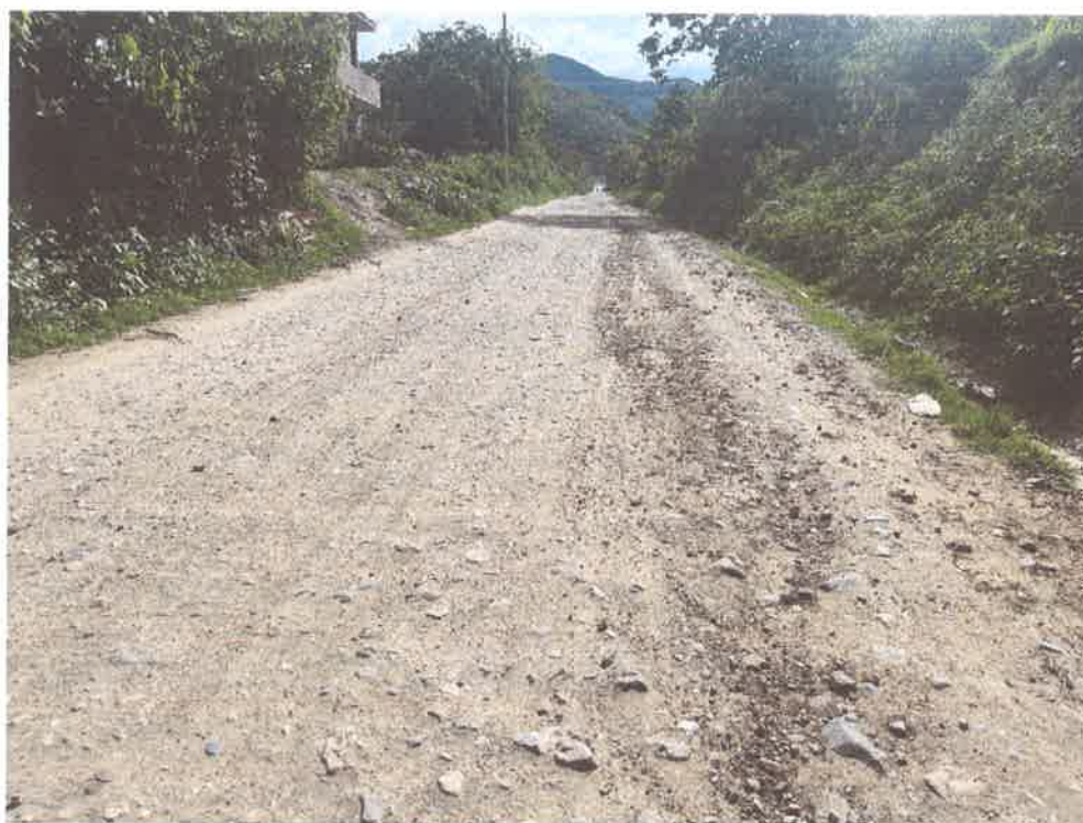
FOTO N° 07: EROSIÓN DEL AFIRMADO
