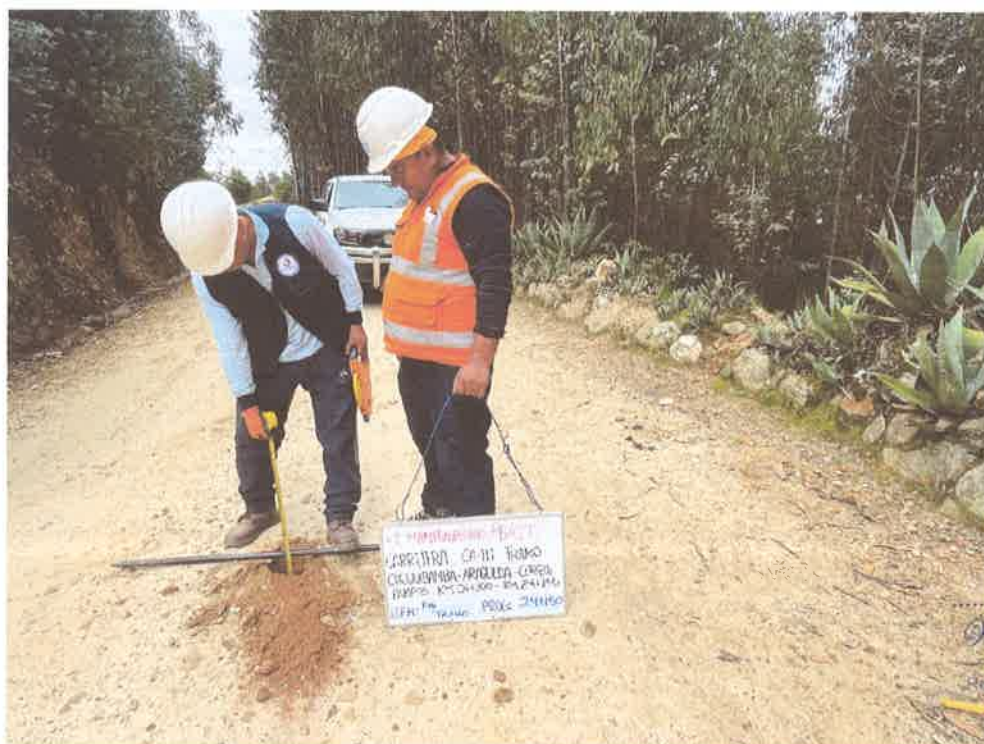
FOTO N° 74: MEDICIÓN DE ESPESOR DE AFIRMADO
