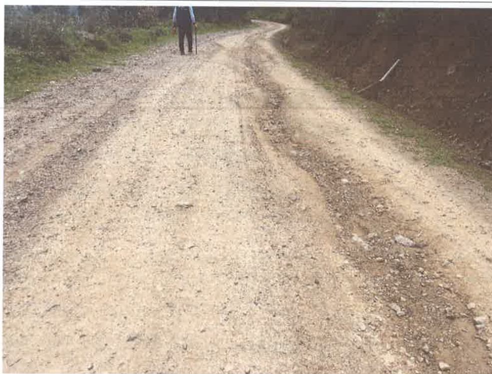
FOTO N° 20: EROSIÓN DEL AFIRMADO
