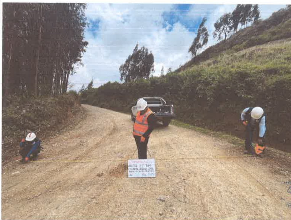
FOTO N° 58: MEDIDA DE ANCHO DE VIA
