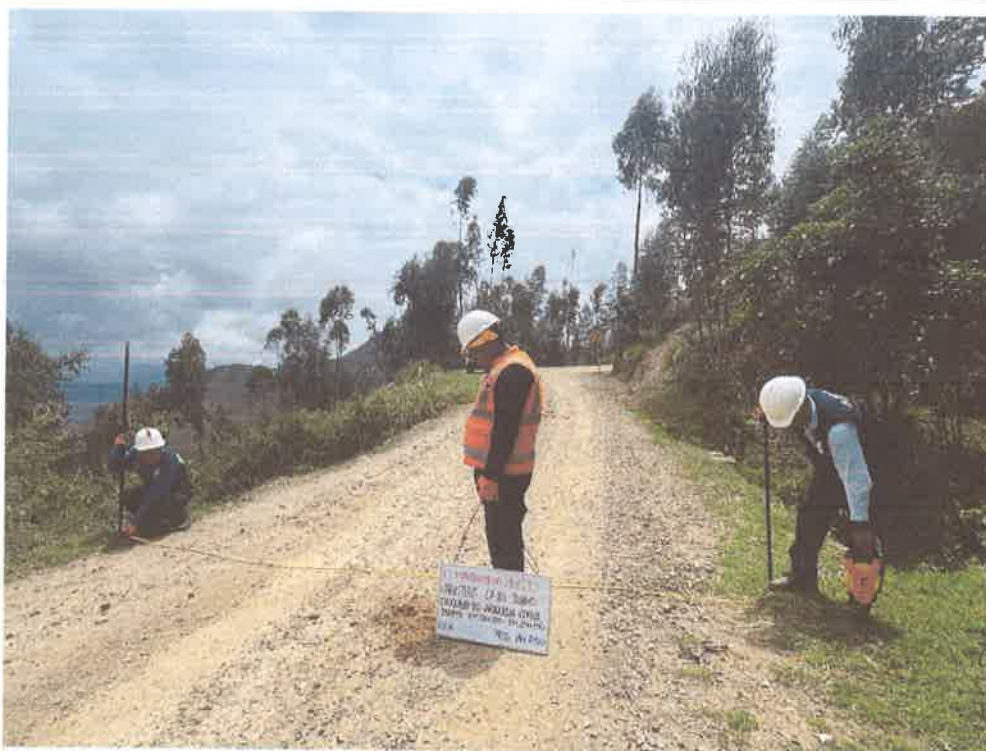
FOTO N° 54: MEDIDA DE ANCHO DE VIA
