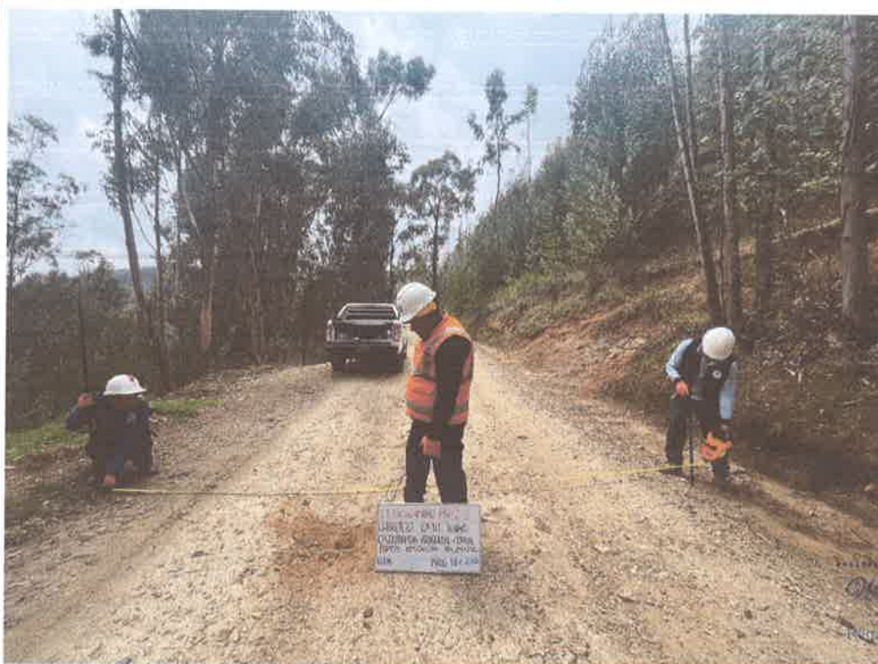
FOTO N° 50: MEDIDA DE ANCHO DE VIA
