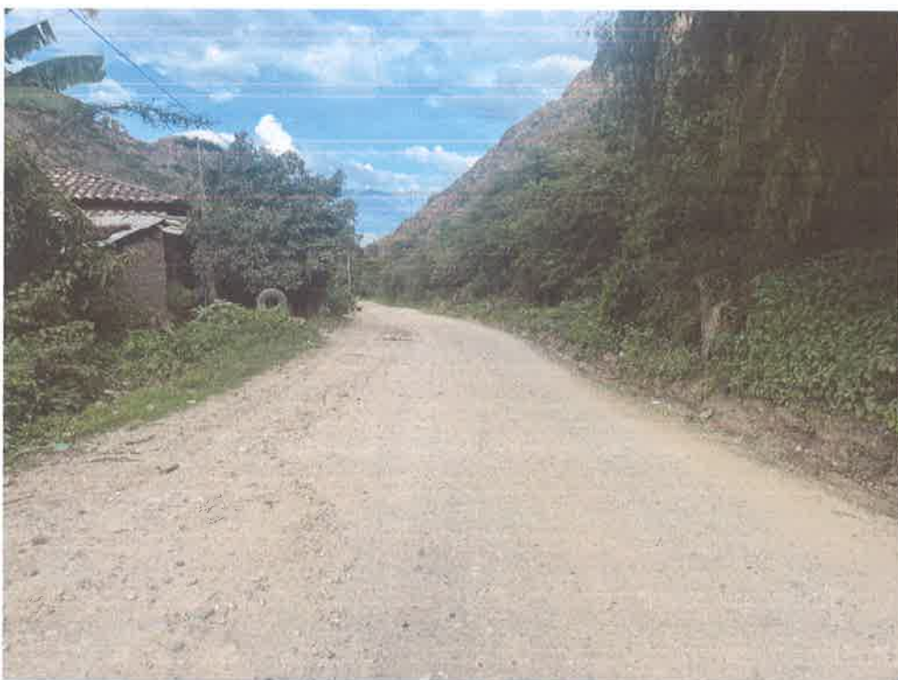
FOTO N° 10: EROSIÓN DEL AFIRMADO
