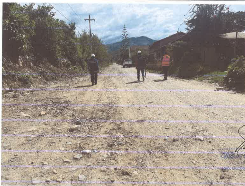
FOTO N° 03: EROSIÓN DEL AFIRMADO
