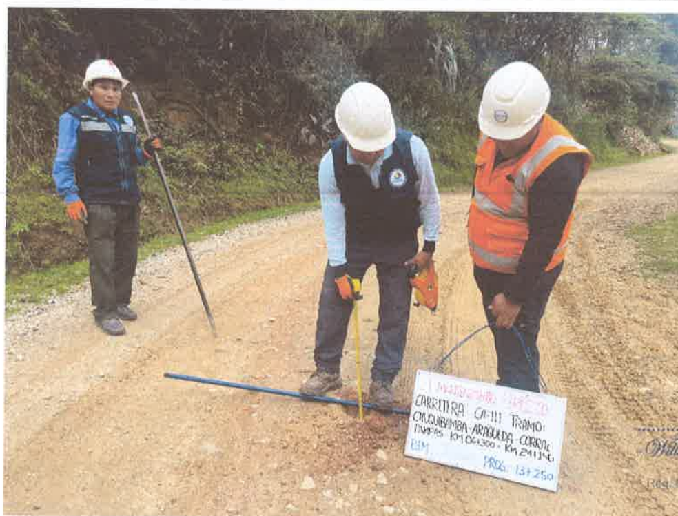
FOTO N° 30: MEDICIÓN DE ESPESOR DE AFIRMADO
