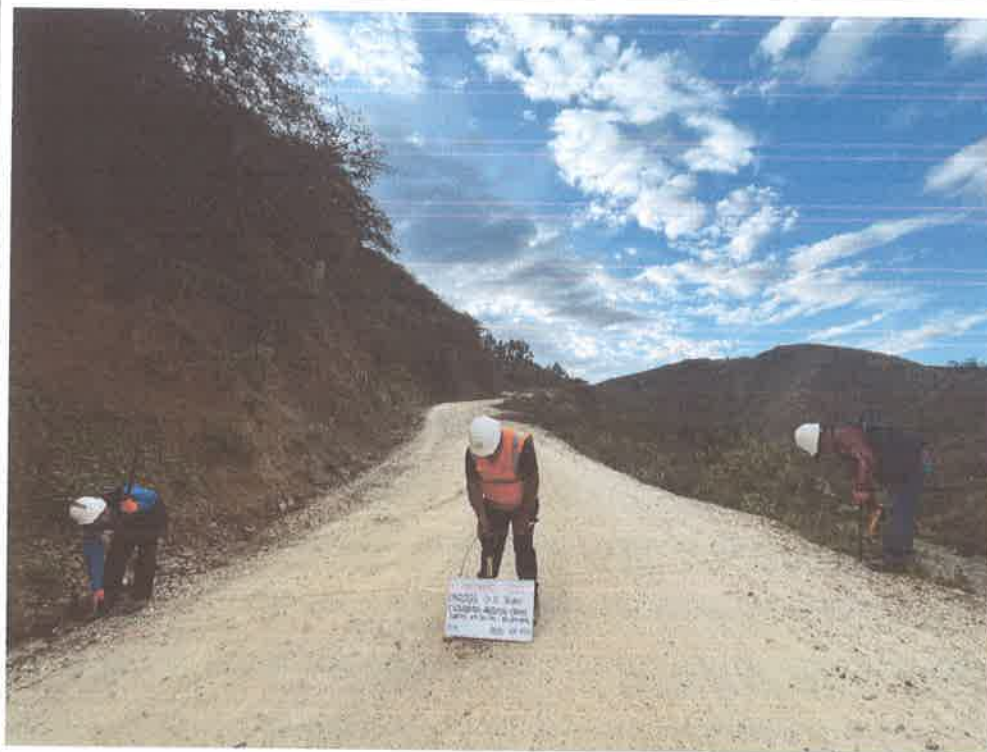
FOTO N° 19: MEDIDA DE ANCHO DE VIA
