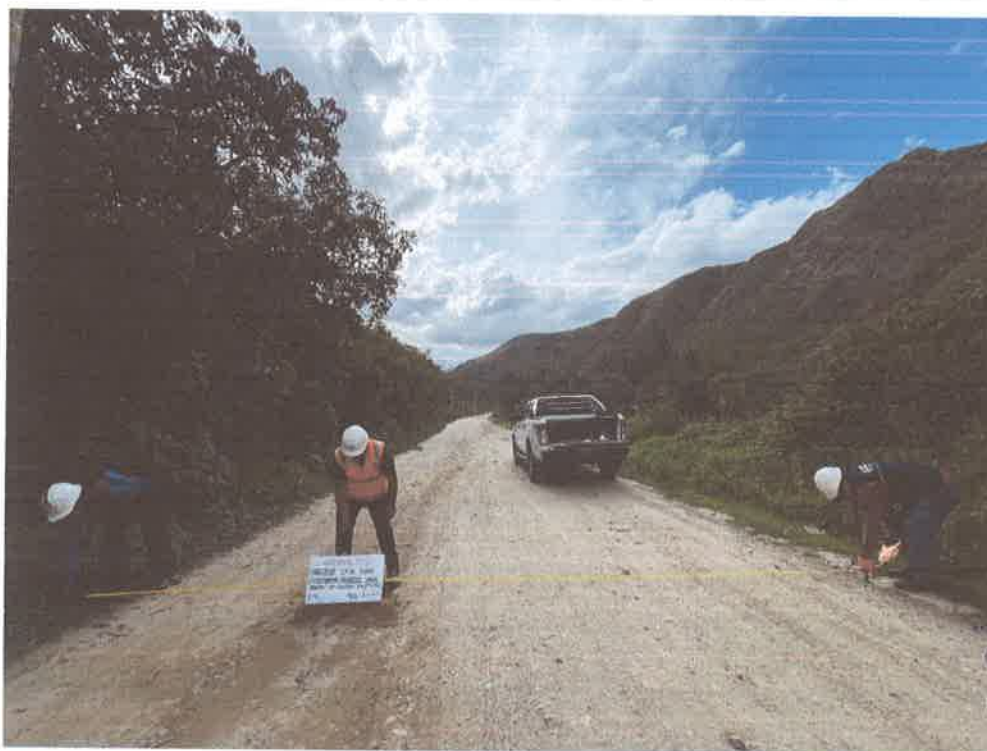
FOTO N° 10: MEDIDA DE ANCHO DE VIA
