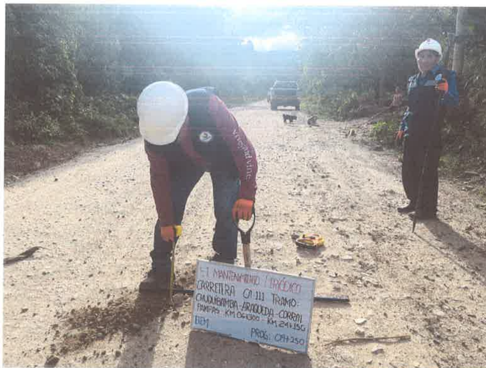
FOTO N° 13: MEDICIÓN DE ESPESOR DE AFIRMADO
