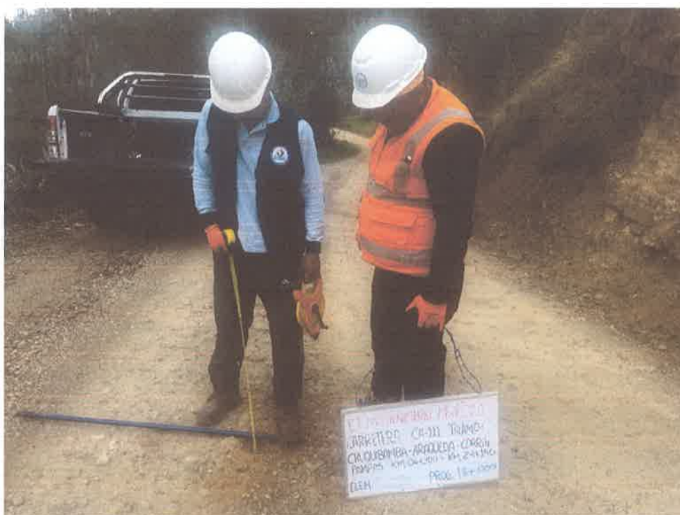
FOTO N° 49: MEDICIÓN DE ESPESOR DE AFIRMADO
