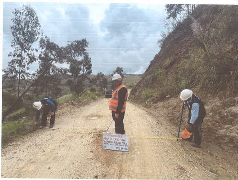
FOTO N° 55: MEDIDA DE ANCHO DE VIA
