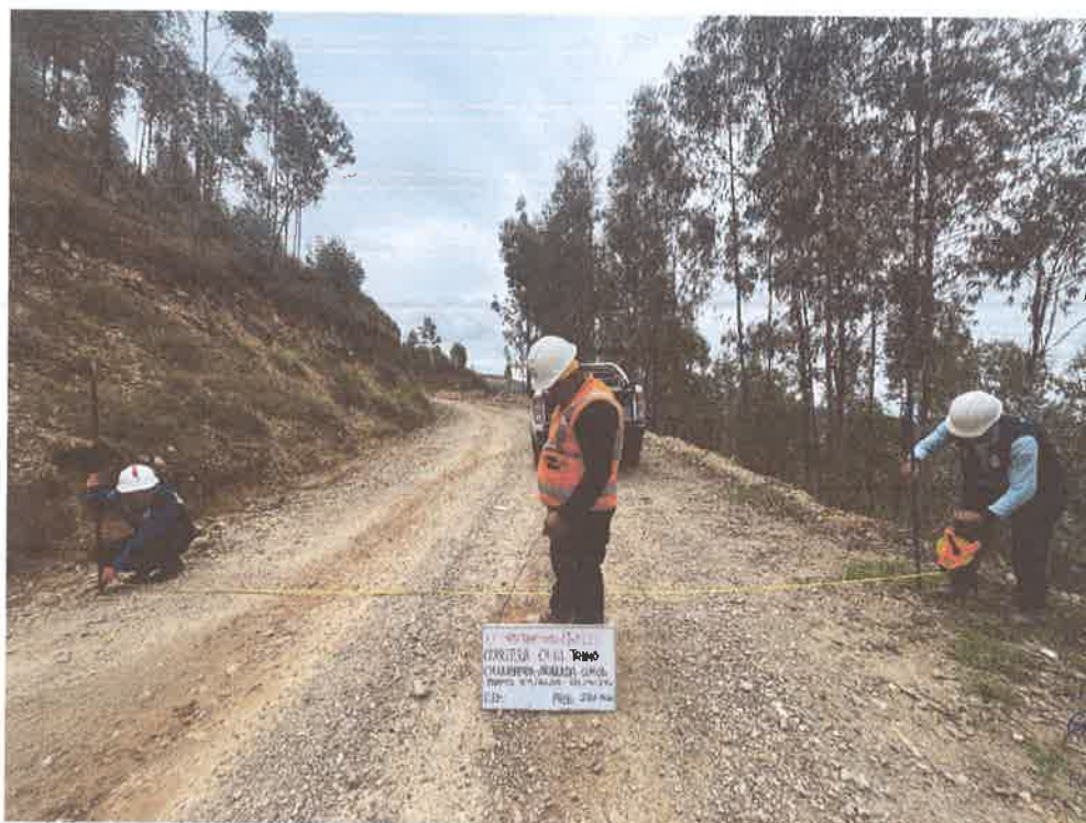
FOTO N° 64: MEDIDA DE ANCHO DE VIA
