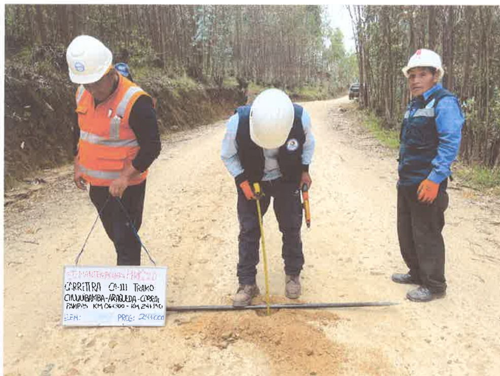
FOTO N° 73: MEDICIÓN DE ESPESOR DE AFIRMADO
