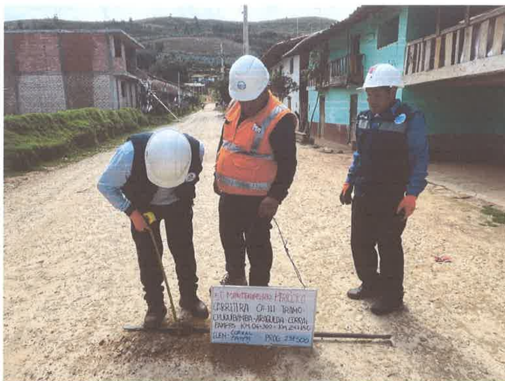
FOTO N° 71: MEDICIÓN DE ESPESOR DE AFIRMADO
