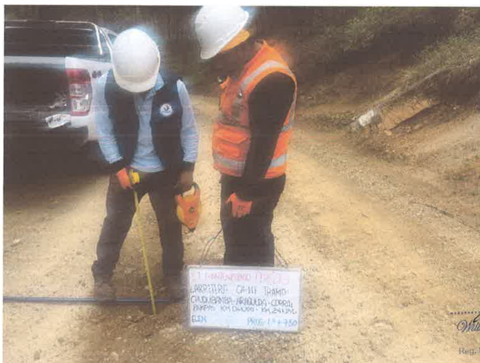
FOTO N° 48: MEDICIÓN DE ESPESOR DE AFIRMADO
