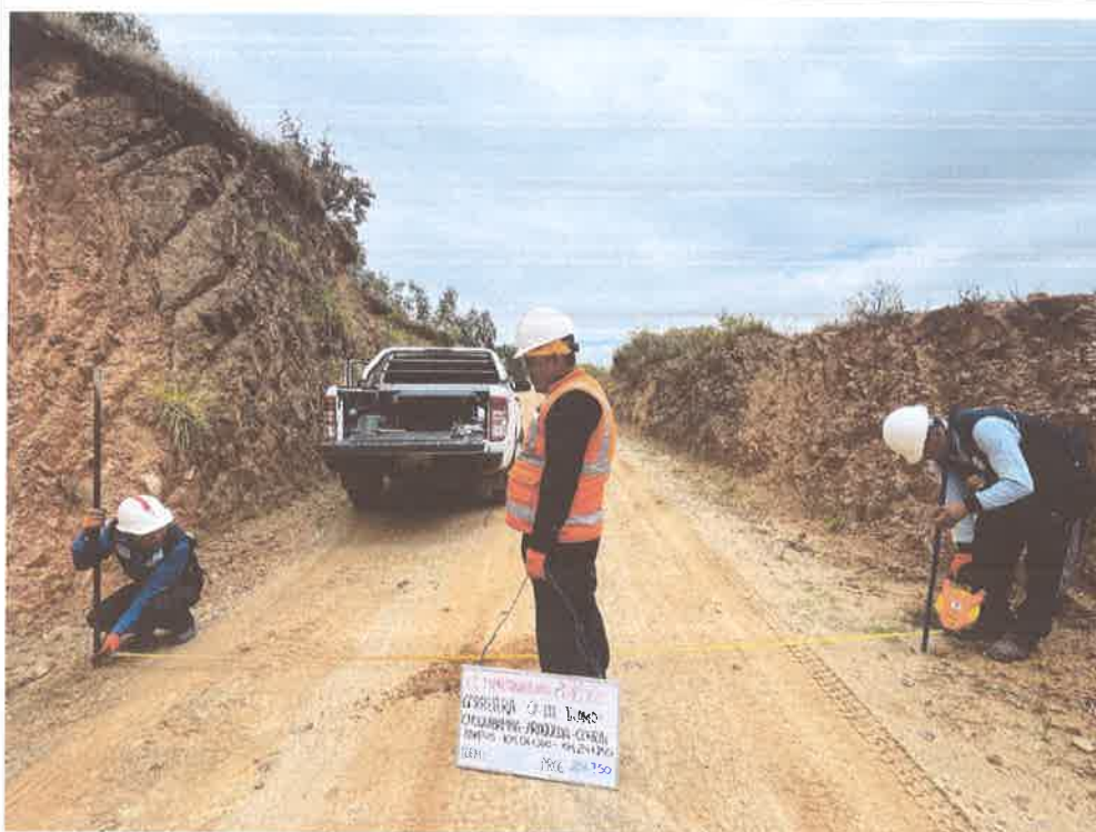
FOTO N° 60: MEDIDA DE ANCHO DE VIA
