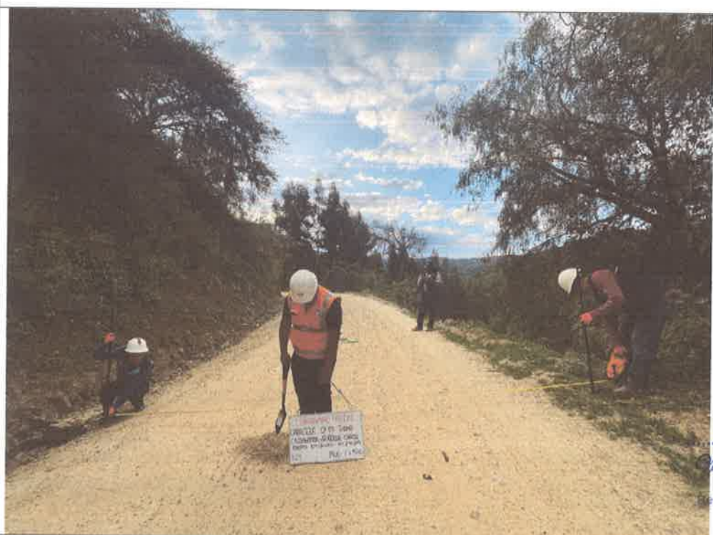
FOTO N° 22: MEDIDA DE ANCHO DE VIA
