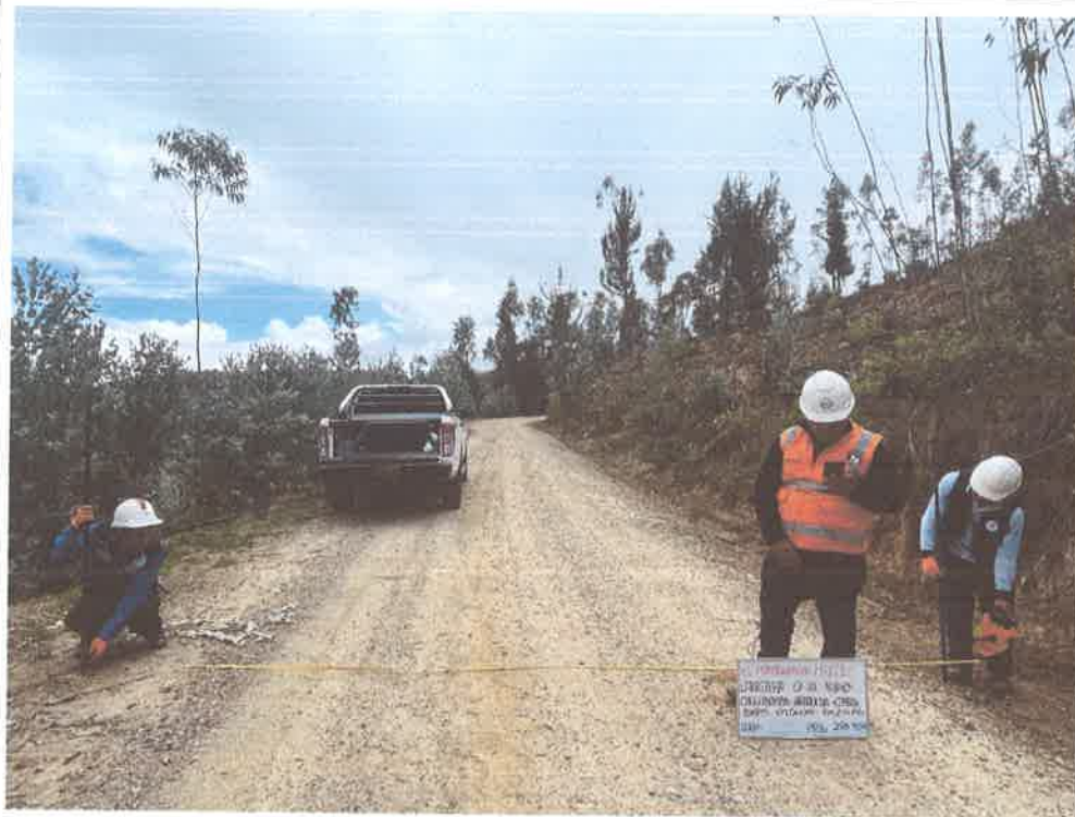
FOTO N° 65: MEDIDA DE ANCHO DE VIA
