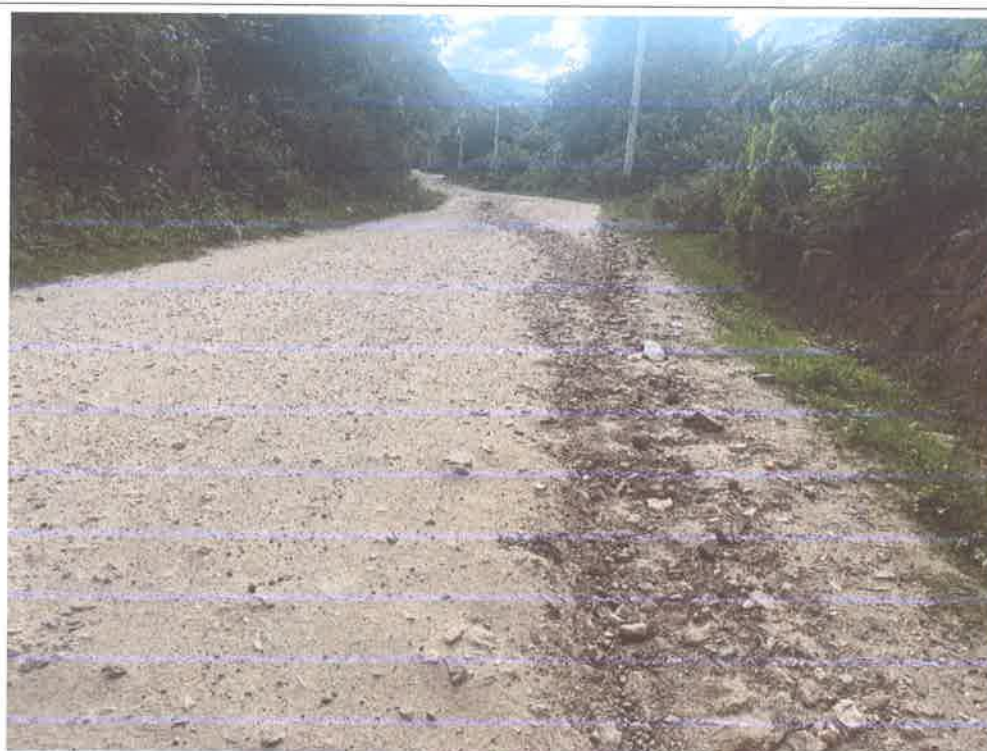
FOTO N° 04: EROSIÓN DEL AFIRMADO
