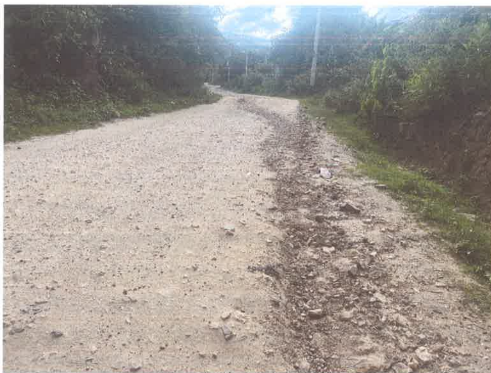
FOTO N° 09: EROSIÓN DEL AFIRMADO
