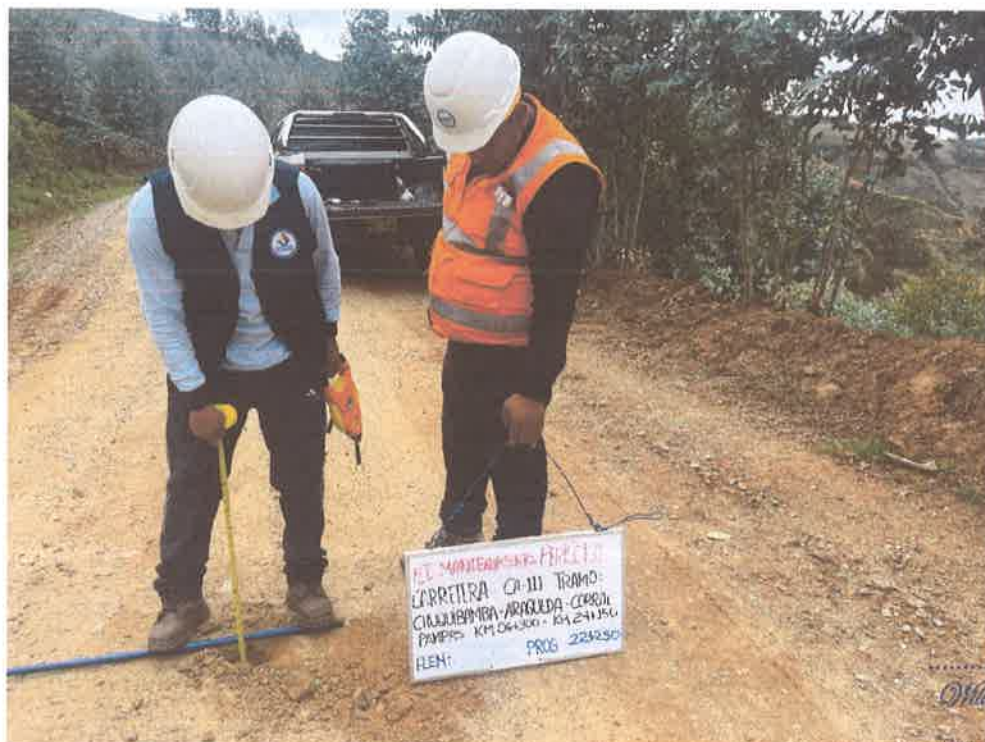
FOTO N° 66: MEDICIÓN DE ESPESOR DE AFIRMADO
