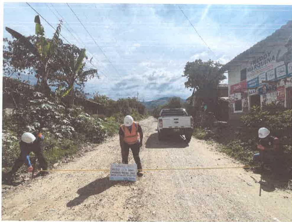
FOTO N° 03: MEDIDA DE ANCHO DE VIA
