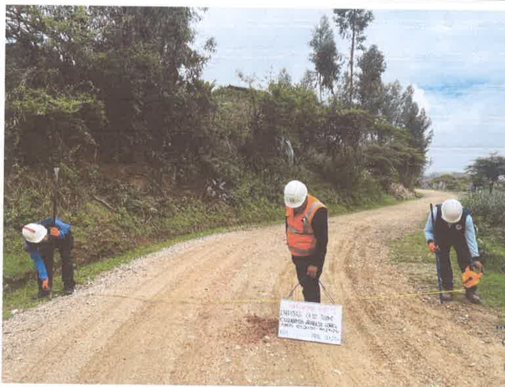
FOTO N° 30: MEDIDA DE ANCHO DE VIA
