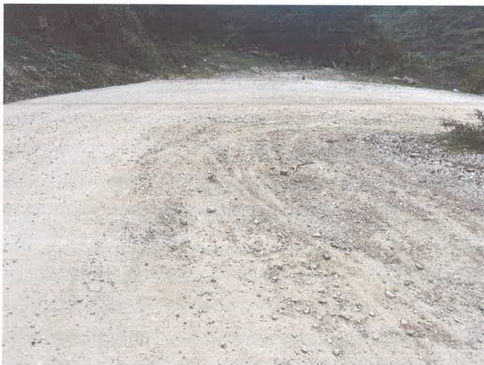
FOTO N° 12: EROSIÓN DEL AFIRMADO
