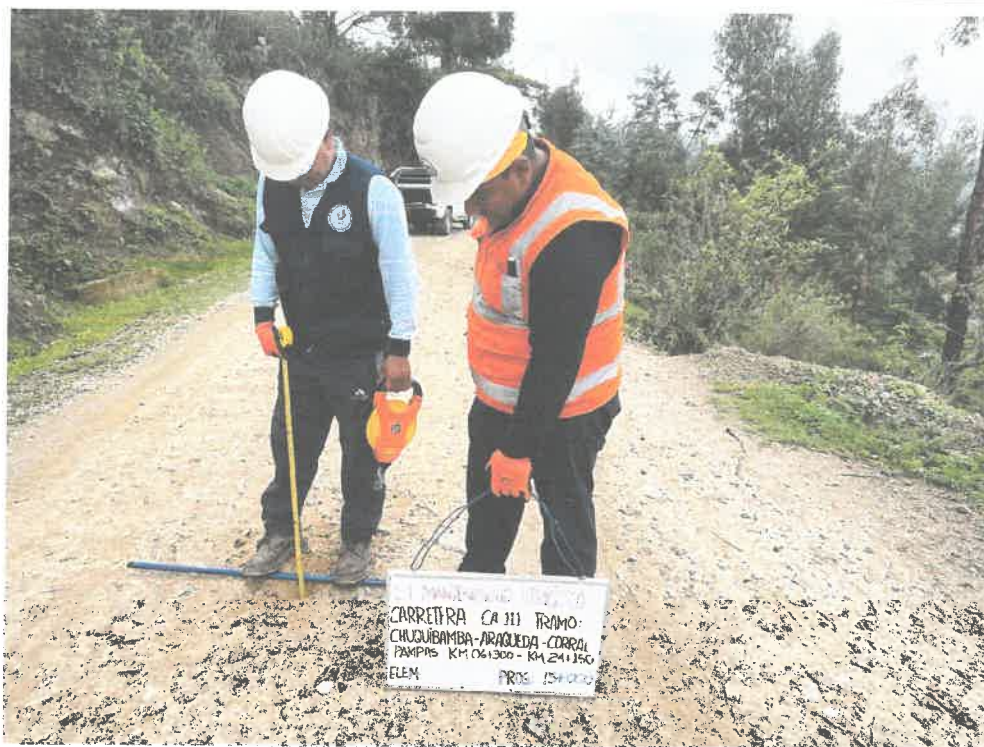
FOTO N° 37: MEDICIÓN DE ESPESOR DE AFIRMADO
