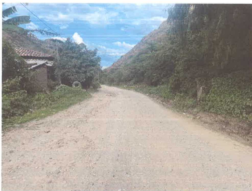
FOTO N° 11: EROSIÓN DEL AFIRMADO
