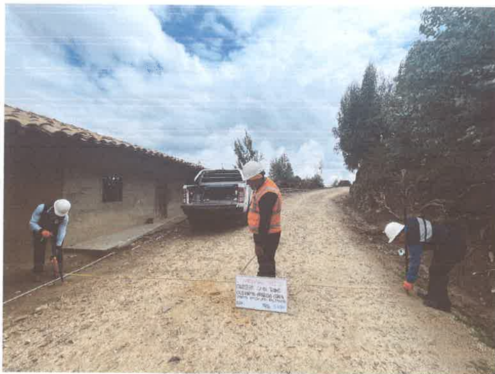
FOTO N° 39: MEDIDA DE ANCHO DE VIA
