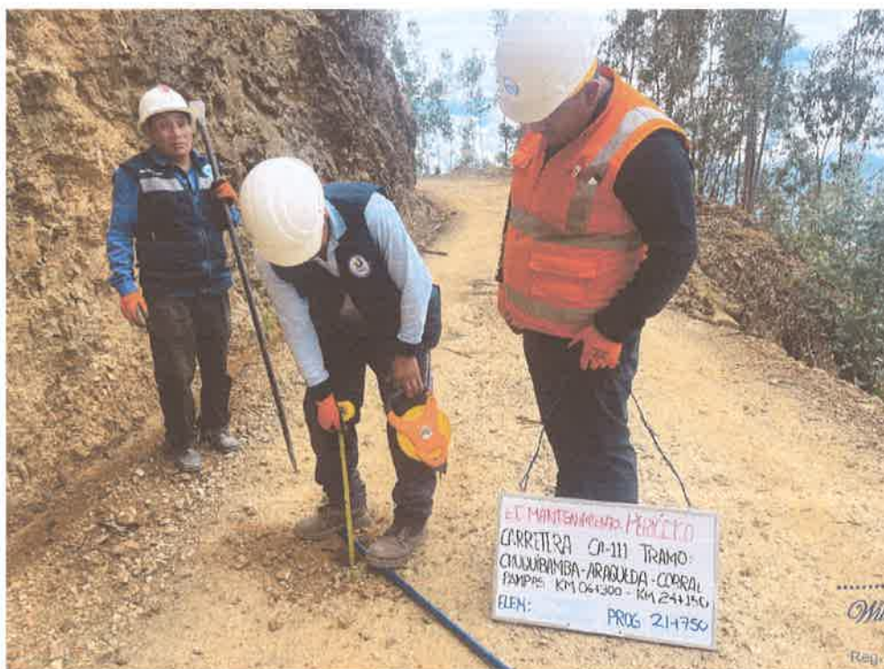
FOTO N° 64: MEDICIÓN DE ESPESOR DE AFIRMADO
