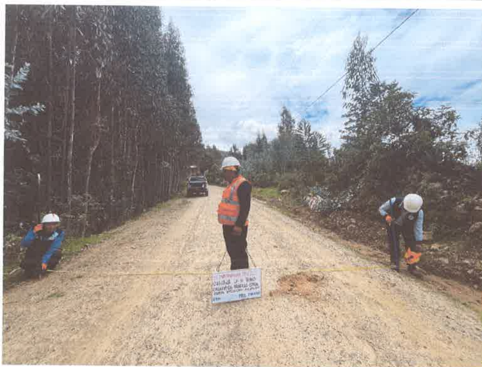
FOTO N° 68: MEDIDA DE ANCHO DE VIA
