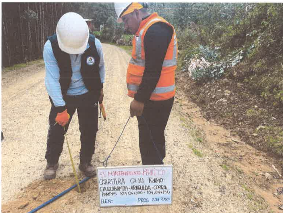
FOTO N° 70: MEDICIÓN DE ESPESOR DE AFIRMADO
