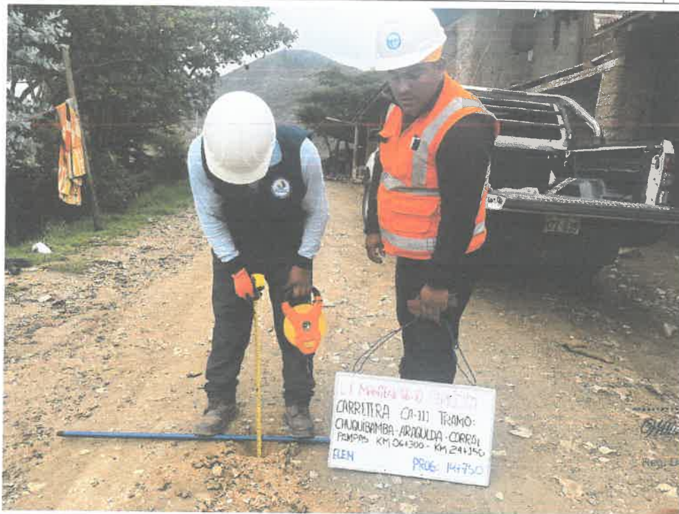
FOTO N° 36: MEDICIÓN DE ESPESOR DE AFIRMADO
