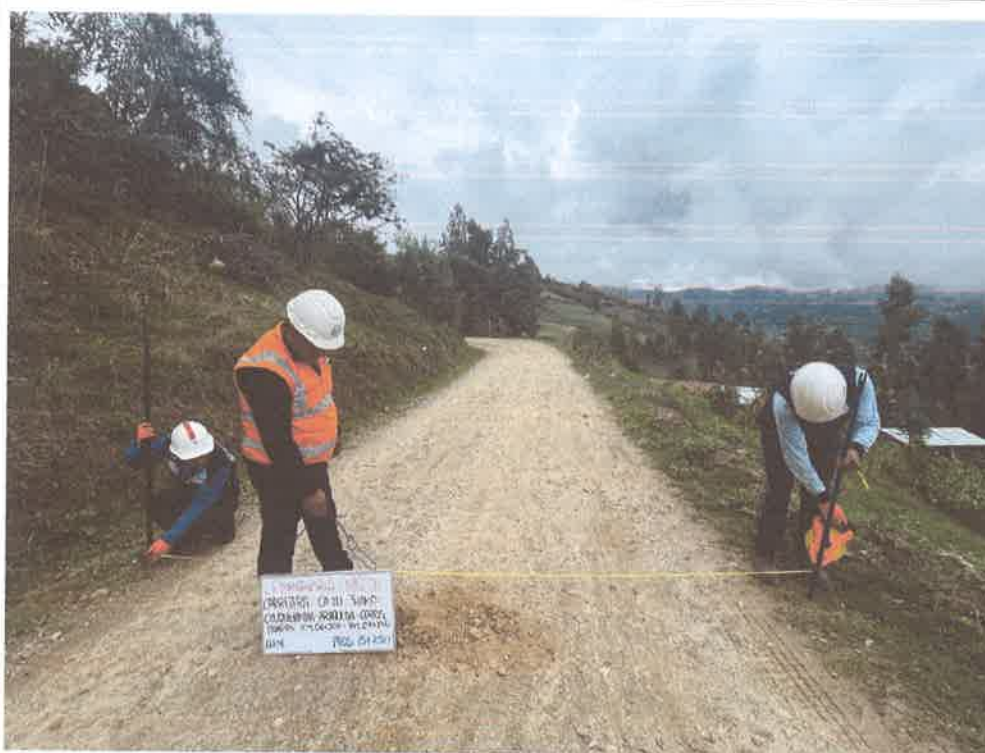
FOTO N° 38: MEDIDA DE ANCHO DE VIA
