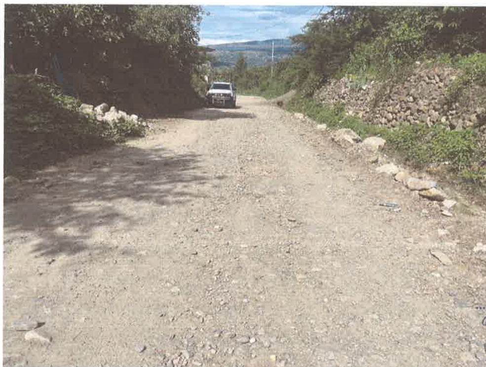
FOTO N° 06: EROSIÓN DEL AFIRMADO
