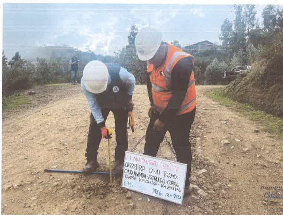
FOTO N° 28: MEDICIÓN DE ESPESOR DE AFIRMADO
