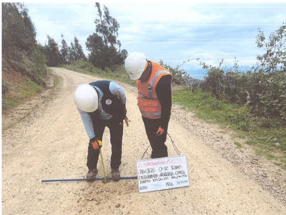
FOTO N° 57: MEDICIÓN DE ESPESOR DE AFIRMADO
