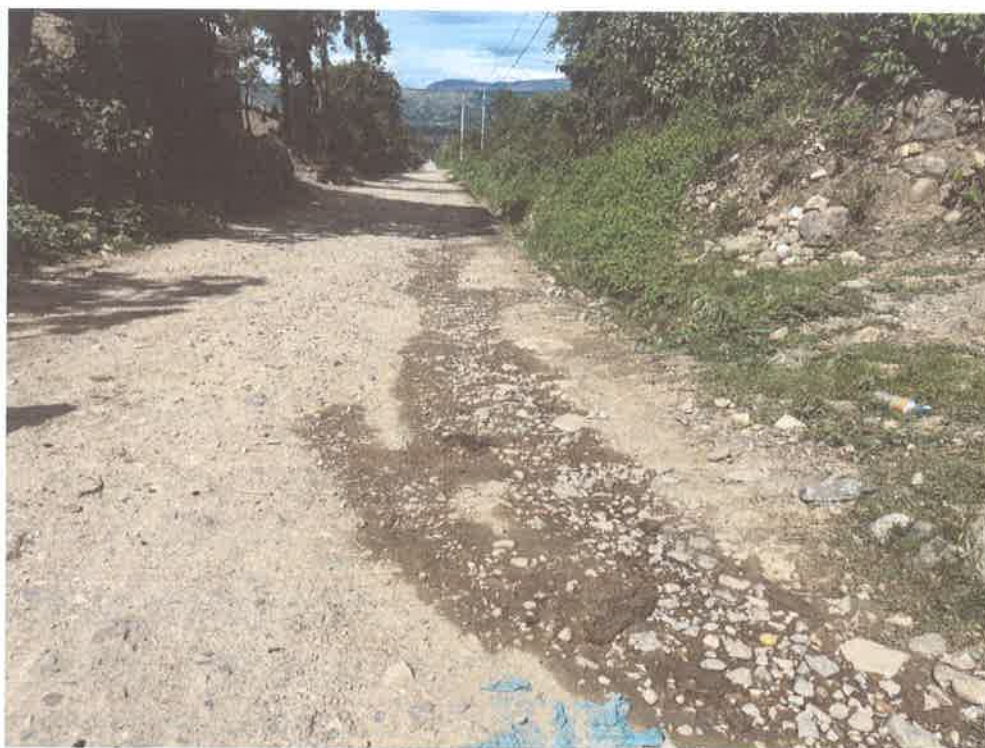
FOTO N° 05: EROSIÓN DEL AFIRMADO
