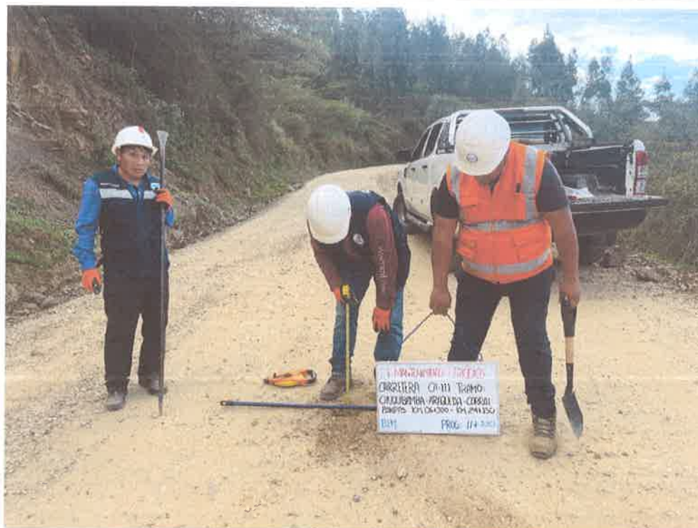
FOTO N° 21: MEDICIÓN DE ESPESOR DE AFIRMADO
