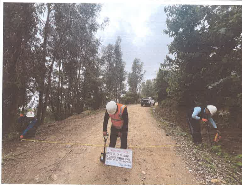
FOTO N° 27: MEDIDA DE ANCHO DE VIA
