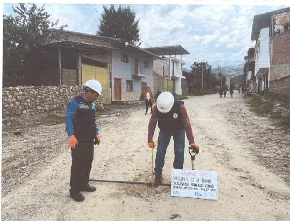
FOTO N° 01: MEDICIÓN DE ESPESOR DE AFIRMADO
