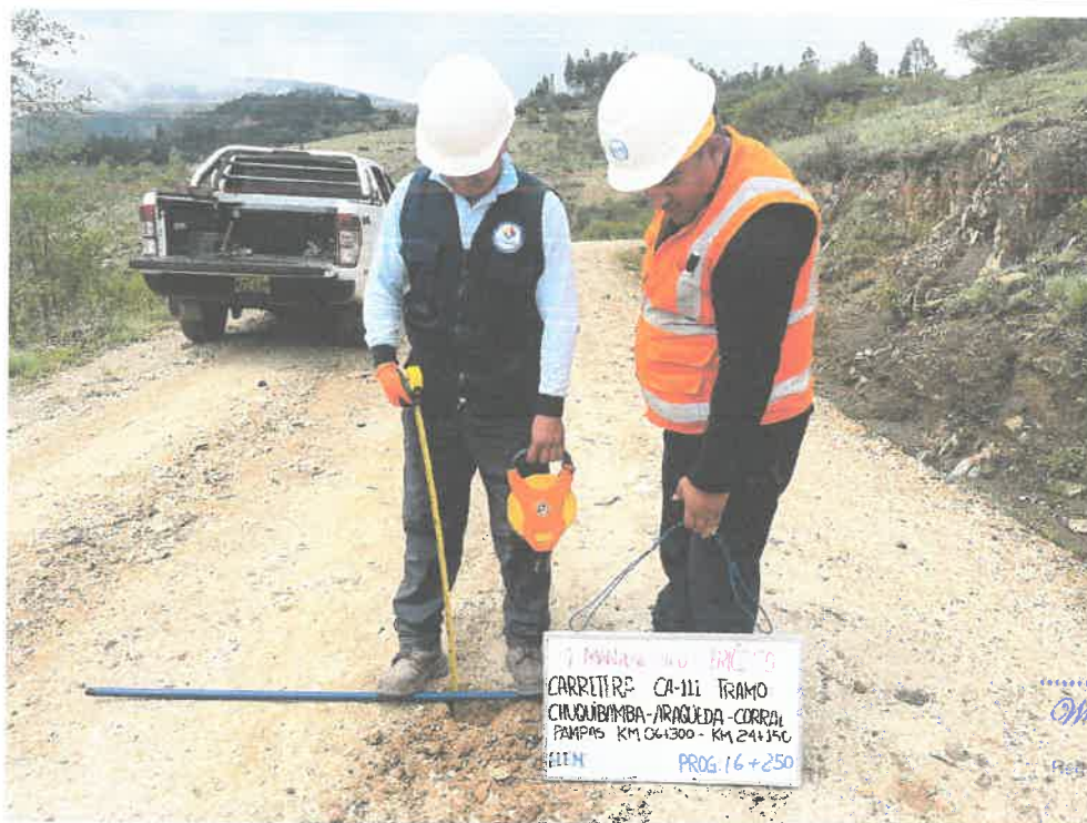
FOTO N° 42: MEDICIÓN DE ESPESOR DE AFIRMADO
