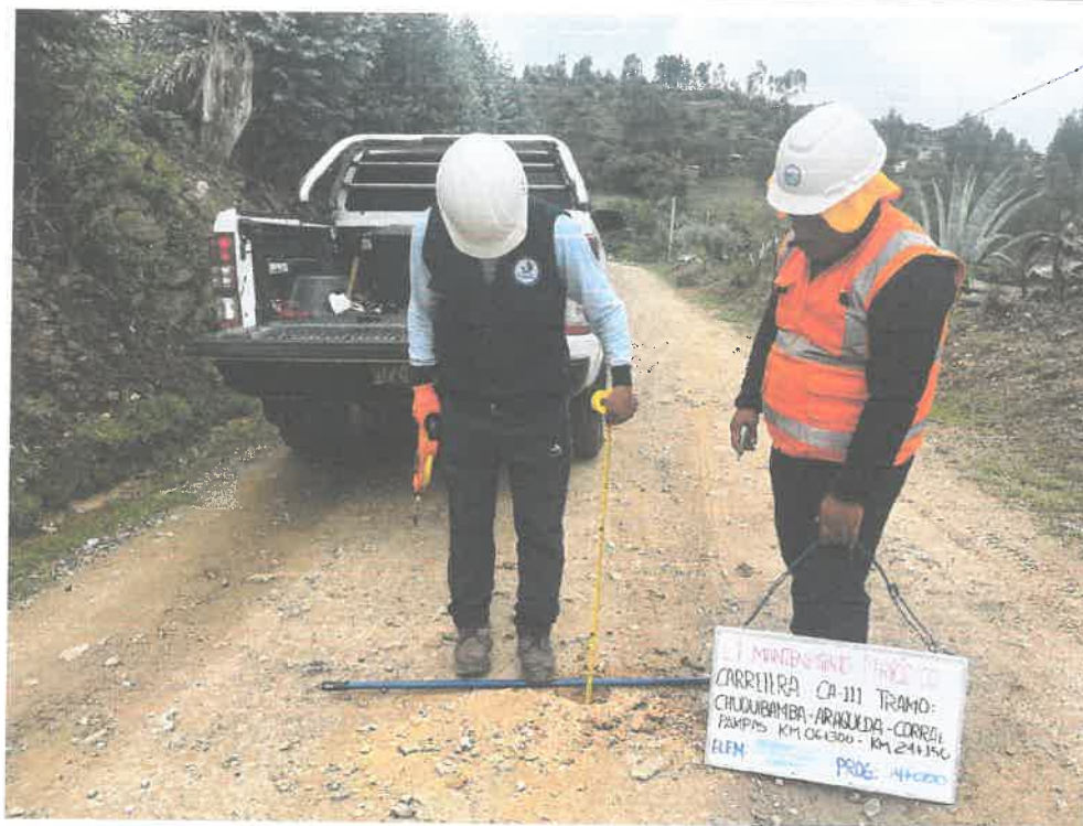
FOTO N° 33: MEDICIÓN DE ESPESOR DE AFIRMADO
