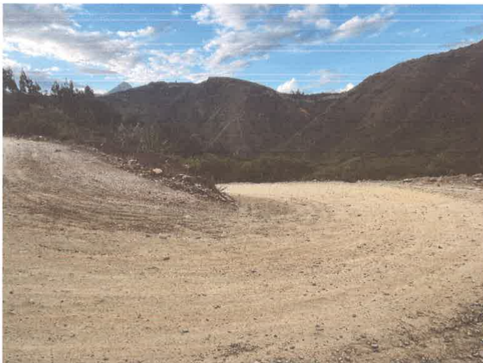
FOTO N° 14: EROSIÓN DEL AFIRMADO
