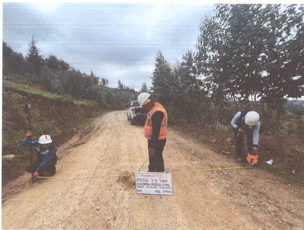
FOTO N° 65: MEDIDA DE ANCHO DE VIA
