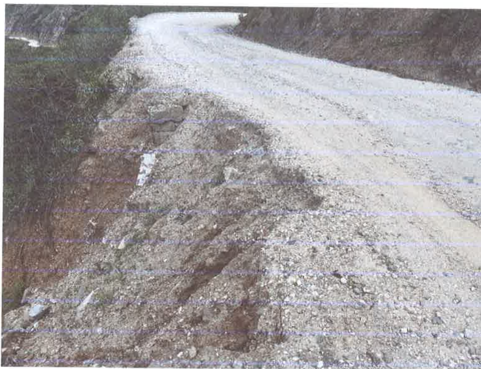
Figura n° 2: Socavamiento de la rasante, km 10+760 al 10+766.70 (6.70 m)
