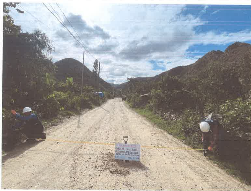
FOTO N° 09: MEDIDA DE ANCHO DE VIA
