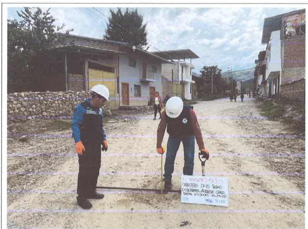
FOTO N° 01: MEDICIÓN DE ESPESOR DE AFIRMADO
