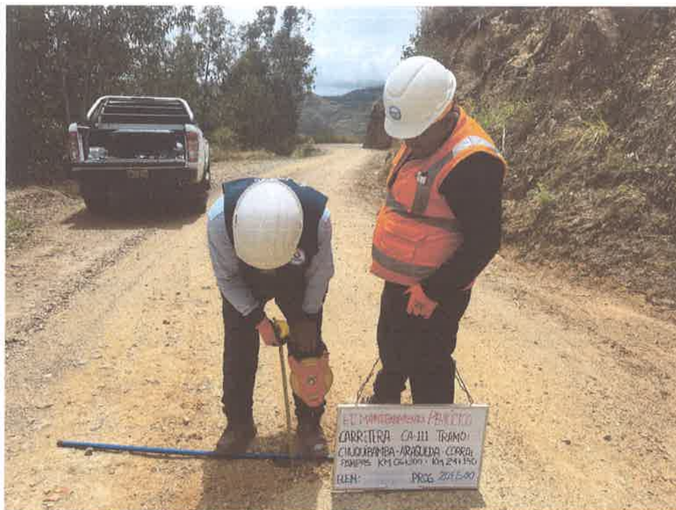
FOTO N° 59: MEDICIÓN DE ESPESOR DE AFIRMADO
