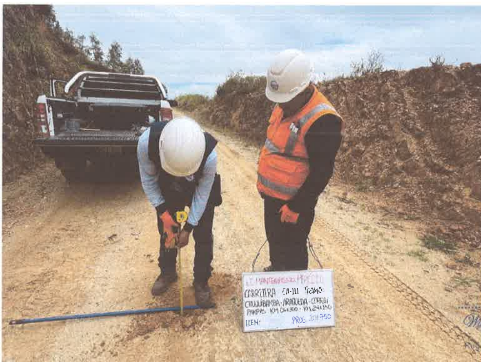
FOTO N° 60: MEDICIÓN DE ESPESOR DE AFIRMADO
