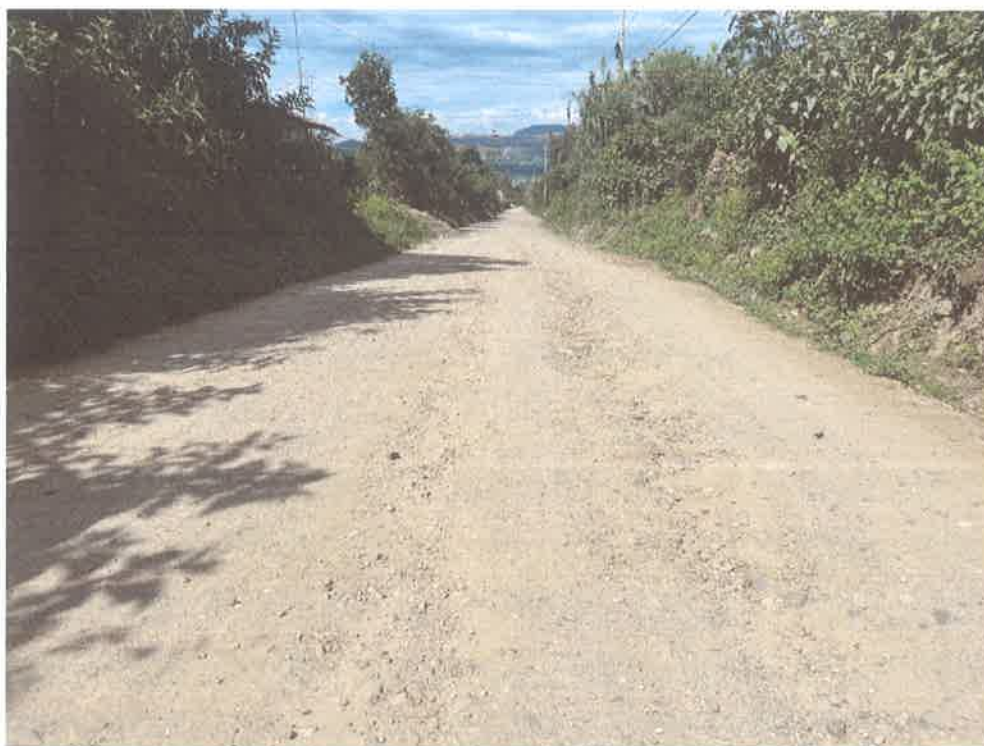
FOTO N° 03: EROSIÓN DEL AFIRMADO
