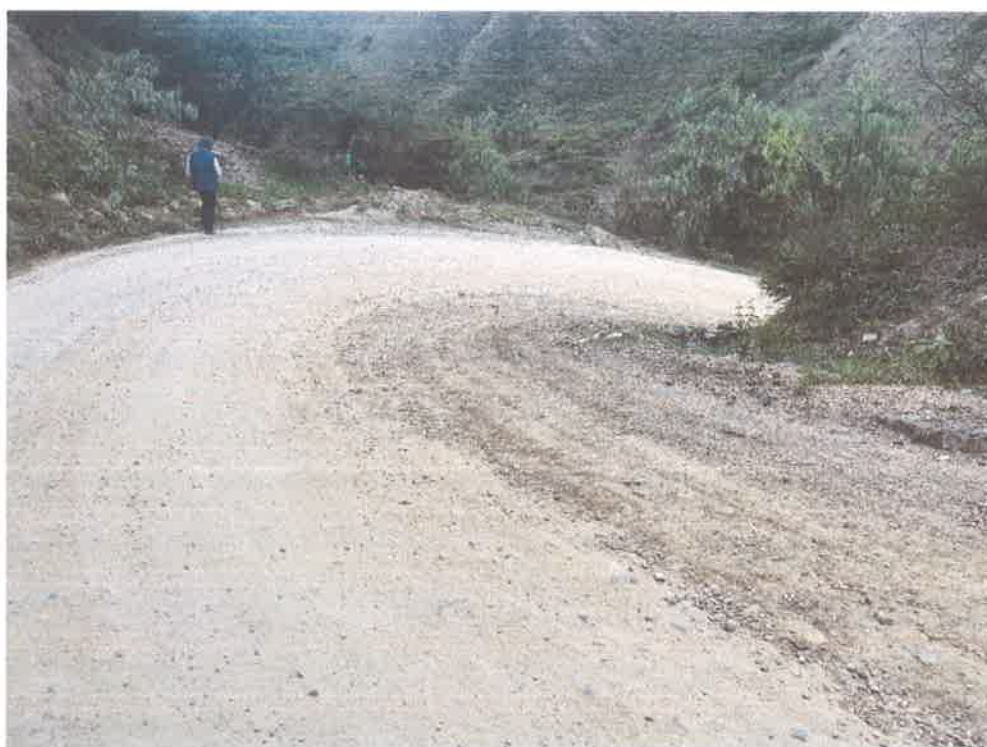
FOTO N° 13: EROSIÓN DEL AFIRMADO
