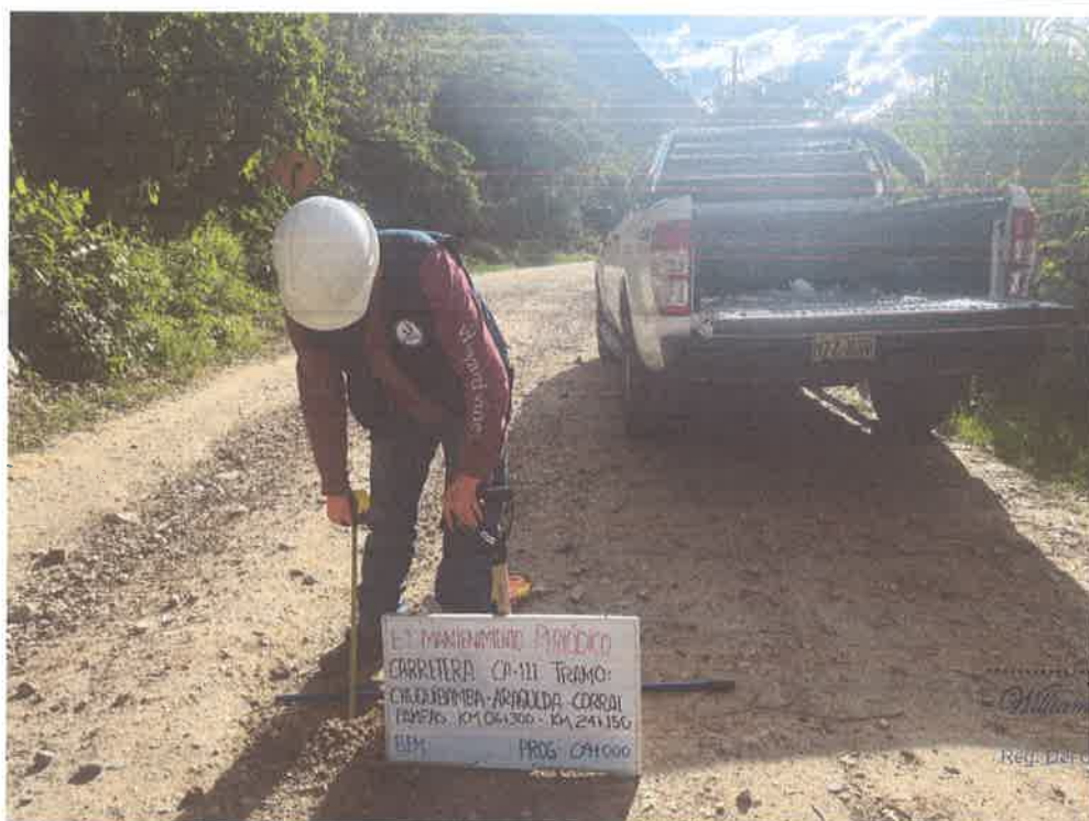
FOTO N° 12: MEDICIÓN DE ESPESOR DE AFIRMADO
