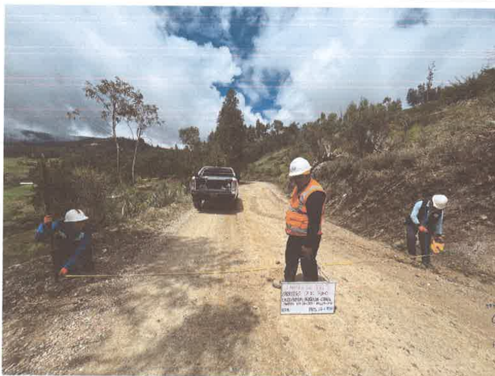
FOTO N° 44: MEDIDA DE ANCHO DE VIA
