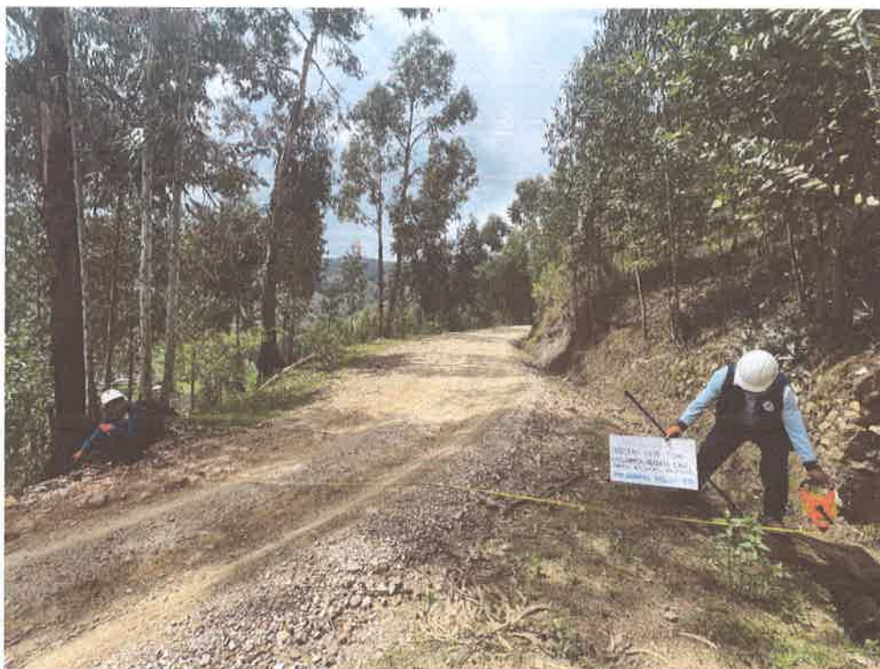
FOTO N° 17: EROSIÓN DEL AFIRMADO
