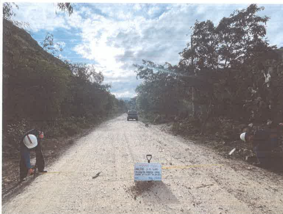
FOTO N° 13: MEDIDA DE ANCHO DE VIA
