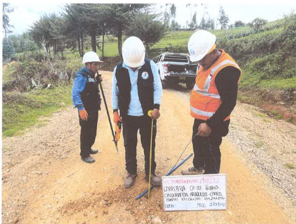
FOTO N° 67: MEDICIÓN DE ESPESOR DE AFIRMADO
