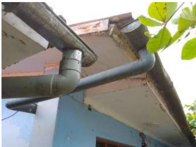
Vista del pésimo estado de conservación de las canaletas. Se plantea cambio. ambiente residencia
