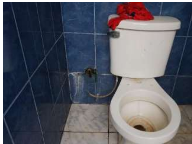
Vista del chicote del inodoro desprendido. Se plantea su cambio. Baño para uso de pacientes
