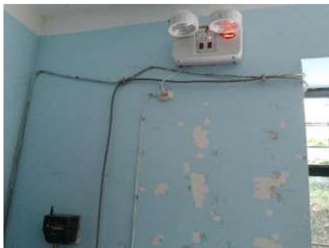
Vista de instalación eléctrica provisional, pintura exfoliada. Se plantea la reinstalación. Ambiente de cadena de frío.
