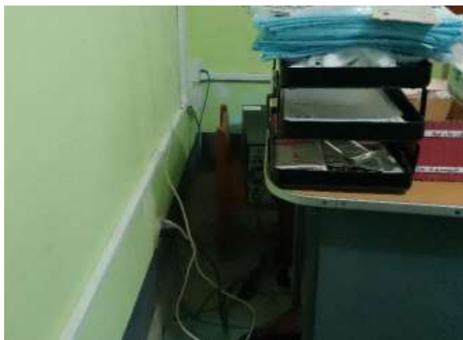
Vista del cableado saturado con varios puntos. Se plantea la reinstalación de forma correcta. Ambiente Obstetricia
