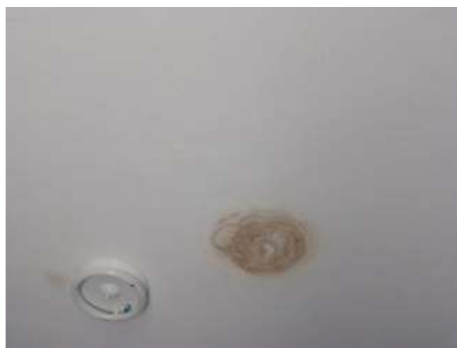
Vista de mancha en el cielo raso, ocasionado por la humedad. Se plantea repintado. Ambiente sala de parto.
