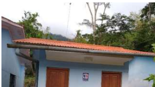
Vista de la canaleta con corrosión y desprendimiento. Se plantea cambio. Ambiente baño de profesionales
