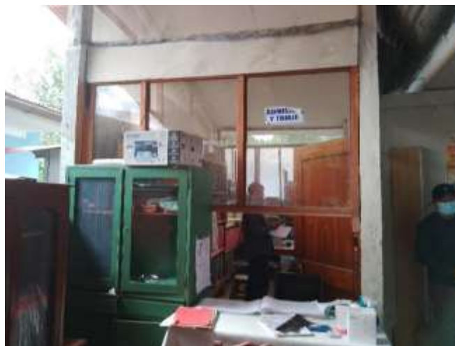
Vista donde se aprecia la ausencia de vidrio en la venta principal de admisión. Se plantea reposición.
