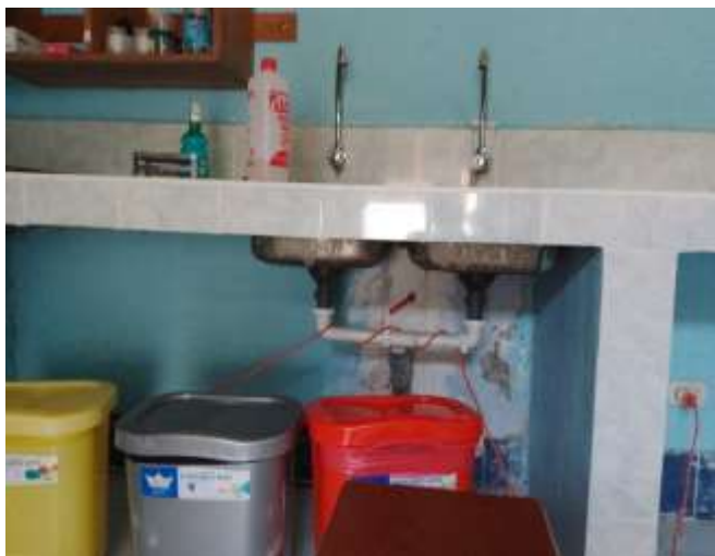
Vista donde se aprecia tubería de trampa y grifos tipo gancho del lavatorio dañados. Se plantea su cambio. Laboratorio
