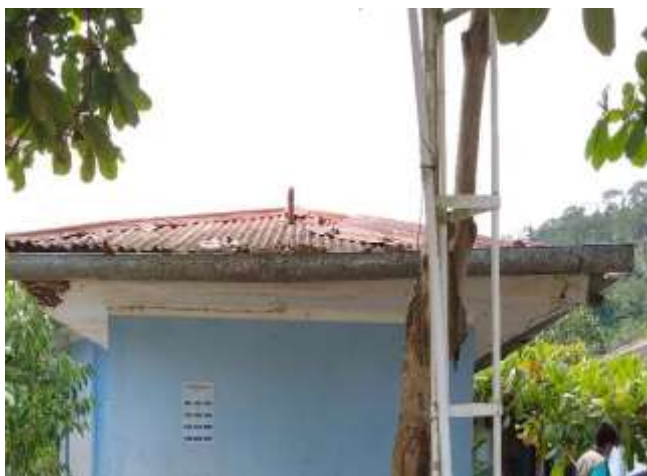
Vista de la canaleta en pésimo estado de conservación ocasionado por falta de mantenimiento. Se plantea cambio. Baño para pacientes
