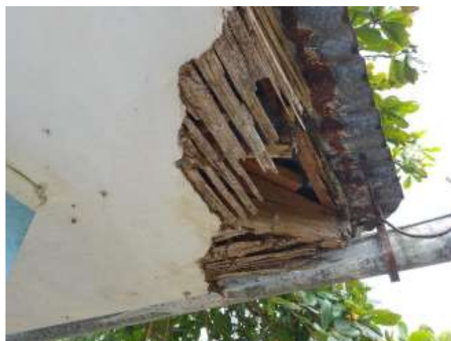
Vista del alero en pésimo estado de conservación, calamina y canaleta con indicios de corrosión. Se plantea cambio. Baño- pacientes
