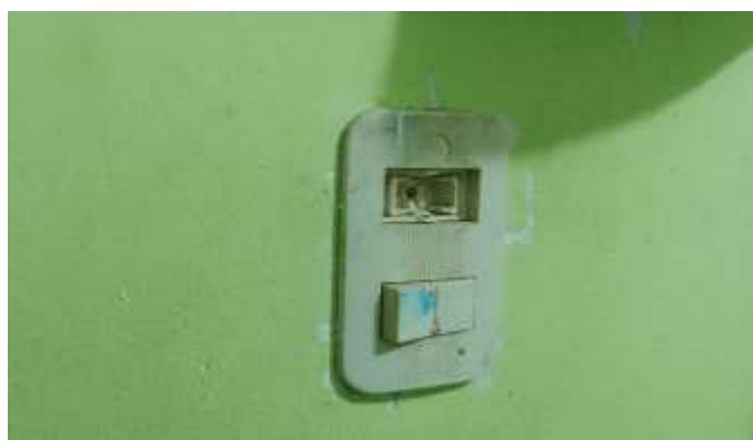
Vista del interruptor dañado. Se plantea su cambio. Ambiente Obstetricia
