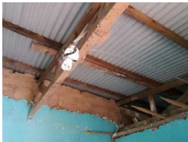
Vista donde se observa la instalación no adecuada. Se plantea la reinstalación. Ambiente Laboratorio.
