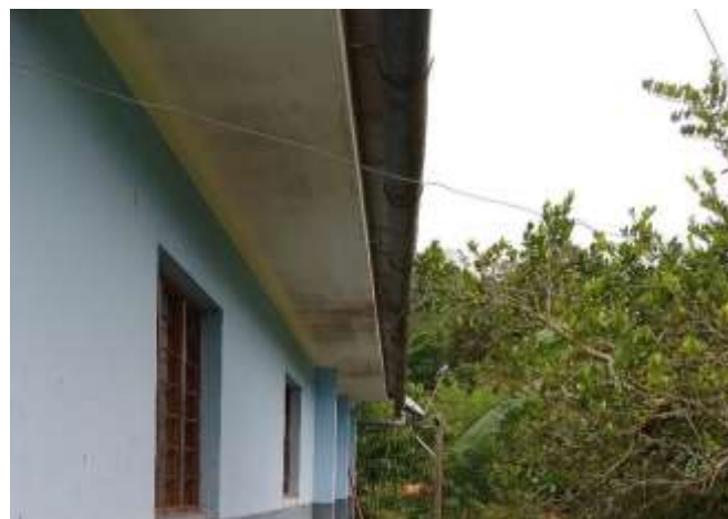
Vista del alero con manchas y canaleta con corrosiones. Se plantea pintado y cambio de canaleta. Ambiente residencia
