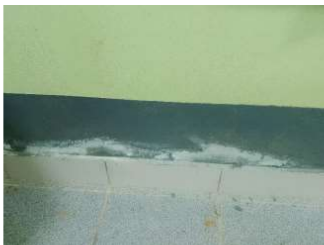
Vista del zócalo con exfoliación de la pintura. Se plantea repintado. Ambiente CRED
