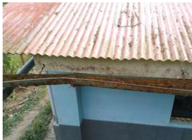
Vista de la parte interna de la canaleta total mente corroído. Se plantea cambio de canaleta. Alero posterior de la casa materna.
