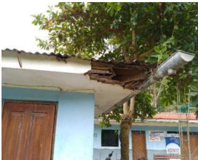
Vista del alero en pésimo estado de conservación, ausencia del tubo de canaleta. Se plantea cambio. Baño-pacientes
