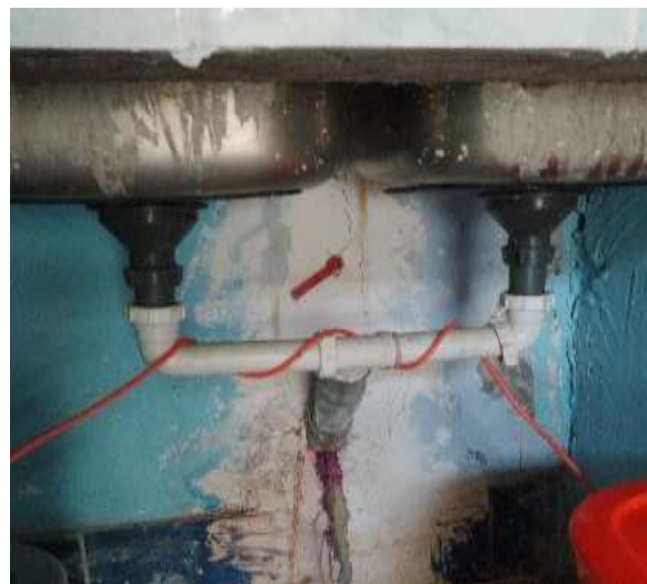
Vista de la trampa de lavatorio dañado. Laboratorio.
