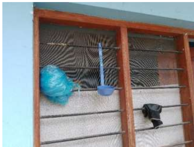
Vista que detalla ausencia de la malla en la venta. Se plantea la colocación de malla. Ambiente residencia.
