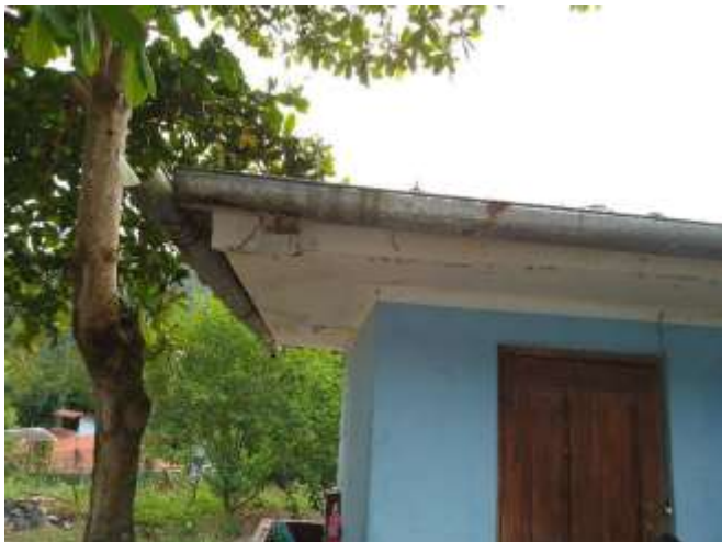
Vista de la canaleta con indicios corrosión. Se plantea su cambio. alero frontal de los servicios higiénicos-pacientes
