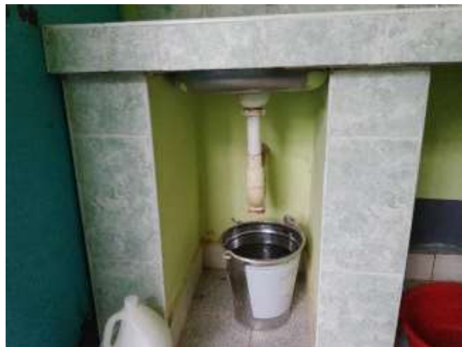
Vista de la trampa de lava mano con goteras. Se plantea cambio. ambiente cadena de frio
