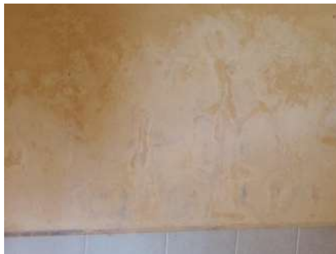
Vista donde se aprecia el proceso de exfoliación de la pintura, causado por la humedad. Se plantea repintado. Ambiente de ducha común para profesionales
