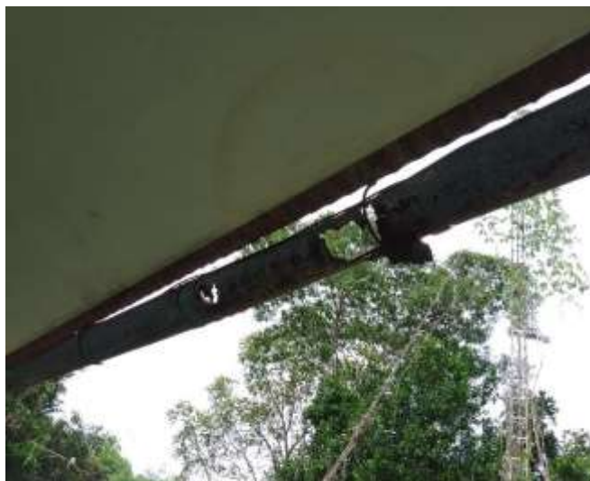
Vista de la canaleta con agujeros ocasionado por falta de mantenimiento. Se plantea cambio. Alero posterior de la casa de partos
