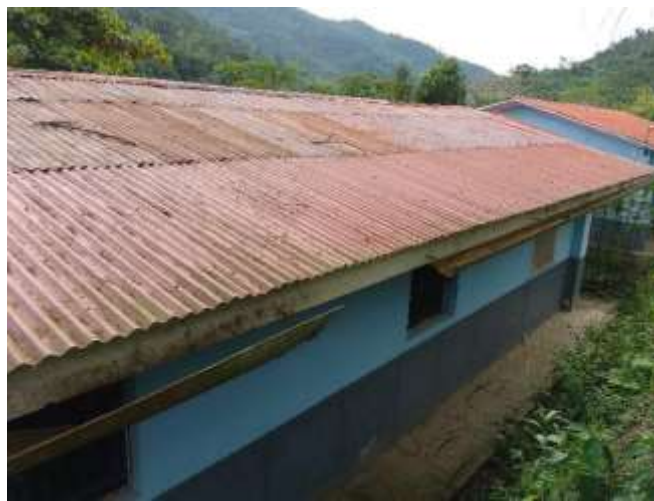
Vista de la cubierta con indicios de corrosión y despintado. Se plantea cambio de planchas dañadas y repintado.
