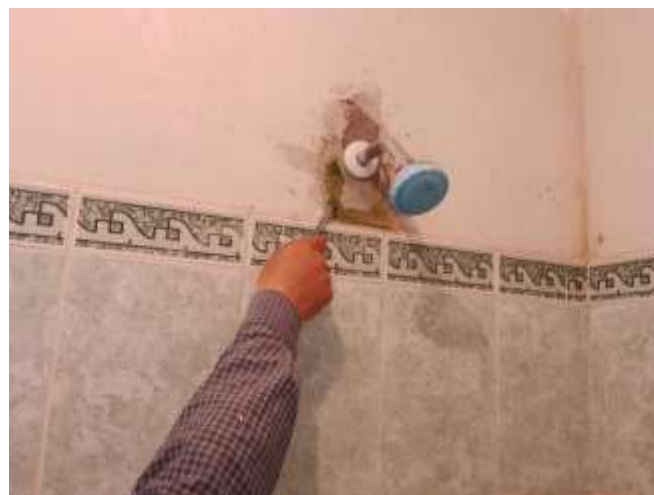
Vista del cabezal de ducha y accesorios dañados. Se plantea cambio y refacción de la pared con exfoliación de la pintura
