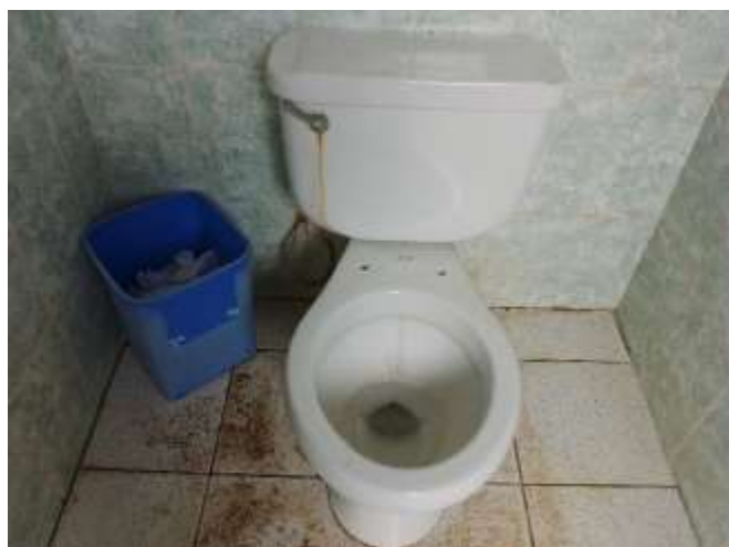
Vista del accesorio del tanque de agua dañado. Se plantea su cambio. Baño de uso para profesionales
