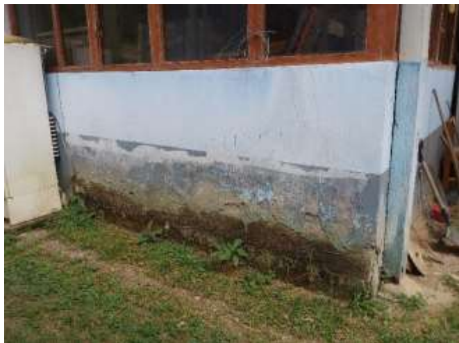
Vista del zócalo y contra zócalo donde se aprecia el proceso de exfoliación de la pintura, causado por la humedad y lluvias. Se plantea refacción y repintado. Pared externa de laboratorio
