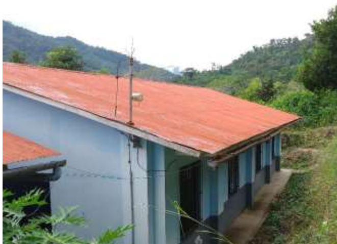
Vista donde se aprecia la cubierta despintada de la edificación de los consultorios. Se plantea repintado
