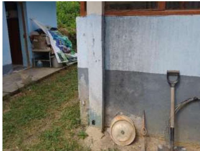
Vista donde se observa manchas en la pared externa del ambiente Triage. Se plantea repintado.
