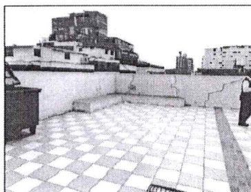
Fisuramientos en el piso 8 colindante con el Jr. Gamarra N° 785-799.
