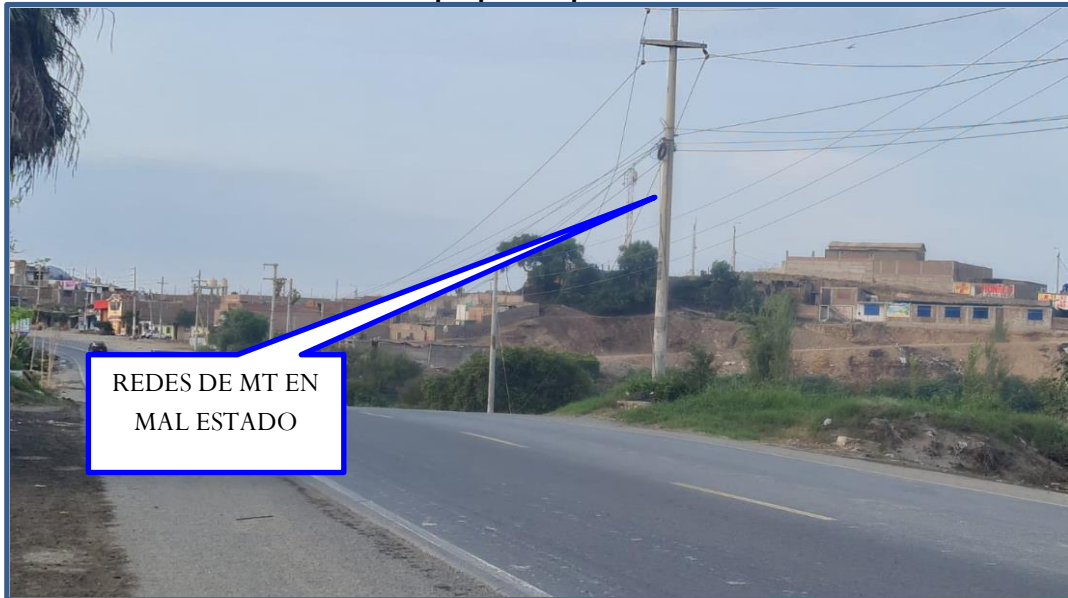
Figura N° 13: Postes de concreto de MT y BT deteriorados que están dentro de propiedades, incumpliendo DMS, estructuras y equipos de maniobras dentro de propiedad privada.
