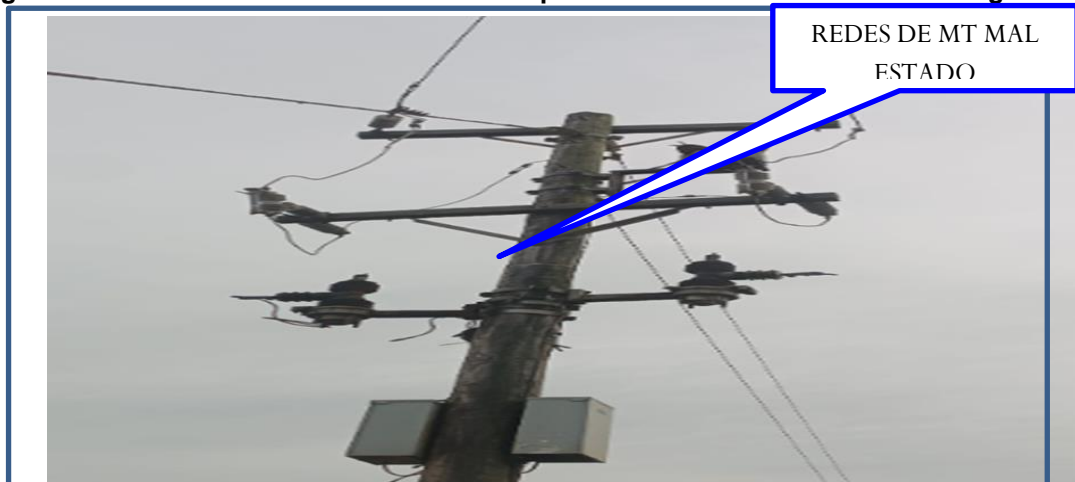
Figura N° 14: Redes de media tensión incumplimiento distancias mínimas de seguridad
