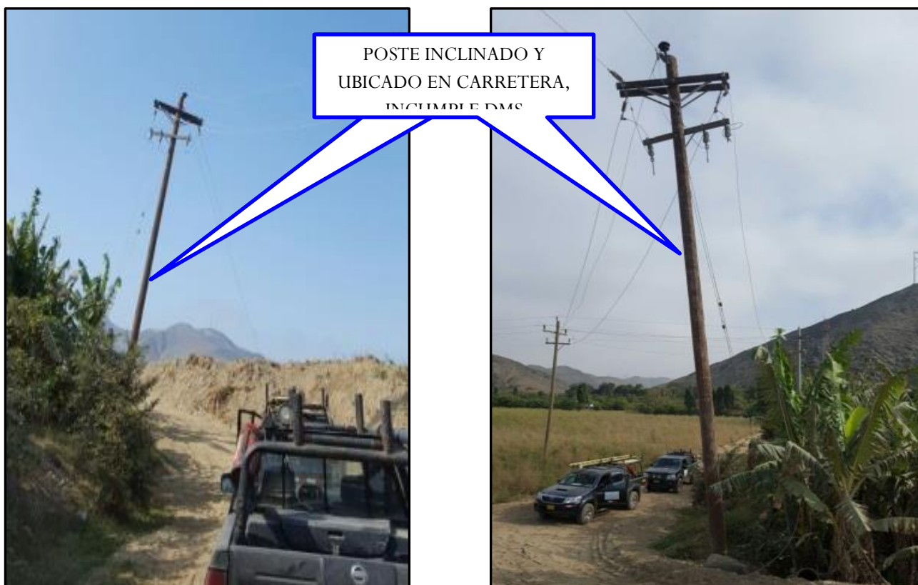
Figura N° 12: Redes de media tensión incumplimiento distancias mínimas de seguridad
