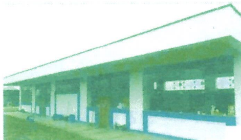
Foto 9. - visto frontal del aula 03 y04 existente, construido por la municipalidad de Quilmana en el año 2018 con paredes de ladrillo, techo de losa aligerada y piso de porcelana con estado de conservación buena.
