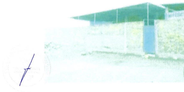
Foto 3.- visto del lado Oeste del cerco perimétrico de la IE N°606, necesita el cual necesita sobre encimar en altura para poder brindar mayor seguridad dado que actualmente la altura max. Del cerco es de 2.00 m la condición estructural de la misma es regular.
