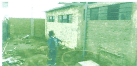
Fotos 22.- vista posterior de los servicios higiénicos de los niños, se puede observar el ataque de la humedad del suelo al sobrecimiento y a la pared.
