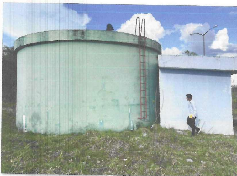
Imagen N° 1: Tanque Cisterna, con filtraciones de agua.
