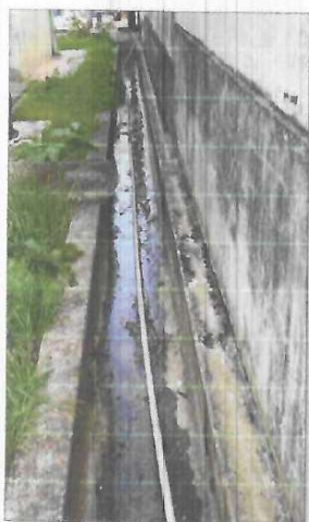
Imagen N° 3: Tubería expuesta.
