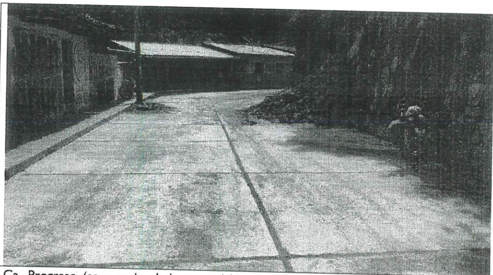
Ca. Progreso (se aprecia el desgaste del pavimento y derrumbes por inestabilidad de taludes)
