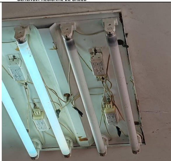
F20: Reposición de Luminarias malogradas | Corredor
