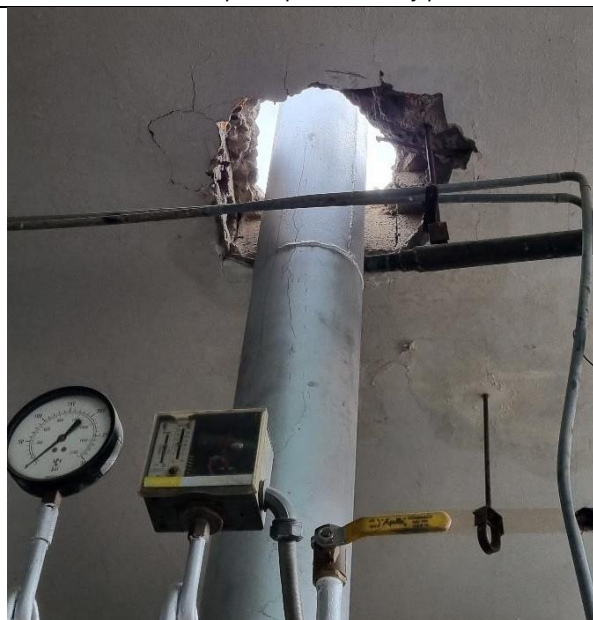
F5: Suministro e instalación de brida para sellar pase en techo
