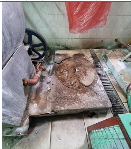
F6: Demolición de poyo en lavandería
