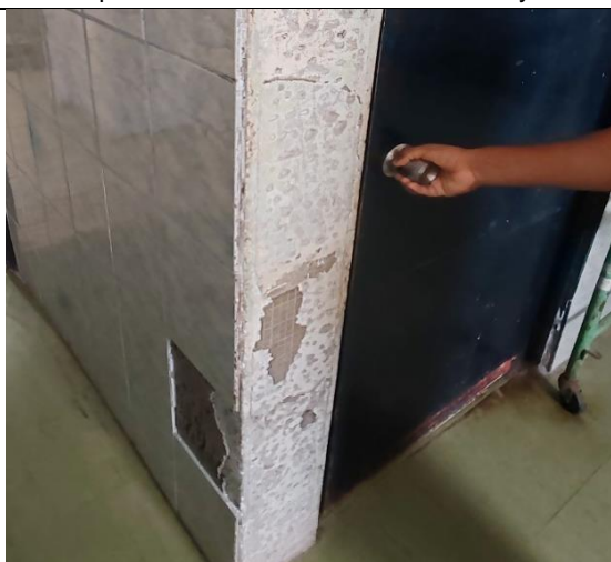
F16: Reposicion de zocalo quebrado I UPPSEmergencia
