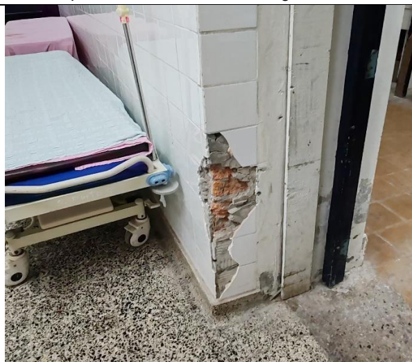
F22: Reposición de zocalos quebrados | Gineco Obst.
