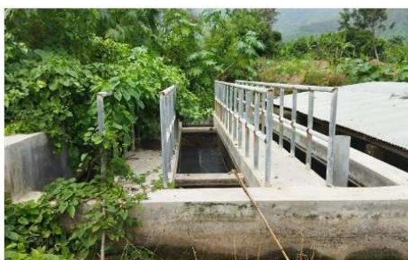
Foto N° 03: Tanque Imhoff inundado
