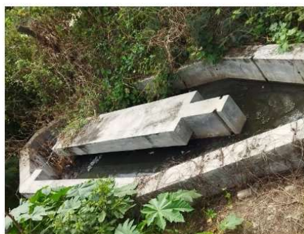
Foto N° 06: Cámara de rejillas con lodos
