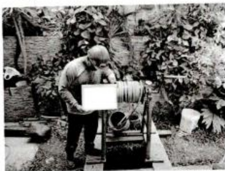
Figura 1 Excavación de calicata manual con malacate
