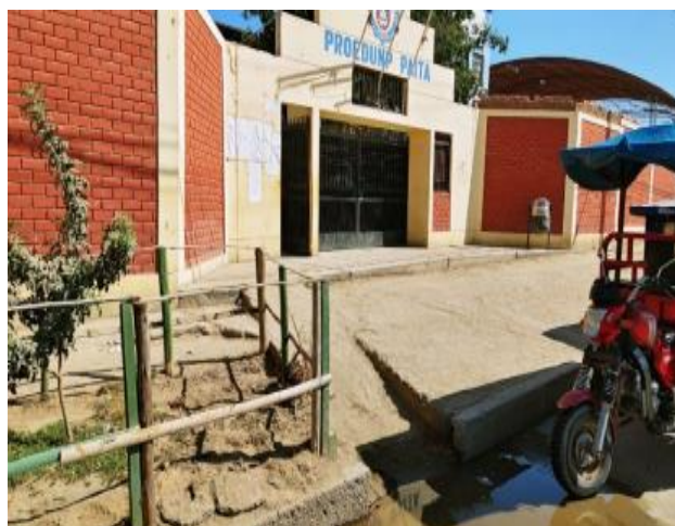
Imagen N° 03: Vía de ingreso deteriorada y con una pendiente no adecuada para la transitabilidad de discapacitado.
