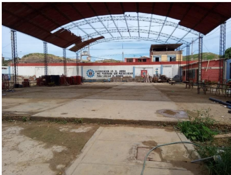
Imagen N° 03: Vía de ingreso deteriorada y con una pendiente no adecuada para la transitabilidad de discapacitado.
