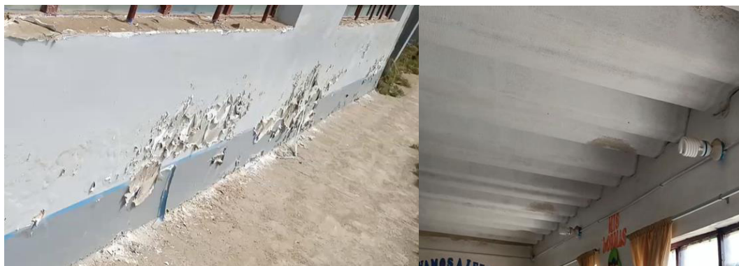
Ilustración 9. Deterioro de las paredes y techos en Aula 03 y dirección.
