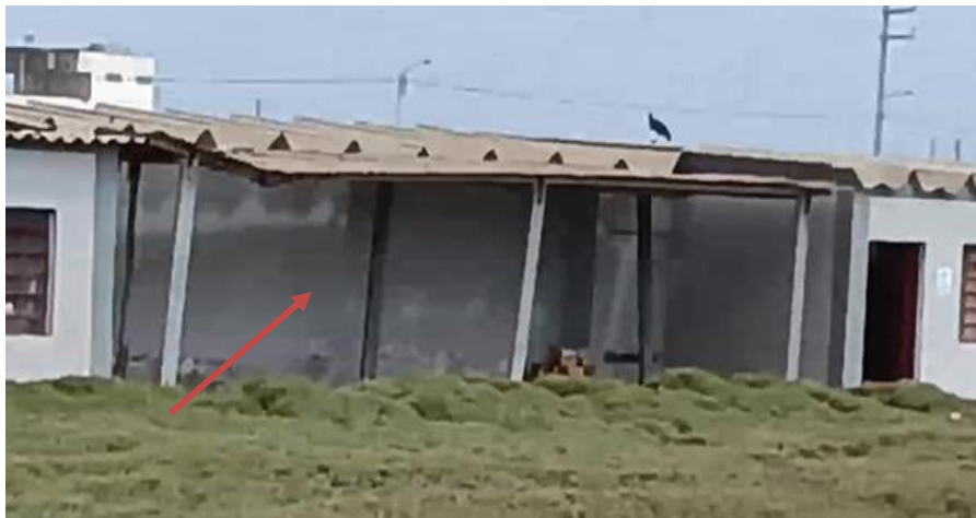
Ilustración 6. Patio techado con material precario. En la parte de atrás se encuentra un ambiente clausurado en estado de deterioro.
