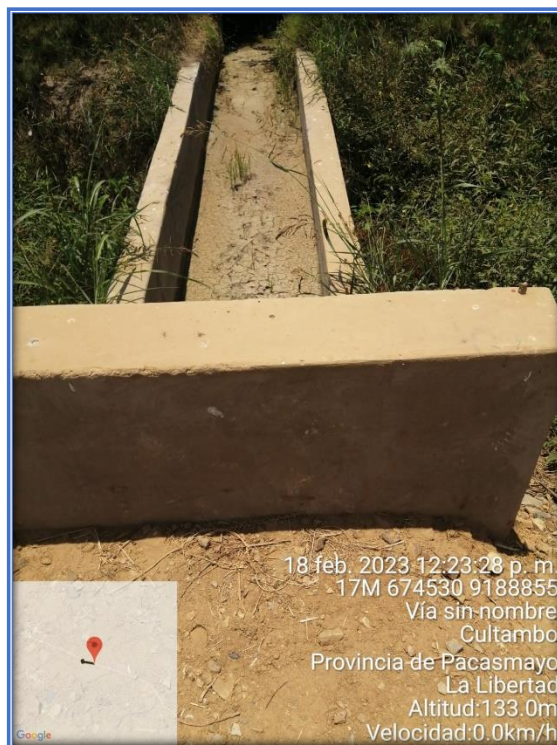
Fotografía N° 04: Vista se la situación actual de la vía, alcantarilla transversal pase de agua.
