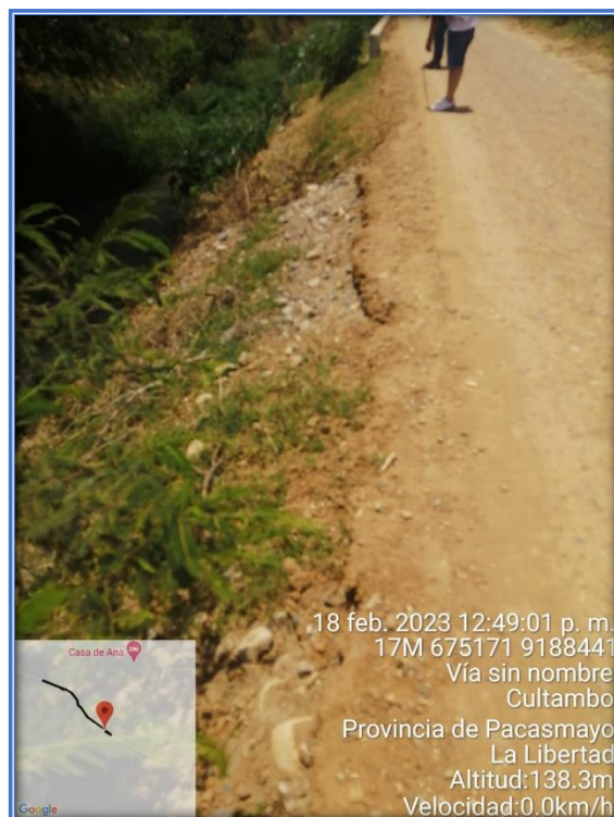
Fotografía N° 05: Vista se la situación actual de la vía, se puede evidenciar borde de plataforma, requiere muro de protección.
