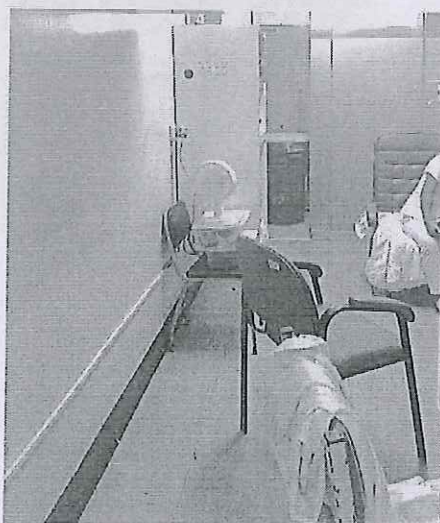
Imagen 14: Los muros interiores de los ambientes anexos de la sala de hospitalización B2 no cuentan con contrazócalo sanitario y zócalo a una altura no menor a 1.50 m, sobre el contrazócalo sanitario. Muros requiere mantenimiento de pintura.
