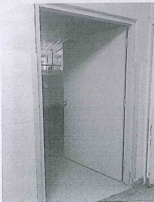
Imagen 12: Las puertas de los ambientes anexos no cuentan con visor (mirilla)
