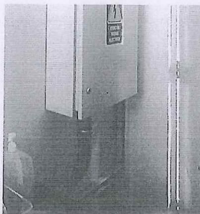
Imagen 01: Cables de alimentación del tablero principal expuesto
