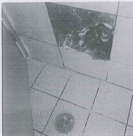
Imagen 07: Válvulas de control de agua y accesorios con óxido, presencia de moho y sin tapa de protección.
