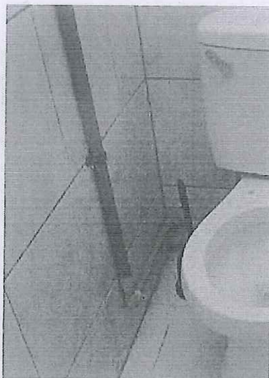
Imagen 05: Tuberías de agua expuestas (no empotradas)
