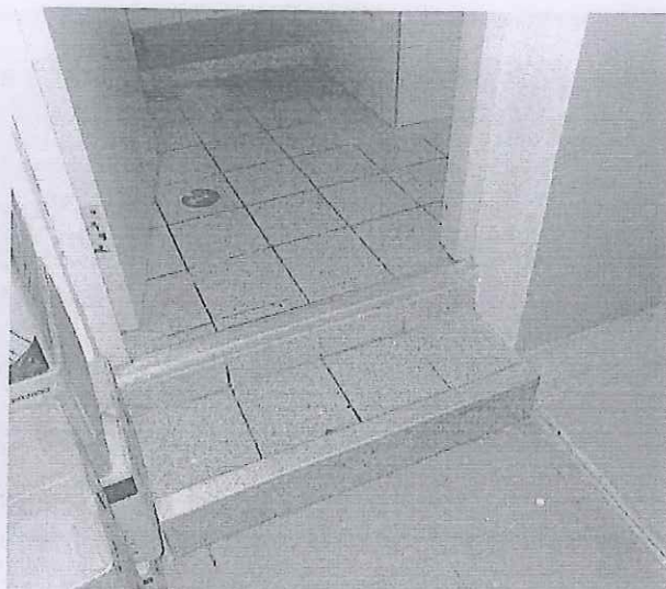
Imagen 13: Se requiere eliminar los desniveles, pasos y poyos de concreto.
