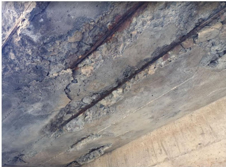
Imagen 12: Varillas de refuerzo de acero expuestas en piso de casa de máquinas.
