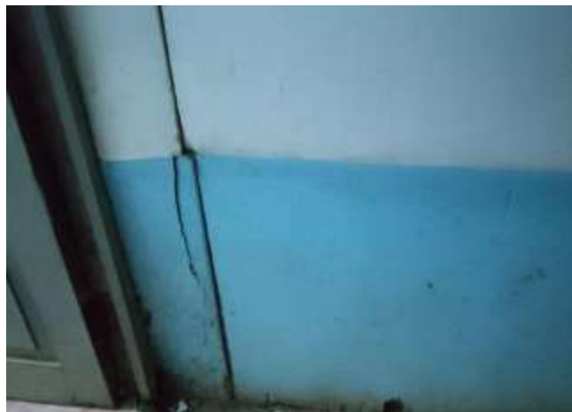
Vista que detalla fisura en la columna. Ocasionado por la humedad. Se plantea resane y pintado-ambiente residencia.
