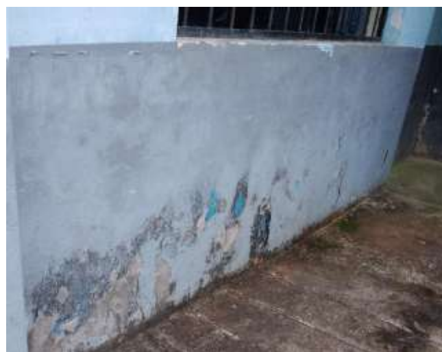
Vista que detalla el proceso de exfoliación de las capas de pintura a nivel de zócalo, ocasionado por la humedad y lluvias. Se plantea repintado.
