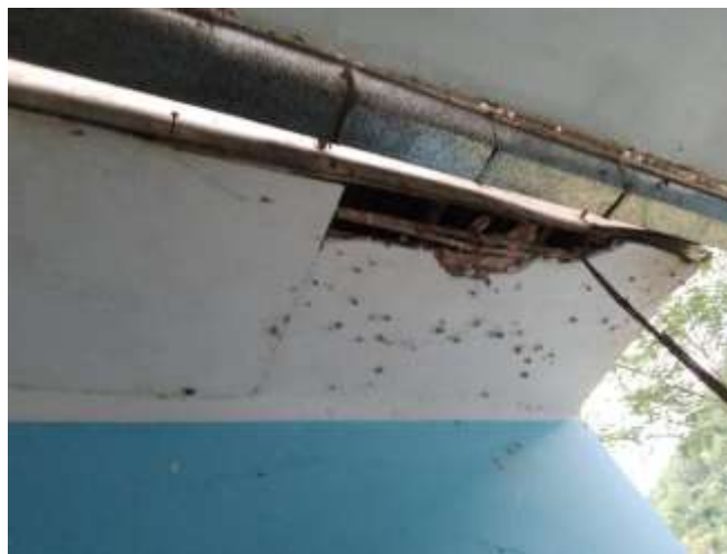
Vista a detalle desprendimiento del tratamiento del alero, causado por la humedad. Se plantea refacción y repintado. Alero frontal de la casa materna.
