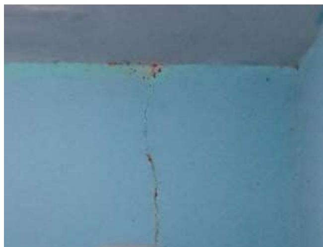
Vista que detalla fisura, causado por la humedad. Se plantea resane y repintado. Ambiente de residencia
