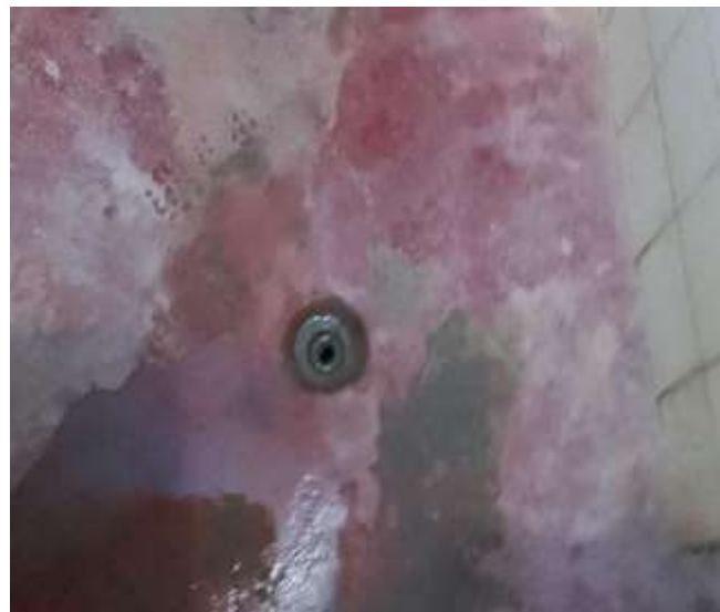
Vista donde se aprecia la ausencia del sumidero de baño. Se plantea reposición. Baño de residencia
