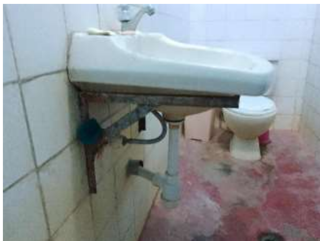
Vista en mal funcionamiento de los accesorios de lava mano. Se plantea cambio de accesorios. Ambiente baño de residencia
