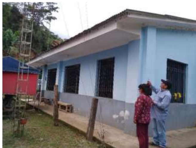
Vista en la cual se aprecia la ausencia de la canaleta de la facha posterior. Se plantea su instalación.
