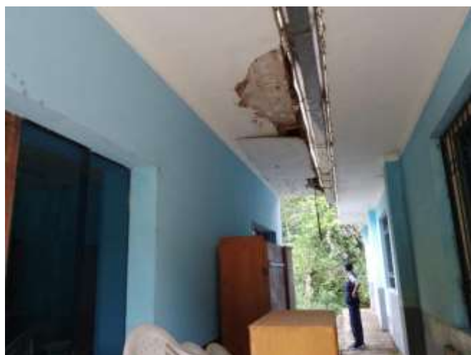
Vista que detalla el desprendimiento de la pintura en el alero frontal de la casa materna. Se plantea refacción y repintado.
