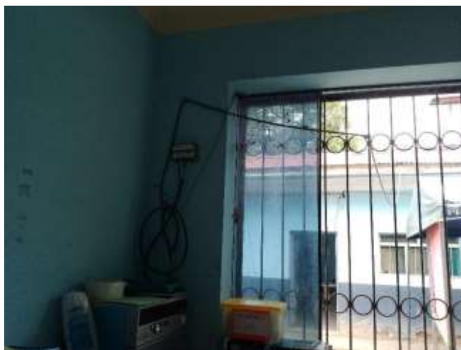
Vista donde se aprecia el sistema de cableado de manera inadecuada. Se plantea reinstalación. Ambiente Tópico 5
