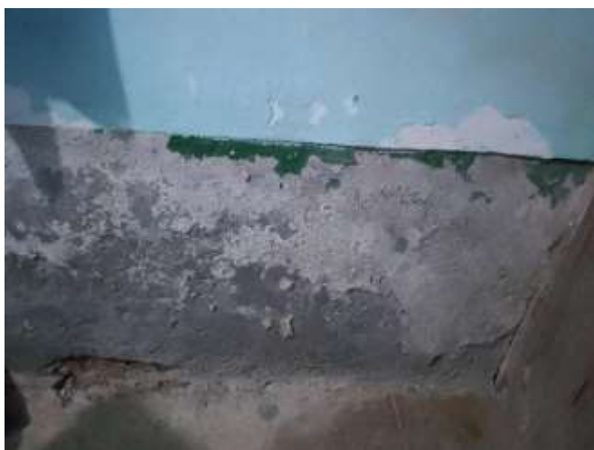
Vista del zócalo desmoronado, causado por la humedad. Se propone resane y repintado. Ambiente de residencia
