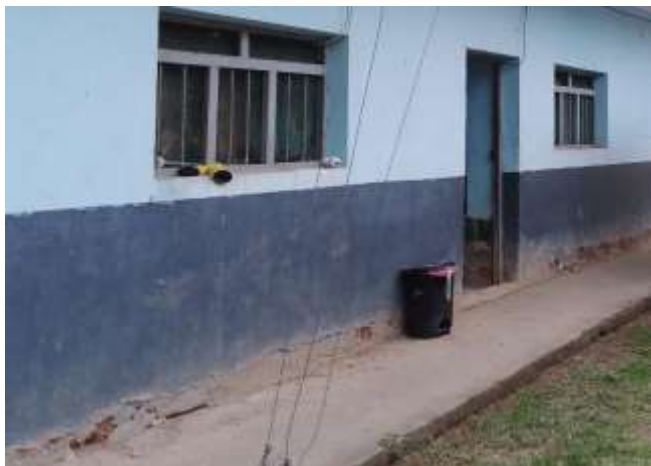
Vista del zócalo externo desmoronado, ocasionado por la presencia de aguas pluviales. Se plantea la refacción y pintado Ambiente de residencia
