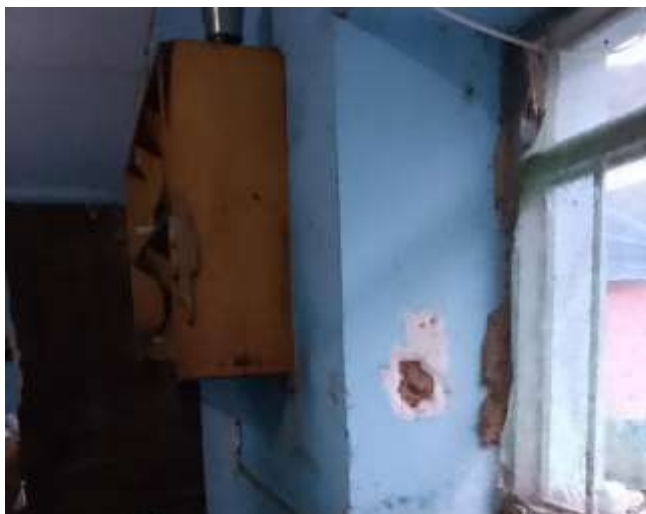
Vista que detalla faltante del material de estuco. Se propone restitucion del material faltante y repintado. Ambiente de residencia
