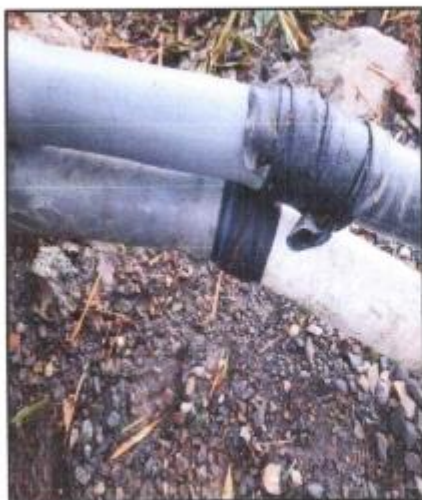
Fotografía N°43: Tubería dañada toma-02 Fuente: Elaboración Propia
