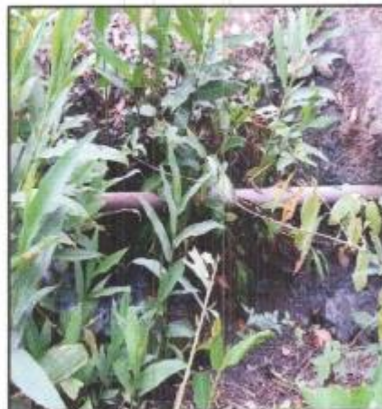
Fotografía N°83: Tubería aducción expuesta toma 02 Fuente: Elaboración Propia
