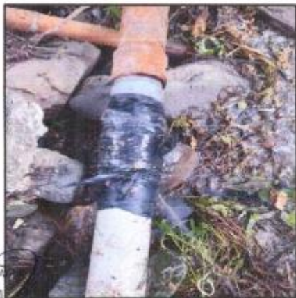
Fotografía N°41: Tubería dañada toma-01 Fuente: Elaboración Propia
