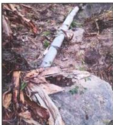
Fotografía N°16: Tubería dañada toma-03 Fuente: Elaboración Propia
