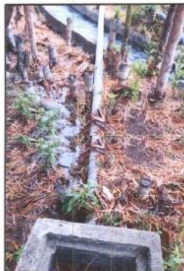
Fotografía N°23: Tubería dañada toma-02 Fuente: Elaboración Propia
