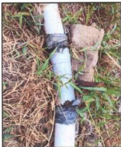
Fotografía N°47: Tubería dañada toma-03 Fuente: Elaboración Propia
