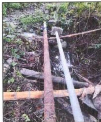
Fotografía N°44: Tubería dañada toma-03 Fuente: Elaboración Propia
