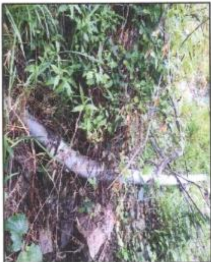
Fotografía N°33: Tubería dañada toma-03 Fuente: Elaboración Propia
