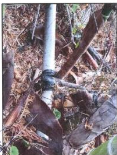
Fotografía N°45: Tubería dañada toma-01 Fuente: Elaboración Propia
