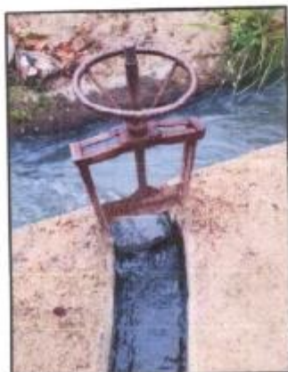
Fotografía N°06: Compuerta canal de higuerones Fuente: Elaboración Propia
