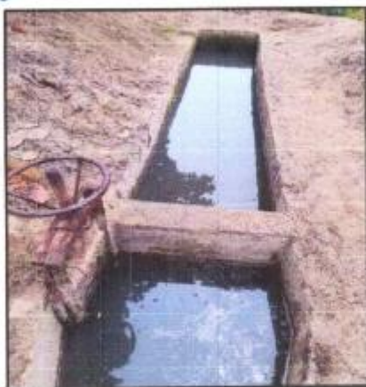
Fotografía N°12: Desarenador existente Fuente: Elaboración Propia
