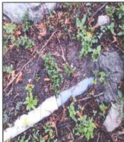
Fotografía N°21: Tubería dañada toma-04 Fuente: Elaboración Propia
