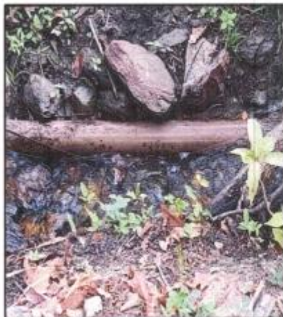
Fotografía N°82: Tubería aducción expuesta toma 01 Fuente: Elaboración Propia
