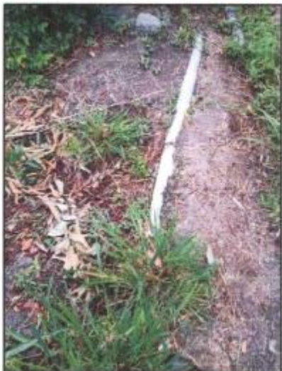
Fotografía N°39: Tubería dañada toma-03 Fuente: Elaboración Propia
