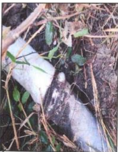
Fotografía N°31: Tubería dañada toma-01 Fuente: Elaboración Propia
