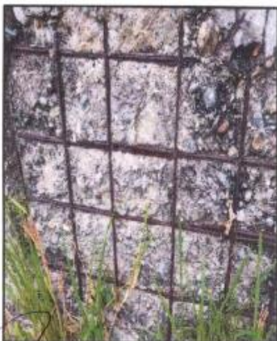
Fotografía N°78: Reservorio apoyado, evidencia acero Fuente: Elaboración Propia
