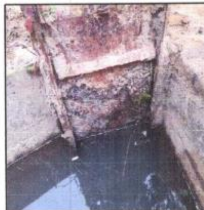
Fotografía N°13: Compuertas desarenador Fuente: Elaboración Propia
