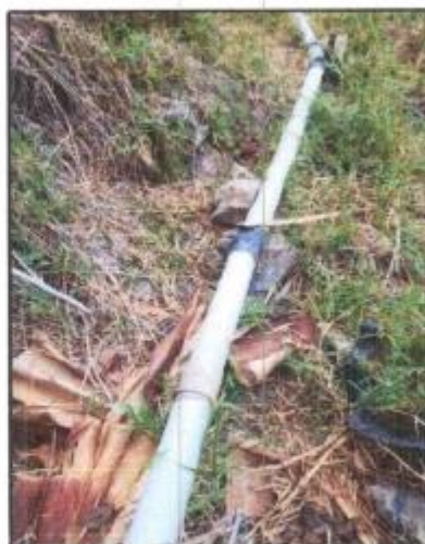
Fotografía N°48: Tubería dañada toma-04 Fuente: Elaboración Propia
