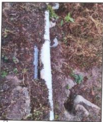
Fotografía N°26: Tubería dañada toma-01 Fuente: Elaboración Propia
