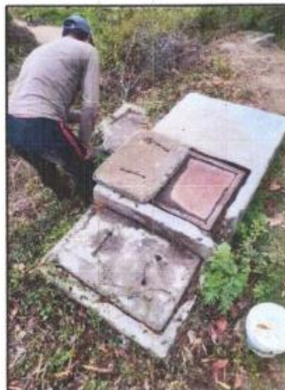
Fotografía N°74: Cámara rompe presión tipo 06- toma 02 Fuente: Elaboración Propia
