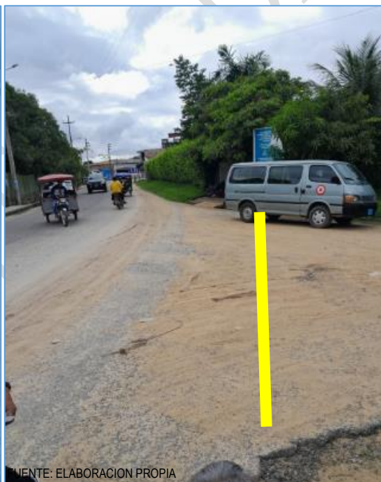
Registro Fotográfico N°02. Carretera Santa clara, es necesario el corte y reposición de pavimento flexible para facilitar la instalación de tubería 160mm
