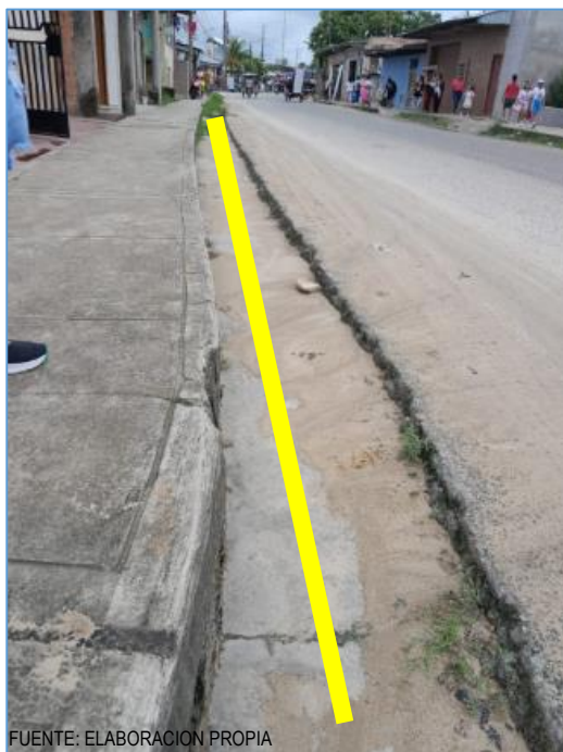
Registro Fotográfico N°01. Carretera Santa clara, es necesario el corte y reposición de cuneta para facilitar la instalación de tubería 160mm
