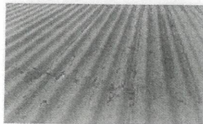
FOTO N°2.- COBERTURA DEL TECHADO ACTUAL DEL PAS SE ENCUENTRA CON TRASLAPES MUY CORTOS POR DONDE SE FILTRA LAS AGUAS DE
