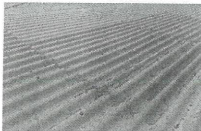
FOTO N°3.- COBERTURA DEL TECHADO ACTUAL DEL PAS TRASLAPES RESANADOS CON MORTERO
