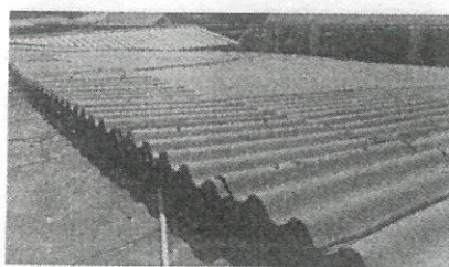
FOTO N°1.- COBERTURA DEL TECHADO ACTUAL DEL PAS SE ENCUENTRA MAL TRASLAPADO CON LA ONDA INVERTIDA FILTRACION POR LOS PERNOS DE FIJACION QUE SE ENCUENTRAN EN MA
