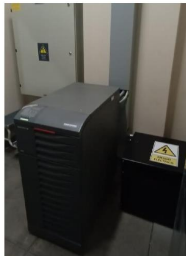
SISTEMA ENERGIA DE RESPLADO 5 KVA / 220V, \phi
