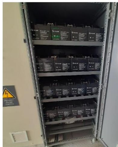
SISTEMA ENERGIA DE RESPLADO 15 kVA, 380V, 3 \phi
