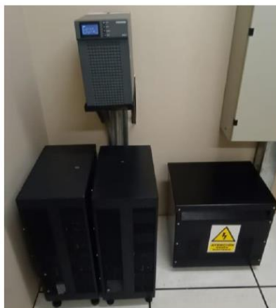
SISTEMA ENERGIA DE RESPLADO 6 kVA, 220V, 1 \phi
