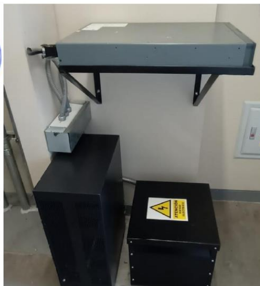
SISTEMA ENERGIA DE RESPLADO 3.3 kVA, 220V, 1 \phi
