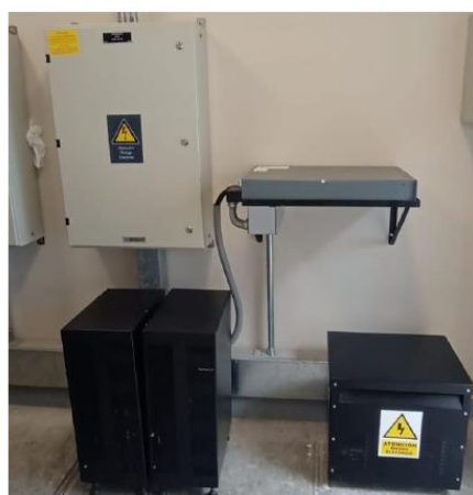
SISTEMA ENERGIA DE RESPLADO 5 KVA / 220V, \phi
