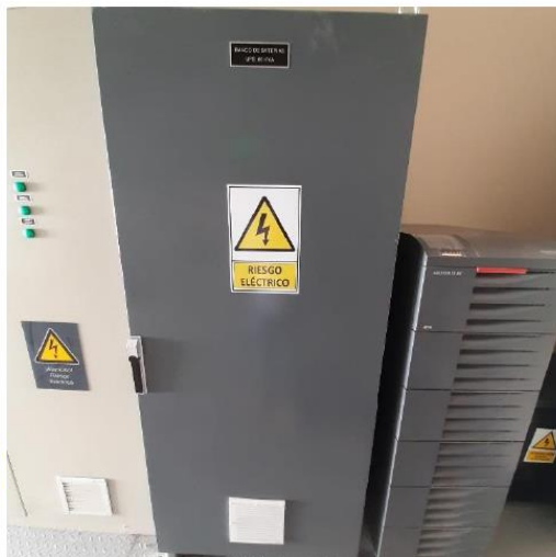
SISTEMA ENERGIA DE RESPLADO 6 kVA, 220V, 1 \phi
