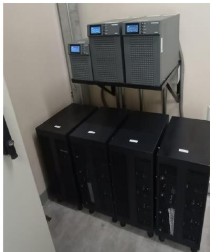
SISTEMA ENERGIA DE RESPLADO 10 kVA, 220V, 1 \phi 3 kVA, 220V, 1 \phi
