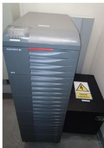
SISTEMA ENERGIA DE RESPLADO 15 kVA, 380V, 3 \phi
