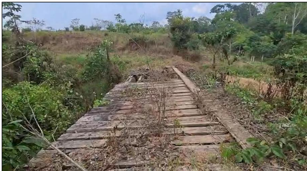
Figura N°7. Puente 28 de Julio existente de estructura de madera en malas condiciones
