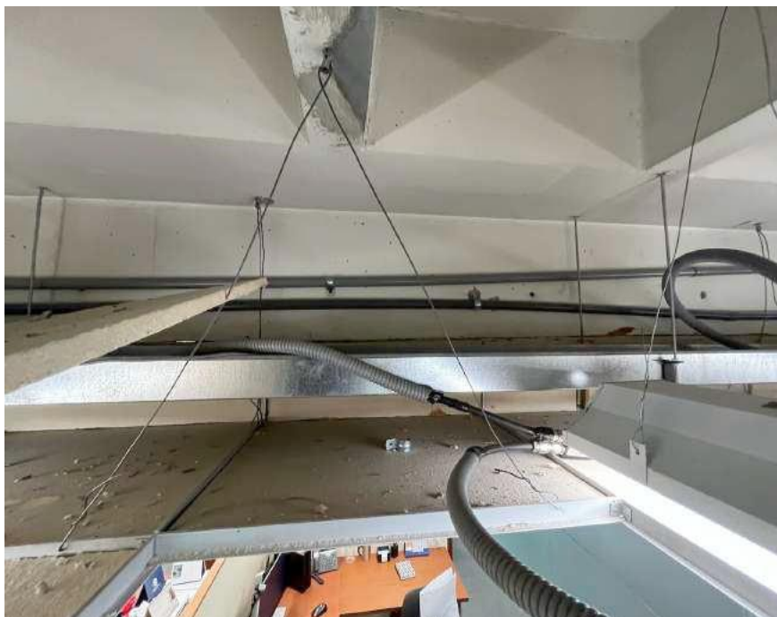
Fig.06. Estado interior de cielo raso a desmontar e instalaciones AA
