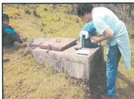
VISTA N° 6: Cámara rompe presión existente.
