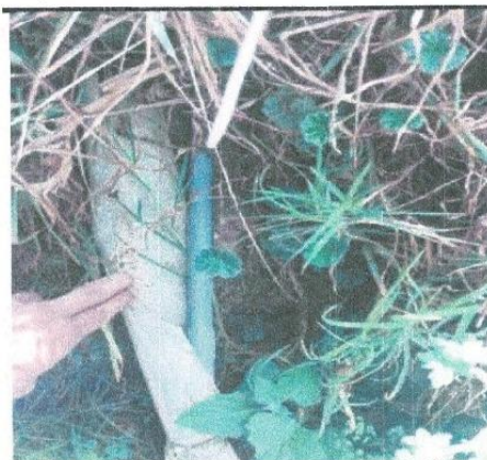
VISTA N° 2: Tubería de Ø 1' 2" en línea de conducción Villa Bebederos
