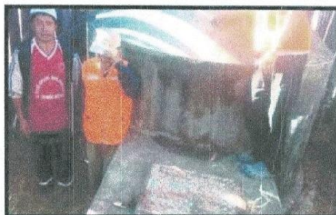
VISTA N° 11: Vista de reservorio existente en mal estado a cambiar, presenta fisuras.
