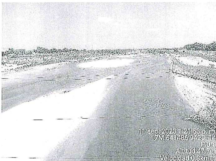
Se aprecia el Rio Piura que perdio su seccion hidraulica por lo colmatado que se encuentra.
