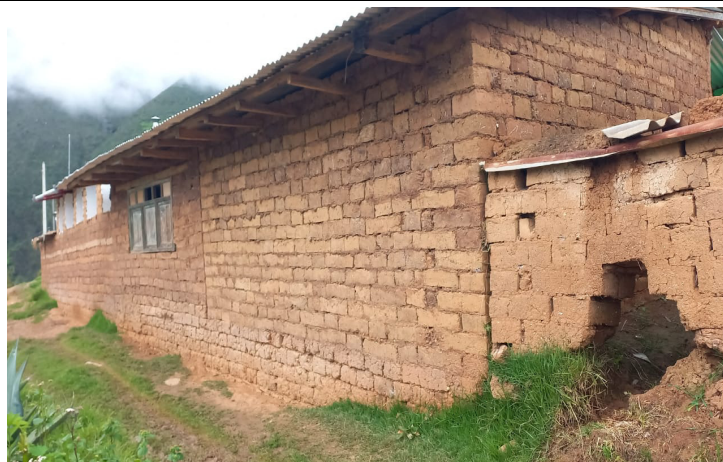
Fotografía 02: Se muestra cerco perimétrico de adobe, incompleto y en mal estado de la IE N° 242.
