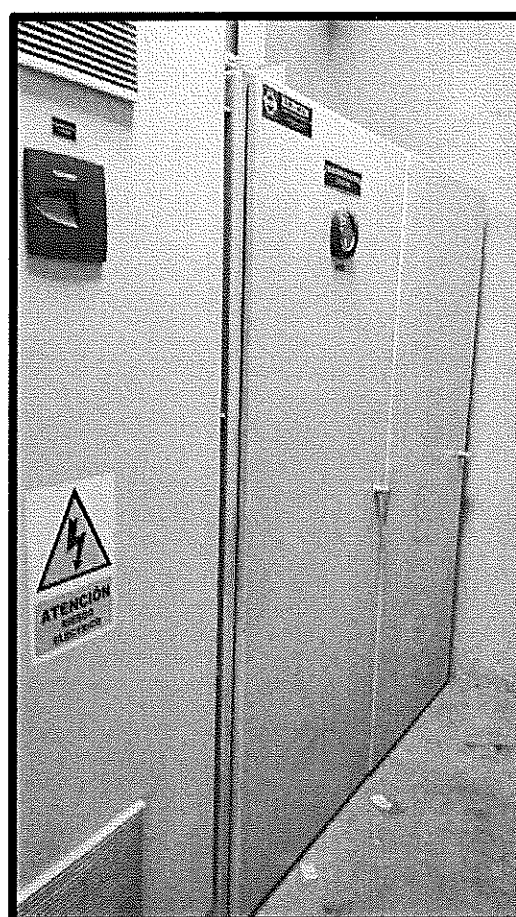
Imagen 09: Muestra los envolventes del banco de condensadores y del tablero general de baja tensión
