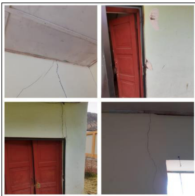
Ilustración 6. Vista de las fisuras existentes en ambientes de almacén y cocina- almacén
