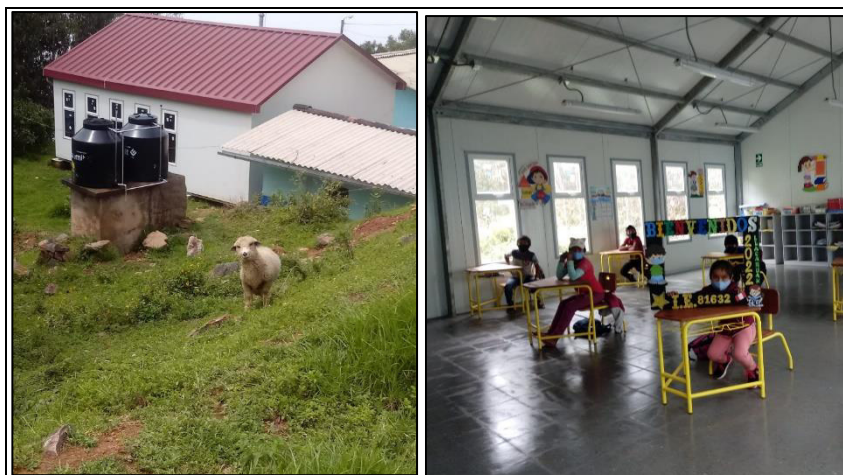
FOTO N° 07: Vista exterior e interior de la Aula (Primaria) de la I.E.81632 construido con estructura metálica prefabricada, lo cual se encuentra en un estado regular de conservación.
