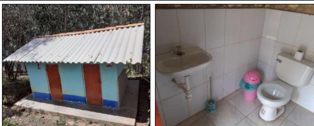
FOTO N° 09: Vista exterior e interior del S.S.HH. de la I.E.81632 construido con material precario (adobe), lo cual se encuentra en un estado regular de conservación.
