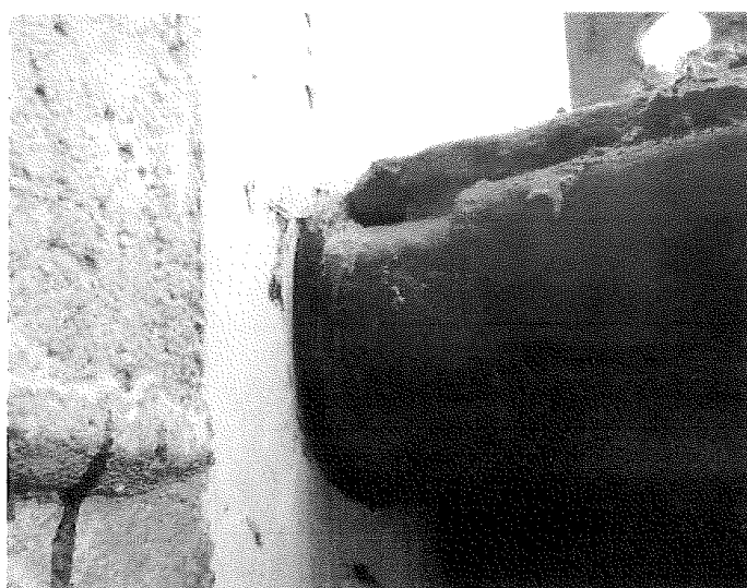
Defectos de unión sello superior, lateral y esquinero
