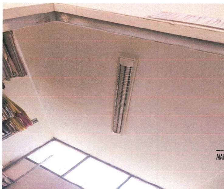
Imagen 06: Instalación de luminaria en malas condiciones y sin funcionamiento.
