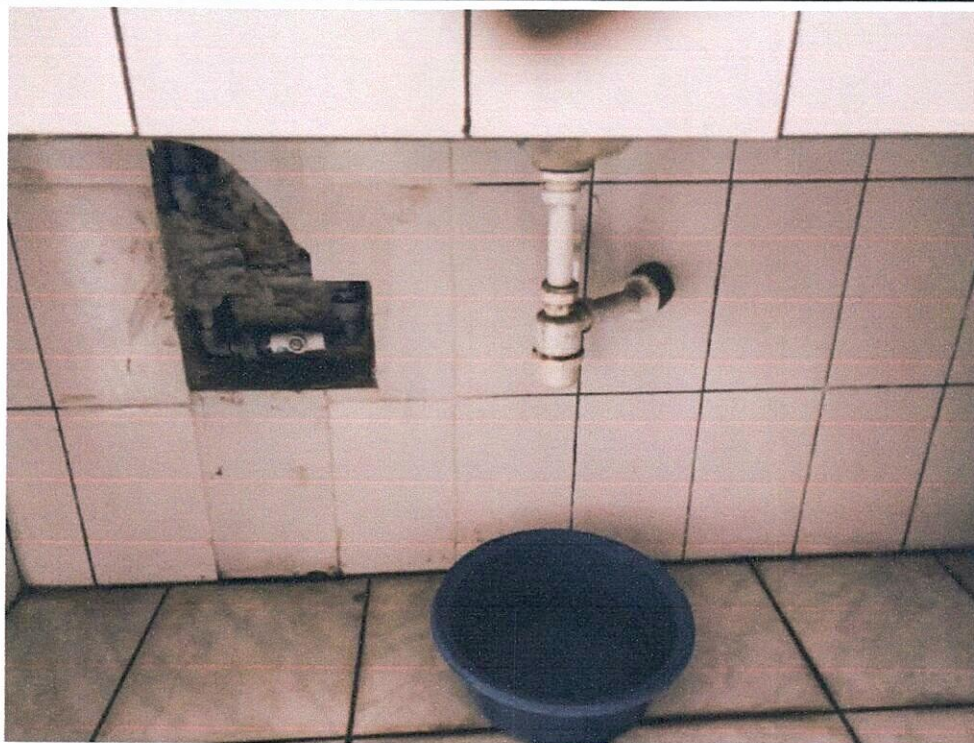
Imagen 11: Llave de paso malograda
