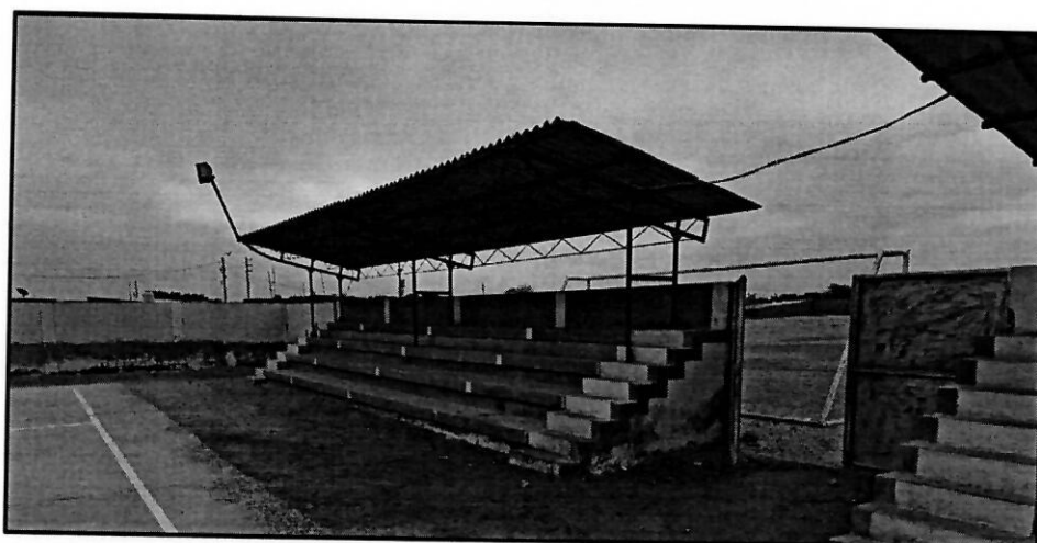
Imagen N° 02: Graderia en mal estado de conservación
