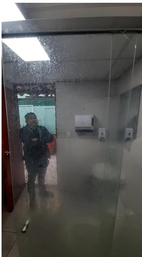
IMAGEN 05: Mampara de vidrio roto y vidrio tipo catedral de ventana roto.
