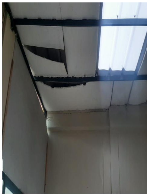
Cielo raso de material Tecnopor en mal estado
