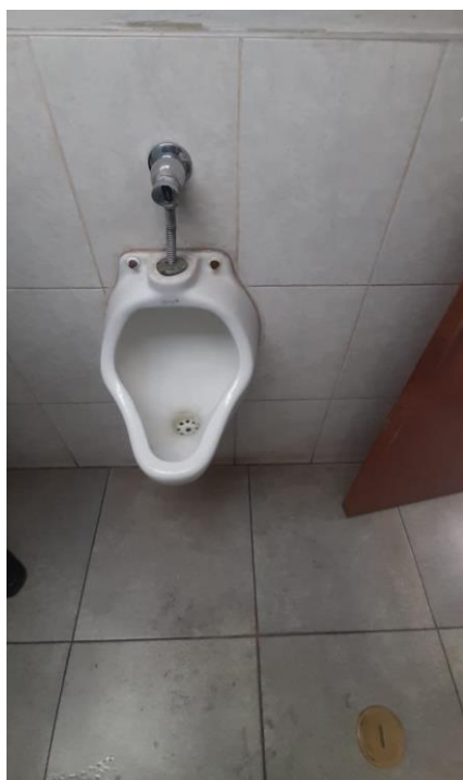
IMAGEN 03: Grifería de Urinario y Lavatorio en mal estado.
