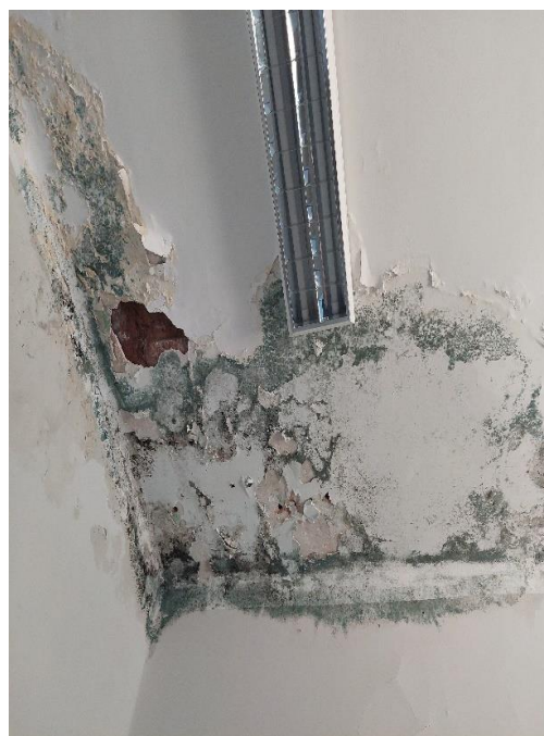
Cielo raso y pared en mal estado debido a filtración de agua del nivel superior
