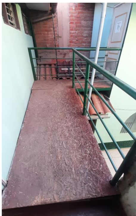
IMAGEN 02: Vista de pasadizo del 2do. nivel con piso de triplay OSB.
