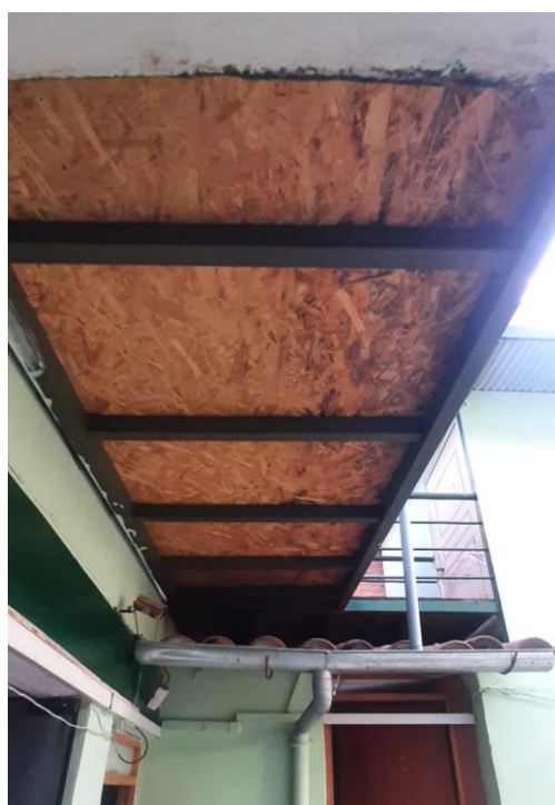
IMAGEN 02: Vista de pasadizo del 2do. nivel con piso de triplay OSB.
