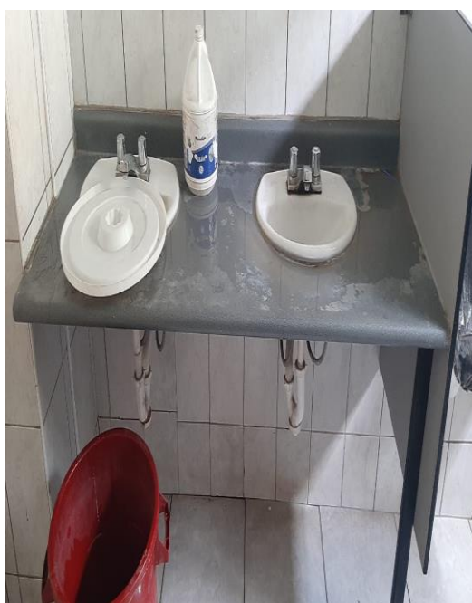
Lavatorio, grifería y accesorio deteriorados.
