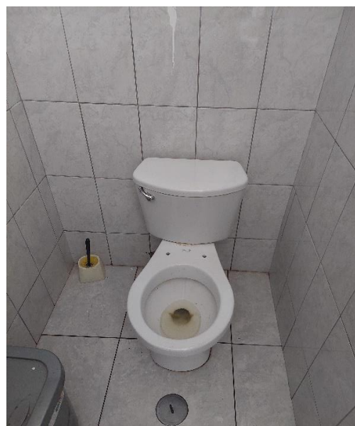
Existe fuga de agua debido al deterioro de accesorios de inodoro deteriorados.
