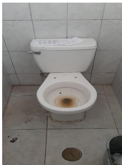
Deterioro de los accesorios de urinarios e inodoro en mal estado de conservación.
