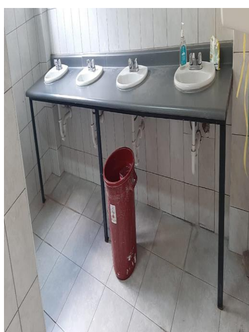
Fuga de agua debido al deterioro de los accesorios de lavatorio y grifería.
