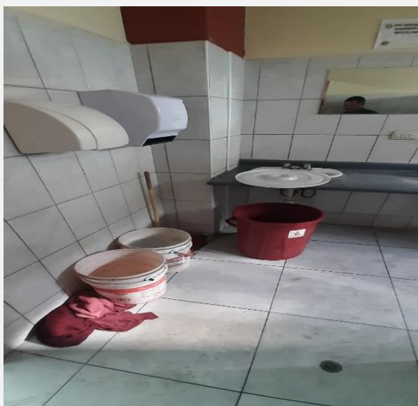
Almacenamiento de agua en tachos, por inoperatividad del tanque elevado.
