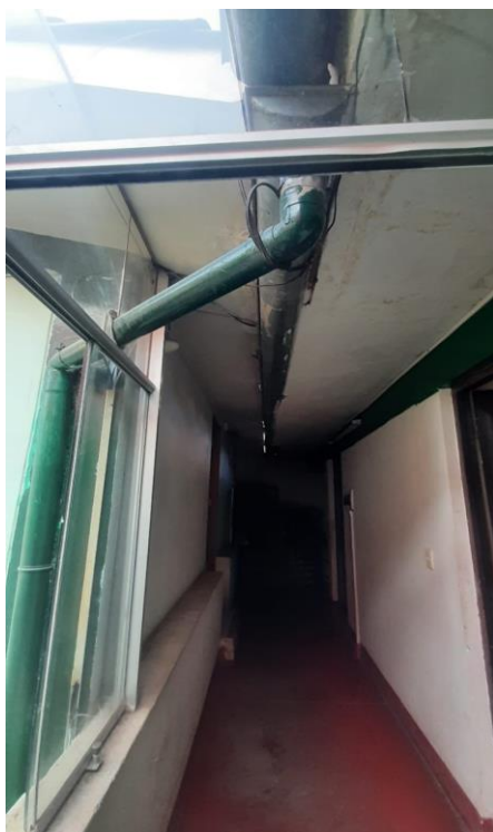
IMAGEN 06: Canaleta de evacuación pluvial sin pendiente y cerradura de chapa bola malogrado.
