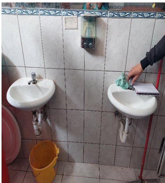
Lavatorio, grifería y accesorio deteriorados
