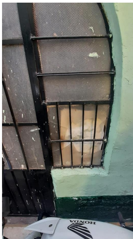
IMAGEN 05: Mampara de vidrio roto y vidrio tipo catedral de ventana roto.
