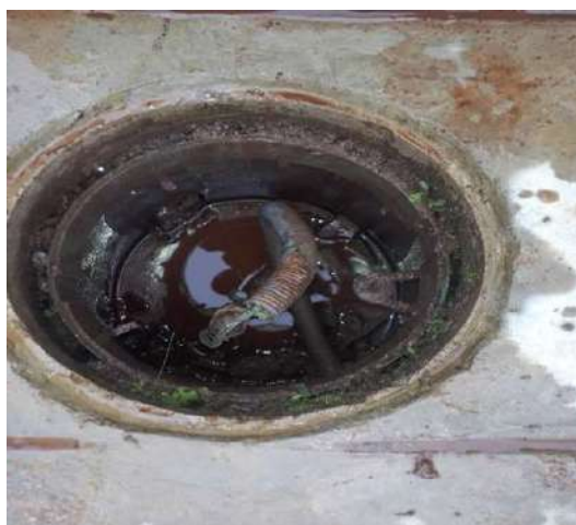
Fig. N° 38 UBICADO EN LA PARTE FRONTAL DEL TAMBO, AL COSTADO DE LA PUERTA DE SALA MULTISUO DEL TAMBO, PRESENTA SULFATACION. (pozo a intervenir).
