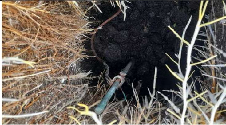
Fig. N° 23 PARTE INTERNA DE LA POZA, PRESENTAN OXIDACION LOS COMPONENTES, SIN TAPA (pozo a intervenir).
