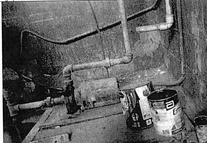
Foto N° 09: Se observa una bomba de succión que necesita cambio para su operación.
