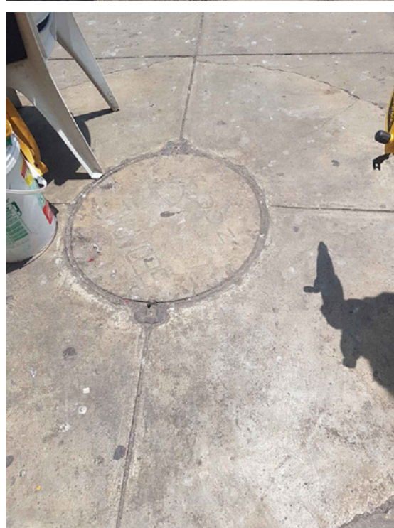
MANTENIMIENTO DE COLECTOR - CAMBIO DE MARCO Y TAPAS DE CONCRETO DE CAJAS DE REGISTRO - CAMBIO DE TAPA DE CONCRETO REFORZADO PARA BUZON
