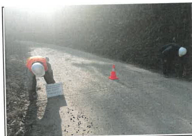
Foto 165: Ancho del pavimento de 4.40 m, progresiva 10+750.
