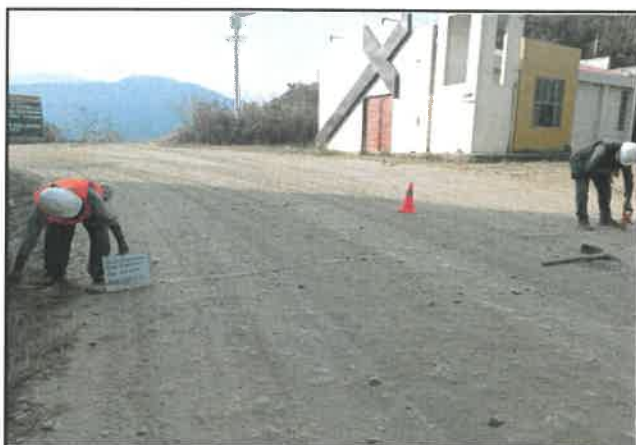
Foto 195: Ancho del pavimento de 6.50 m, progresiva 12+750.
