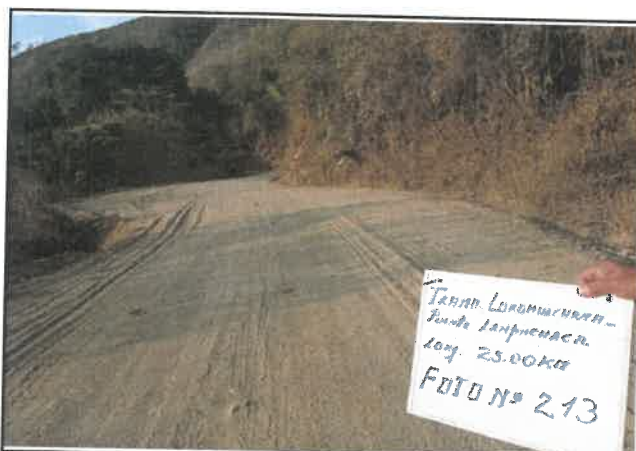
foto:213 Daño en pavimento, Presencia de erosion, progresiva De 14+000 a 14+250
