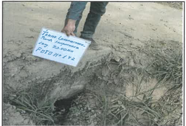
Foto 142: Alcantarilla de concreto simple en estado regular, progresiva 08+930.
