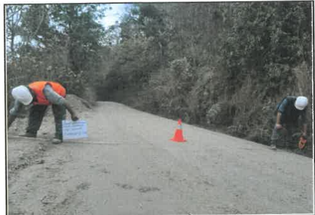
Foto 298: Ancho del pavimento de 5.20 m, progresiva 19+500.
