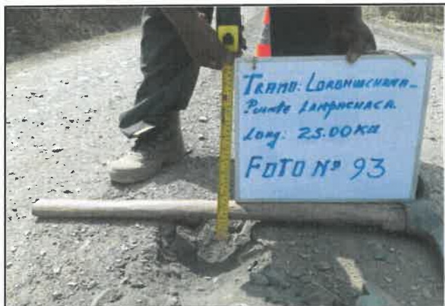
Foto 93: Espesor en pavimento de 5 cm, progresiva 06+000.
