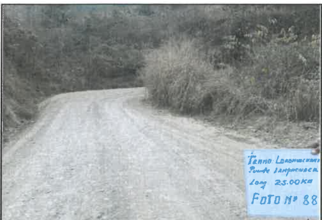
foto:88 Daño en pavimento, Presencia de erosion, progresiva De 05+500 a 05+750
