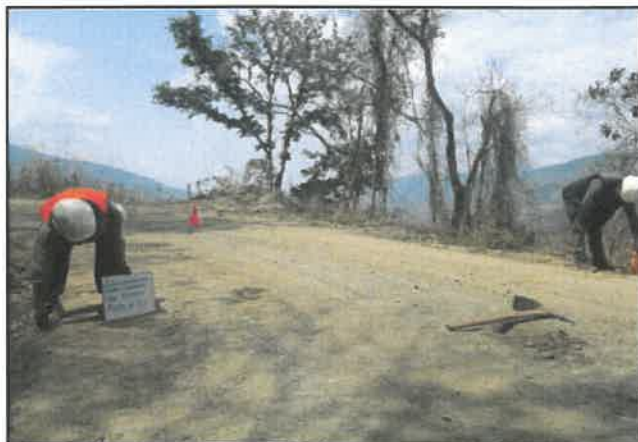
Foto 53: Ancho del pavimento de 5.30 m, progresiva 03+500.
