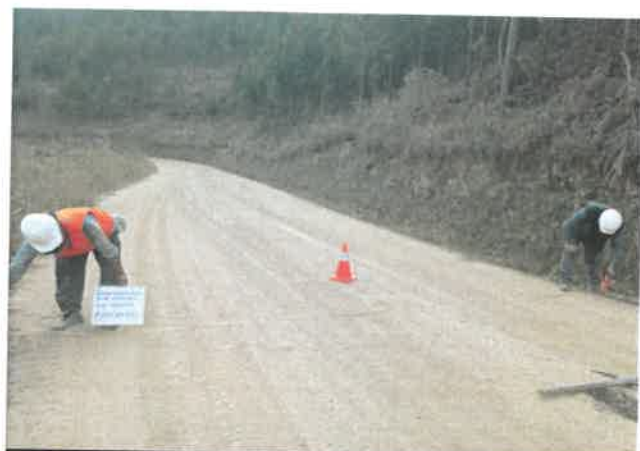
Foto 177: Ancho del pavimento de 4.80 m, progresiva 11+750.
