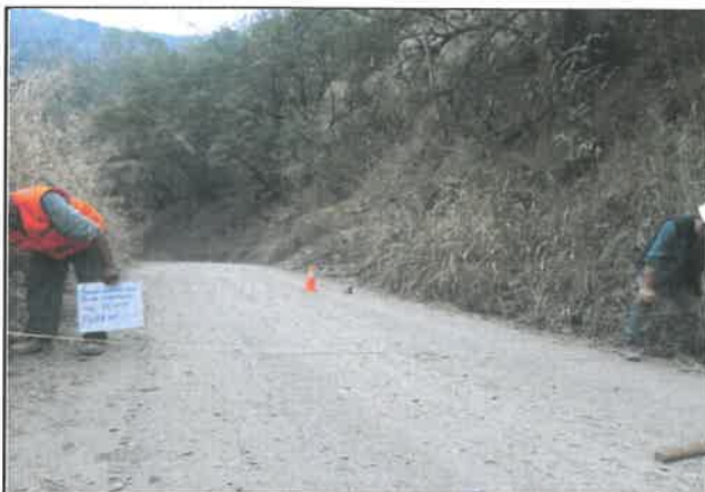
Foto 317: Ancho del pavimento de 4.90 m, progresiva 21+000.
