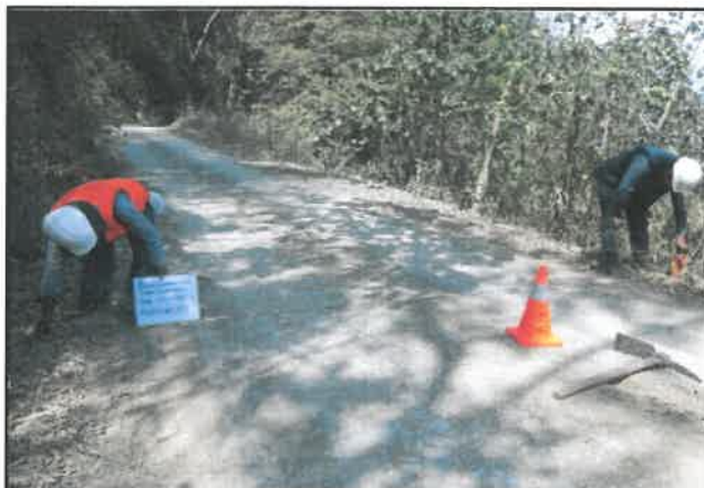
Foto 108: Ancho del pavimento de 4.50 m, progresiva 06+750.
