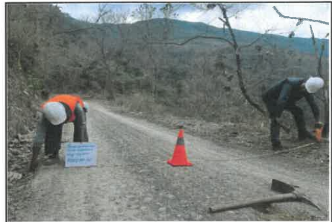
Foto 60: Ancho del pavimento de 3.80 m, progresiva 04+000.
