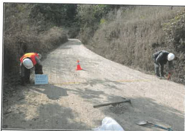
Foto 132: Ancho del pavimento de 4.70 m, progresiva 08+500.
