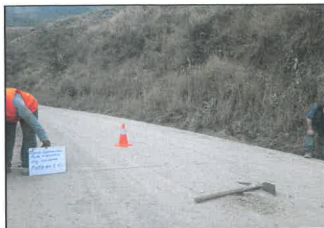
Foto 280: Ancho del pavimento de 5.70 m, progresiva 18+250.
