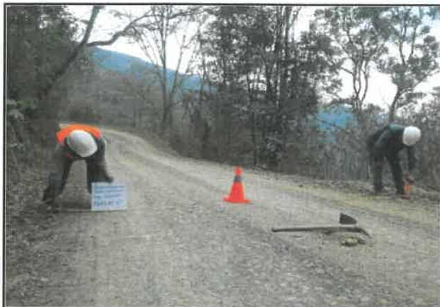
Foto 67: Ancho del pavimento de 4.50 m, progresiva 04+500.
