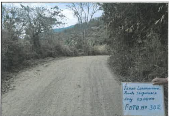
foto:302 Daño en pavimento, Presencia de erosion, progresiva De 19+750 a 20+000
