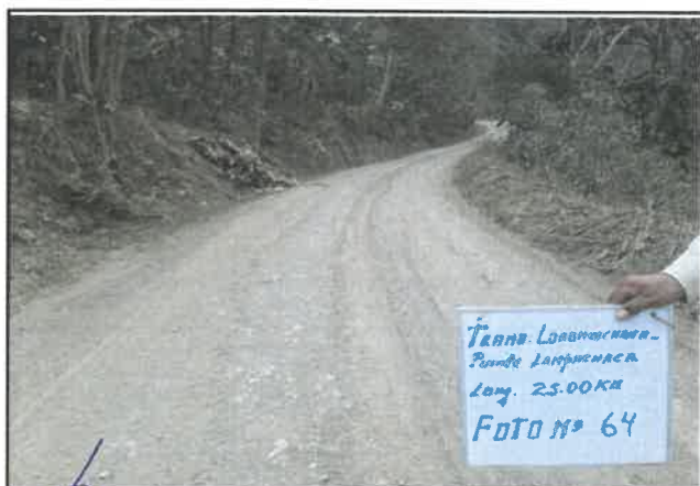
foto:64 Daño en pavimento, Presencia de erosion, progresiva De 04+250 a 04+500
