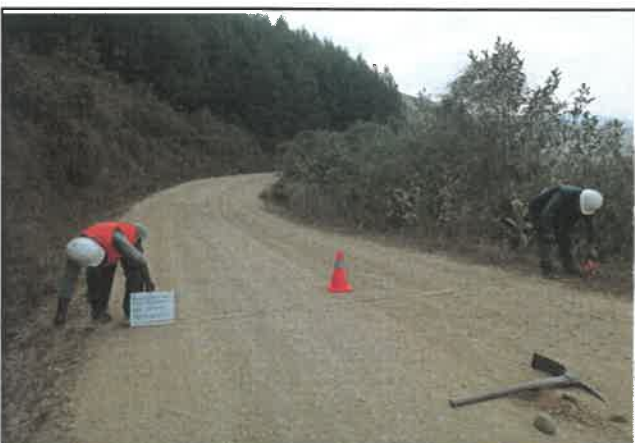
Foto 192: Ancho del pavimento de 5.30 m, progresiva 12+500.
