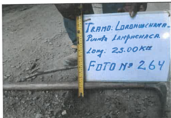
Foto 264: Espesor en pavimento de 4 cm, progresiva 17+500.
