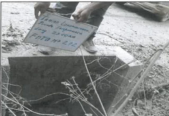
Foto 272: Alcantarilla de concreto simple en estado regular, progresiva 17+710.
