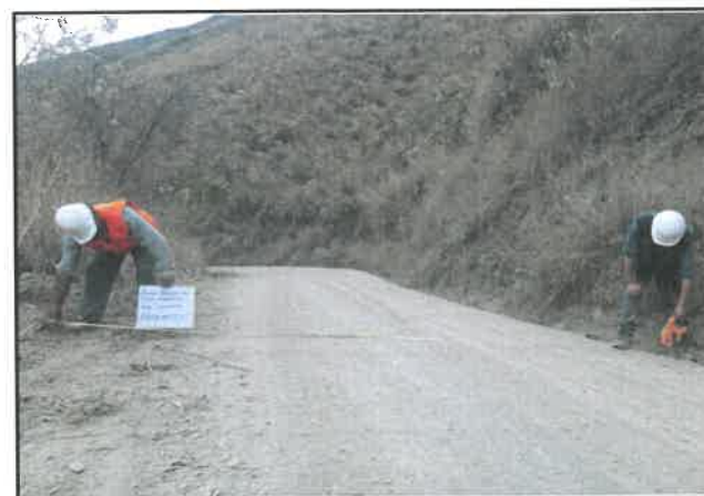
Foto 285: Ancho del pavimento de 5.30 m, progresiva 18+500.
