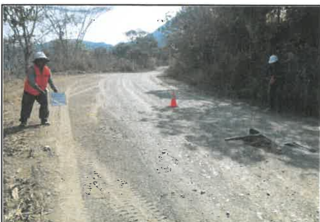
Foto 115: Ancho del pavimento de 6.50 m, progresiva 07+250.
