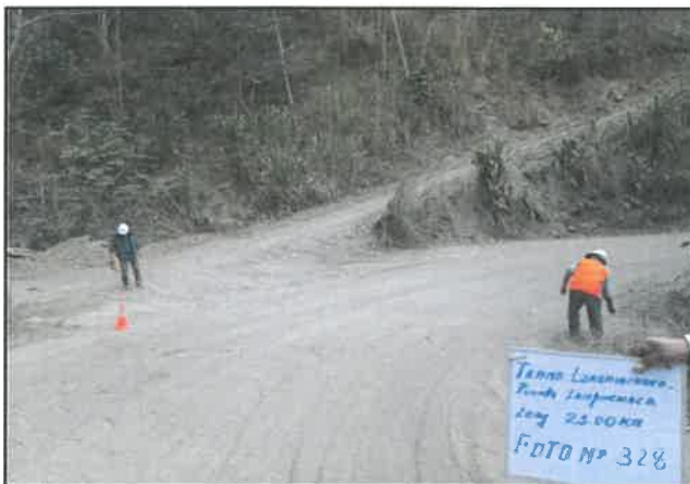
Foto 328: Badén de concreto simple en estado regular, progresiva 21+520.
