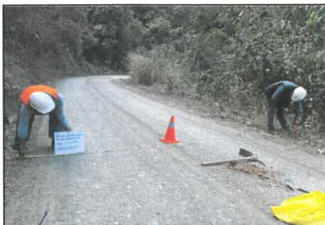
Foto 102: Ancho del pavimento de 4.50 m, progresiva 06+500.
