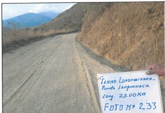
foto:233 Daño en pavimento, Presencia de erosion, progresiva De 15+250 a 15+500
