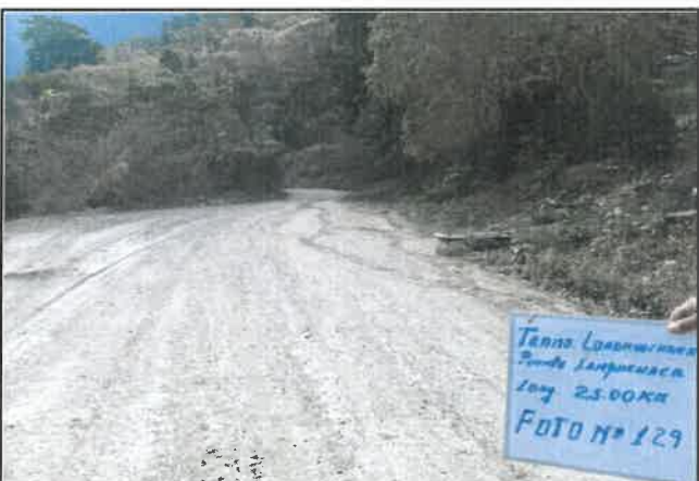
foto:129 Daño en pavimento, Presencia de erosión, progresiva De 08+250 a 08+500
