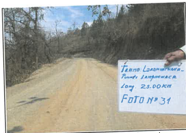
foto 31: Daño en pavimento, Presencia de erosion, progresiva De 02+000 a 02+250
