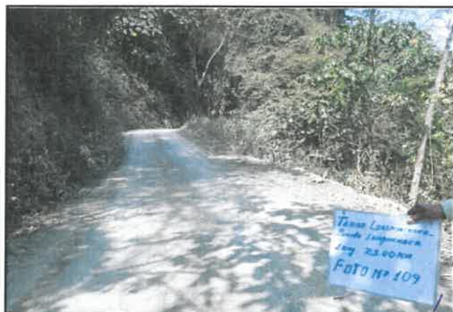
foto:109 Daño en pavimento, Presencia de erosión, progresiva De 06+750 a 07+000
