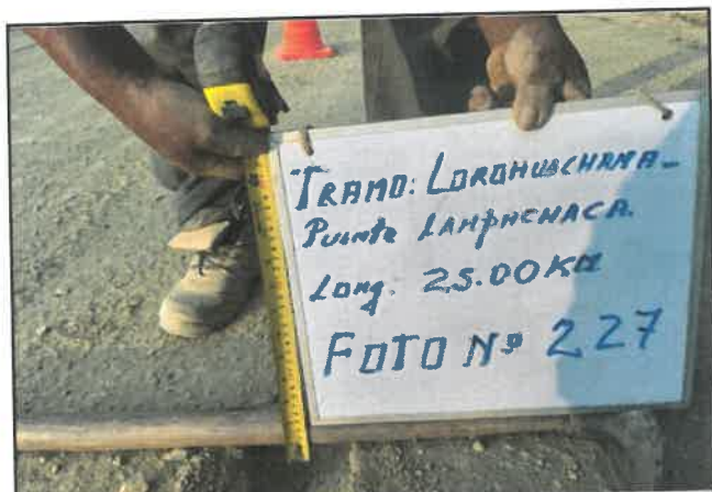
Foto 227: Espesor en pavimento de 2 cm, progresiva 15+000.
