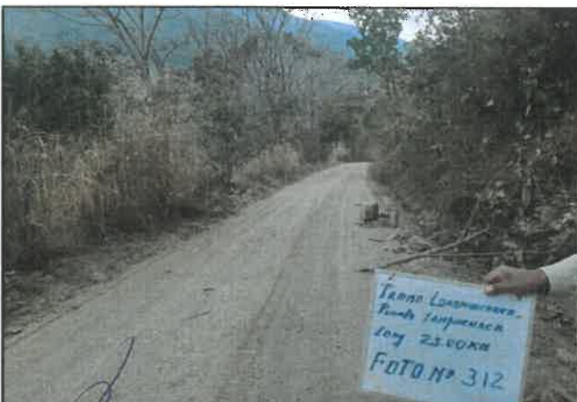
foto:312 Daño en pavimento, Presencia de erosion, progresiva De 20+500 a 20+750
