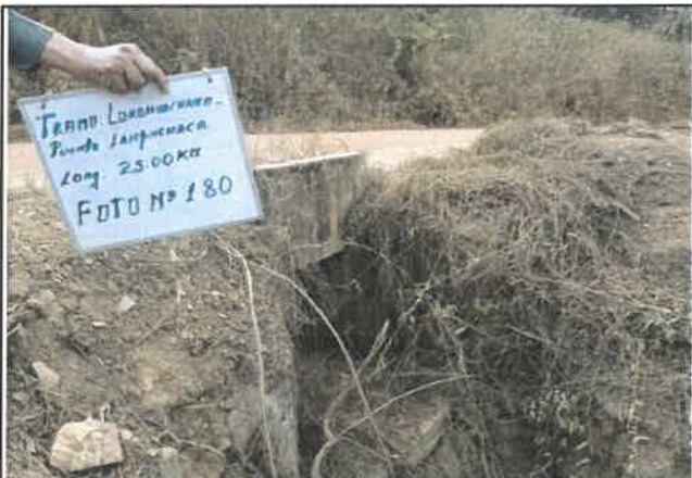
Foto 180: Alcantarilla de concreto simple en estado regular, progresiva 11+300.
