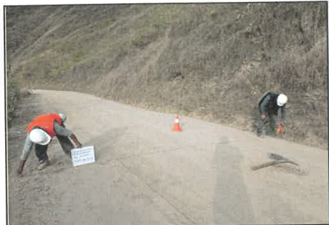
Foto 206: Ancho del pavimento de 5.20 m, progresiva 13+500.
