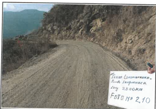
foto:210 Daño en pavimento, Presencia de erosion, progresiva De 13+750 a 14+000
