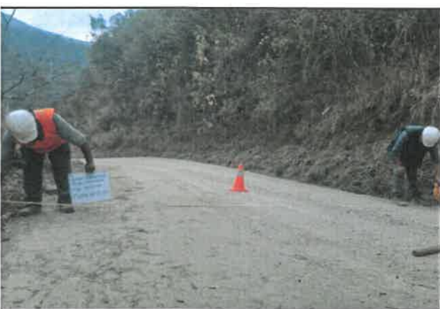
Foto 337: Ancho del pavimento de 5.10 m, progresiva 22+250.
