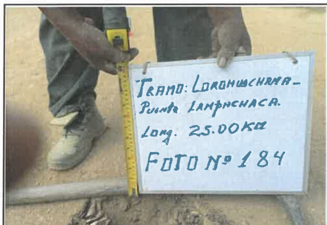
Foto 184: Espesor en pavimento de 1 cm, progresiva 12+000.
