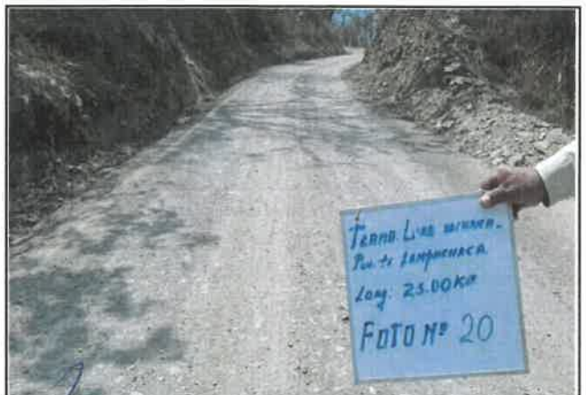
Foto 20: Daño en pavimento, Presencia de erosión, progresiva De 01+250 a 01+500
