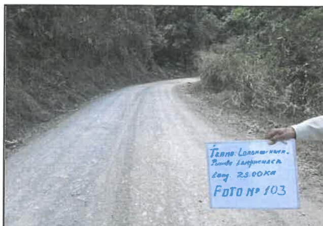
foto:103 Daño en pavimento, Presencia de erosión, progresiva De 06+500 a 06+750
