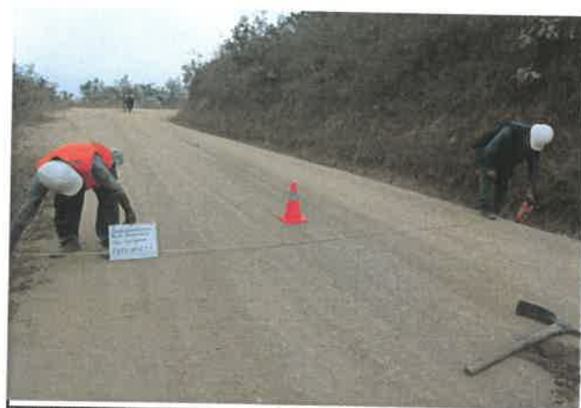
Foto 173: Ancho del pavimento de 4.80 m, progresiva 11+500.
