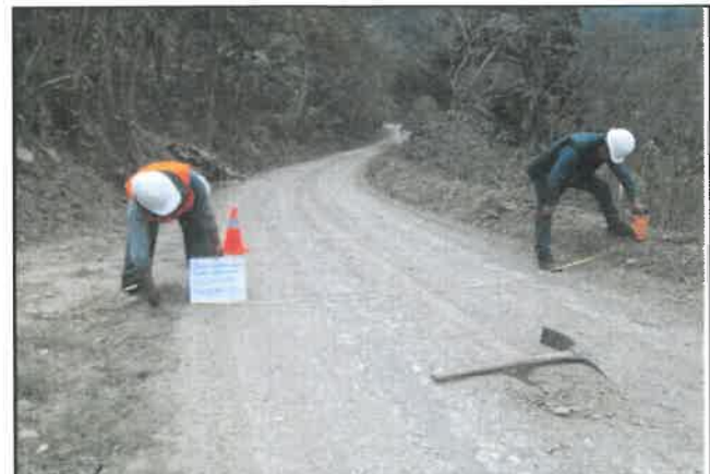
Foto 63: Ancho del pavimento de 3.80 m, progresiva 04+250.
