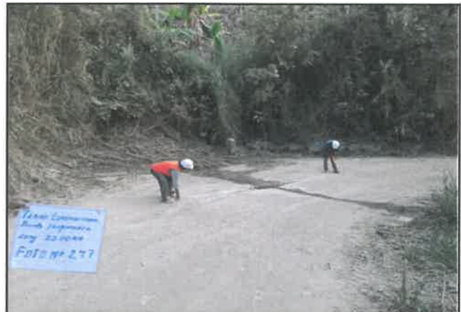
Foto 247: Baden de concreto simple en estado regular, progresiva 16+030.
