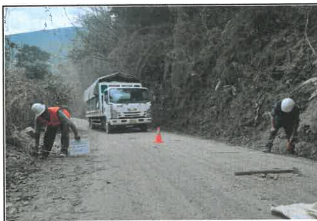
Foto 307: Ancho del pavimento de 4.50 m, progresiva 20+250.
