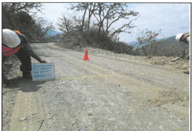
Foto 19: Ancho del pavimento de 4.10 m, progresiva 01+250.
