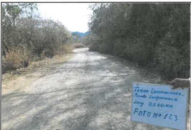
foto:123 Daño en pavimento, Presencia de erosión, progresiva De 07+750 a 08+000
