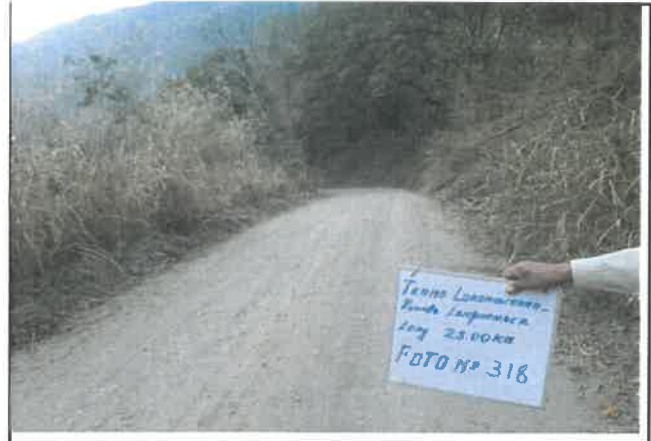
foto:318 Daño en pavimento, Presencia de erosion, progresiva De 21+000 a 21+250
