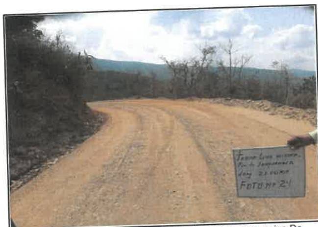
Foto 24: Daño en pavimento, Presencia de erosion, progresiva De 01+500 a 01+750
