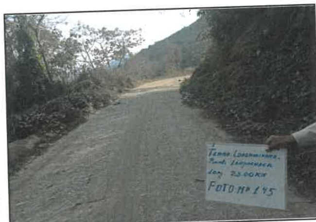
foto:145 Daño en pavimento, Presencia de erosión, progresiva De 09+250 a 09+500
