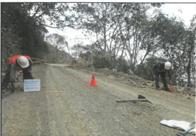
Foto 77: Ancho del pavimento de 5.00 m, progresiva 05+000.
