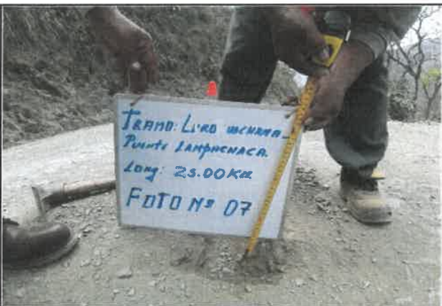
Foto 07: Espesor en pavimento de 9 cm, progresiva 00+500.
