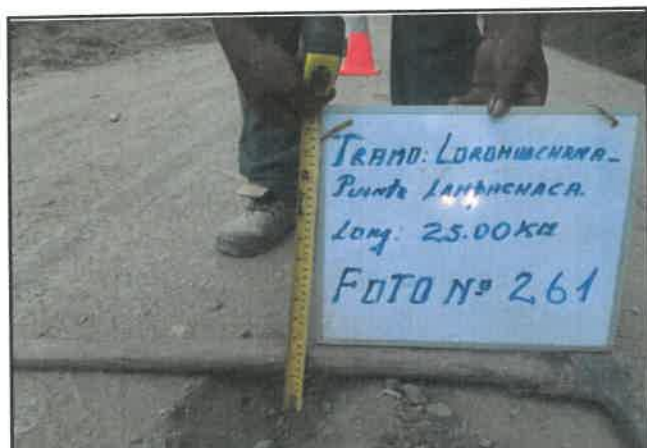
Foto 261: Espesor en pavimento de 5 cm, progresiva 17+250.
