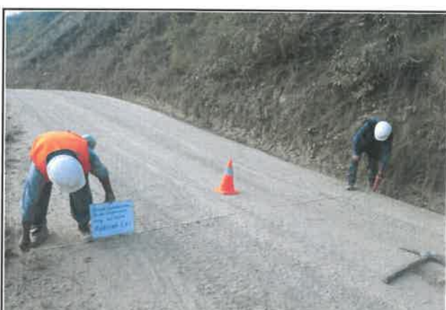
Foto 221: Ancho del pavimento de 4.60 m, progresiva 14+500.
