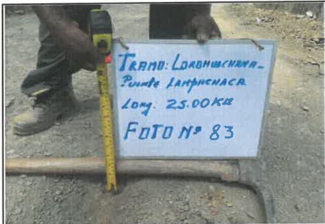
Foto 83: Espesor en pavimento de 5 cm, progresiva 05+250.
