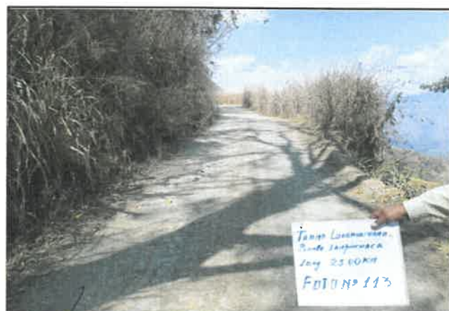
foto:113 Daño en pavimento, Presencia de erosión, progresiva De 07+000 a 07+250
