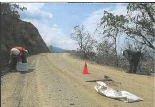
Foto 41: Ancho del pavimento de 4.90 m, progresiva 02+750.
