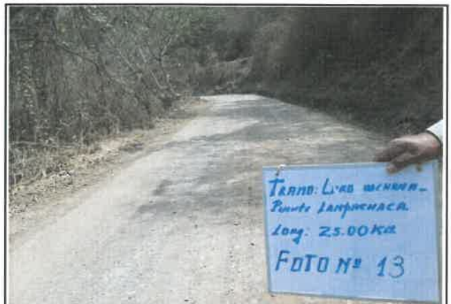
Foto 13: Daño en pavimento, Presencia de erosión, progresiva De 00+750 a 01+000
