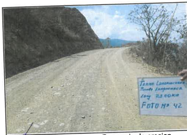
foto 42: Daño en pavimento, Presencia de erosion, progresiva De 02+750 a 03+000
