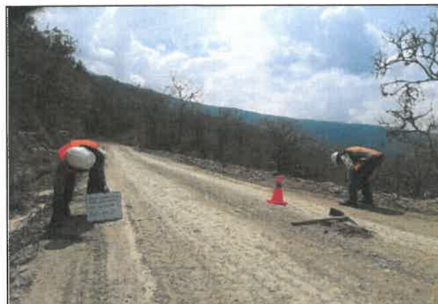
Foto 27: Ancho del pavimento de 4.30 m, progresiva 01+750.
