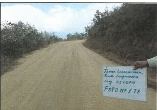
foto:178 Daño en pavimento, Presencia de erosion, progresiva De 11+500 a 11+750
