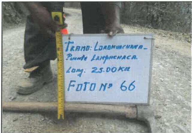
Foto 66: Espesor en pavimento de 3 cm, progresiva 04+500.
