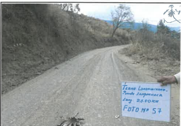
foto57: Daño en pavimento, Presencia de erosion, progresiva De 03+750 a 04+000
