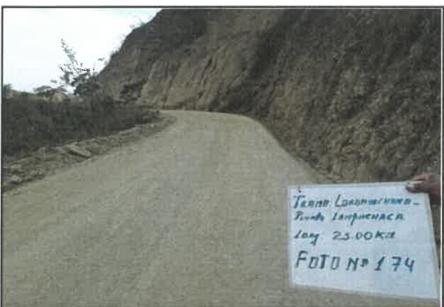
foto:174 Daño en pavimento, Presencia de erosion, progresiva De 11+250 a 11+500
