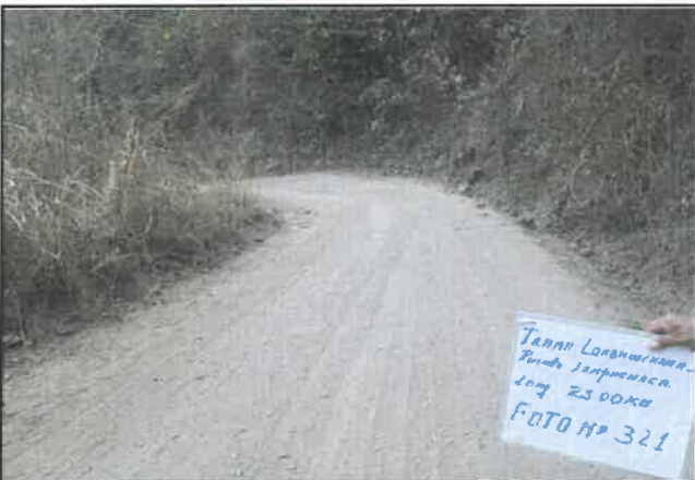
foto:321 Daño en pavimento, Presencia de erosion, progresiva De 21+250 a 21+500
