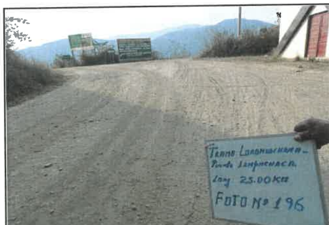
foto:196 Daño en pavimento, Presencia de erosión, progresiva De 12+750 a 13+000
