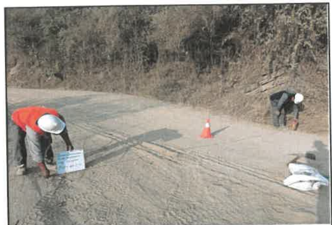
Foto 212: Ancho del pavimento de 6.50 m, progresiva 14+000.
