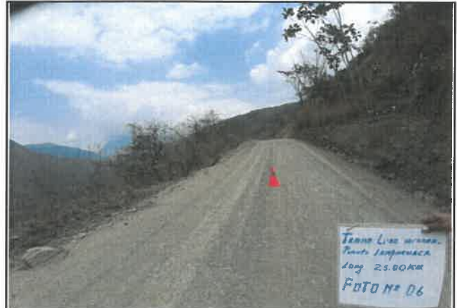
Foto 06: Daño en pavimento, Presencia de erosión, progresiva De 00+250 a 00+500
