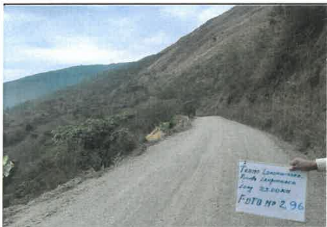
foto:296 Daño en pavimento, Presencia de erosion, progresiva De 19+250 a 19+500
