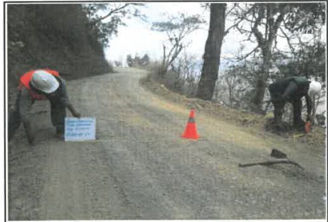
Foto 84: Ancho del pavimento de 4.40 m, progresiva 05+250.
