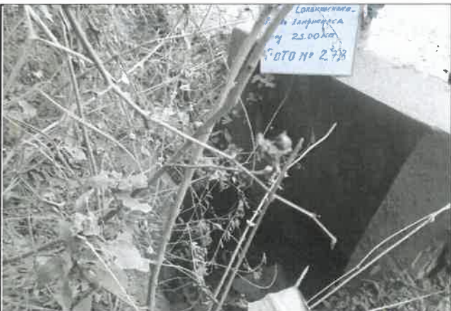
Foto 278: Alcantarilla de concreto simple en estado regular, progresiva 17+930.
