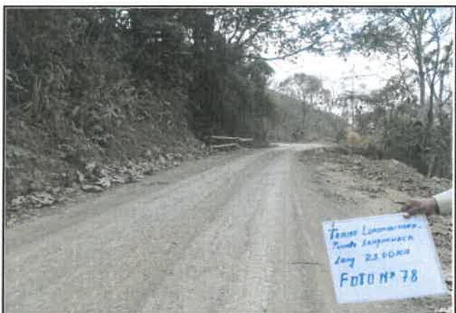
foto:78 Daño en pavimento, Presencia de erosion, progresiva De 05+000 a 05+250
