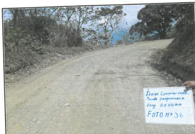
foto 38: Daño en pavimento, Presencia de erosion, progresiva De 02+500 a 02+750
