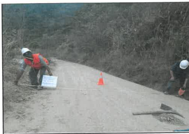
Foto 262: Ancho del pavimento de 4.50 m, progresiva 17+250.
