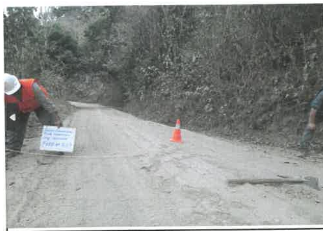
Foto 269: Ancho del pavimento de 4.70 m, progresiva 17+750.
