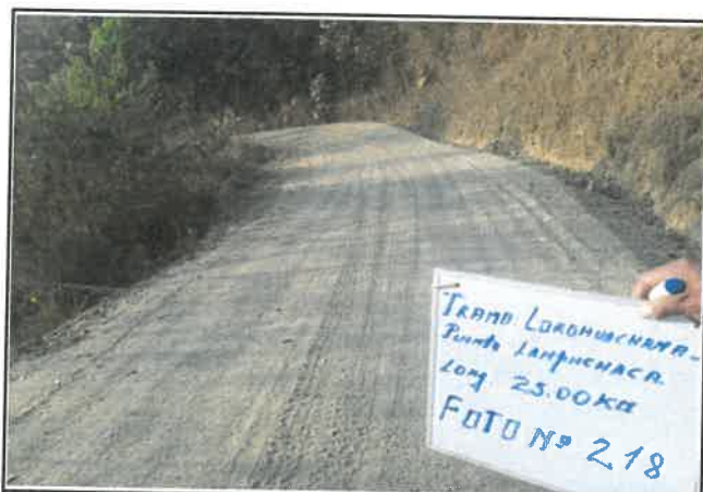
foto:218 Daño en pavimento, Presencia de erosion, progresiva De 14+250 a 14+500
