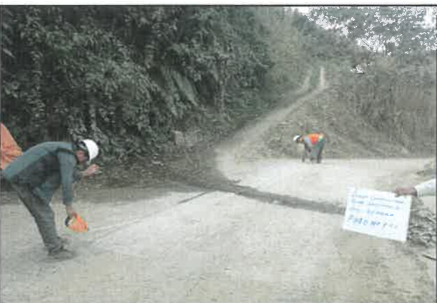
Foto 146: Baden de concreto simple en estado regular, progresiva 09+340.
