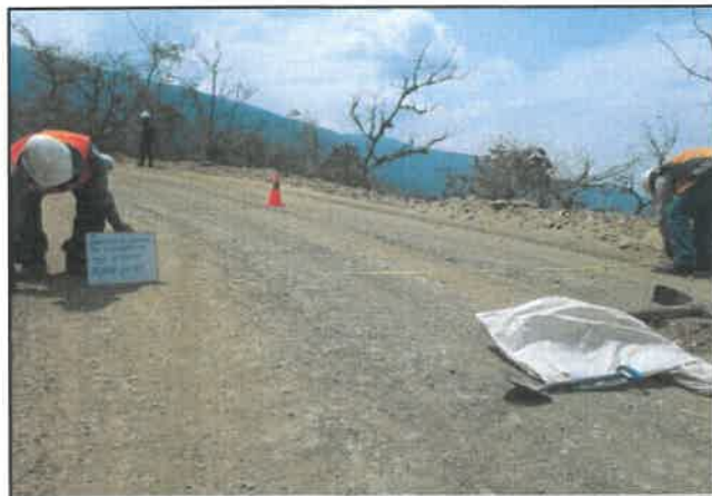
Foto 23: Ancho del pavimento de 4.20 m, progresiva 01+500.
