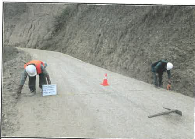
Foto 173: Ancho del pavimento de 4.80 m, progresiva 11+250.
