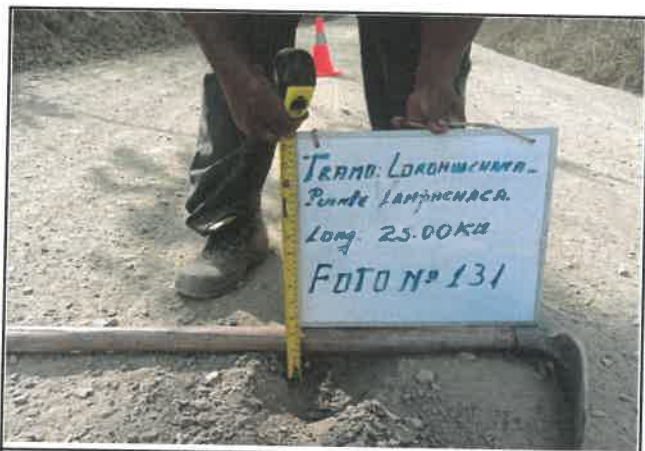
Foto 131: Espesor en pavimento de 4 cm, progresiva 08+500.
