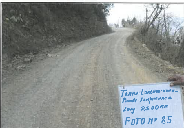
foto:85 Daño en pavimento, Presencia de erosion, progresiva De 05+250 a 05+500
