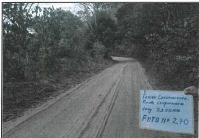
foto:270 Daño en pavimento, Presencia de erosion, progresiva De 17+750 a 18+000
