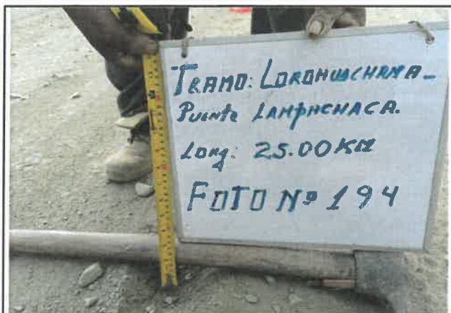
Foto 194: Espesor en pavimento de 4 cm, progresiva 12+750.
