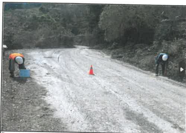
Foto 128: Ancho del pavimento de 6.40 m, progresiva 08+250.
