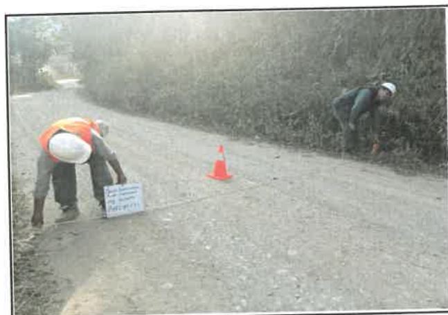
Foto 162: Ancho del pavimento de 4.60 m, progresiva 10+500.
