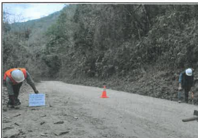
Foto 340: Ancho del pavimento de 5.40 m, progresiva 22+500.
