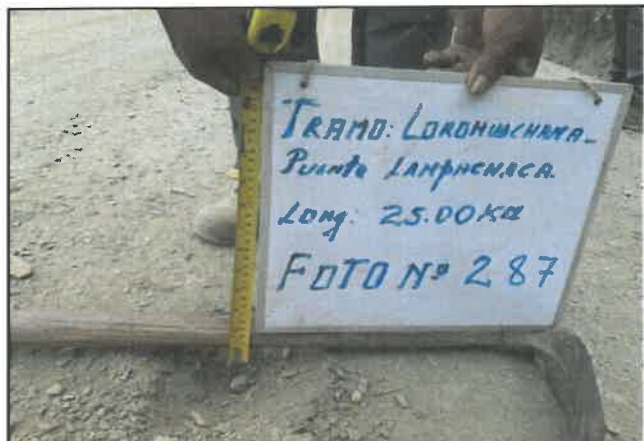
Foto 287: Espesor en pavimento de 2 cm, progresiva 18+750.
