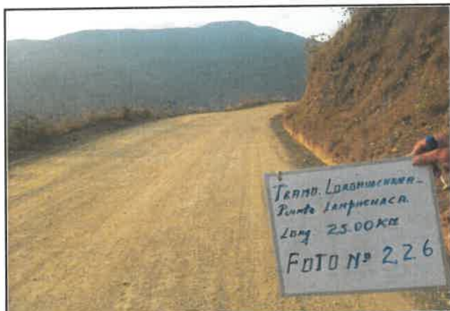
foto:226 Daño en pavimento, Presencia de erosion, progresiva De 14+750 a 15+000
