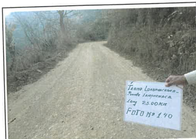
foto:140 Daño en pavimento, Presencia de erosión, progresiva De 09+000 a 09+250
