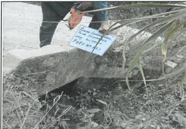
Foto 151: Alcantarilla de concreto simple en estado regular, progresiva 09+500.
