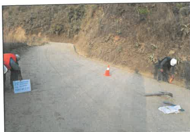
Foto 228: Ancho del pavimento de 6.10 m, progresiva 15+000.
