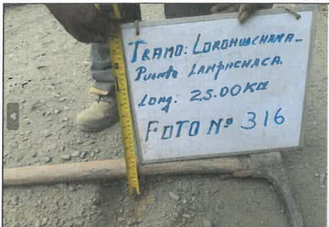
Foto 316: Espesor en pavimento de 5 cm, progresiva 21+000.
