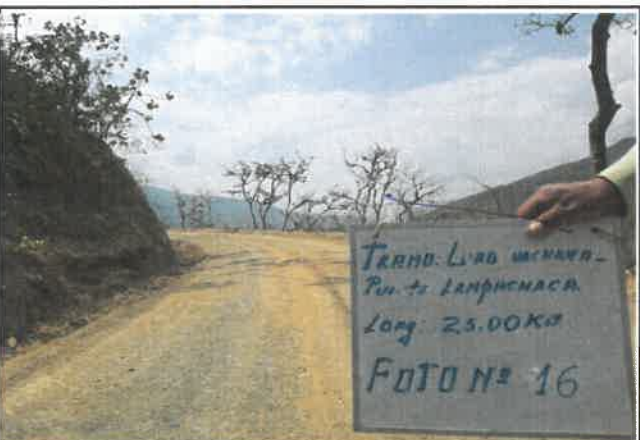
Foto 16: Daño en pavimento, Presencia de erosión, progresiva De 01+000 a 01+250
