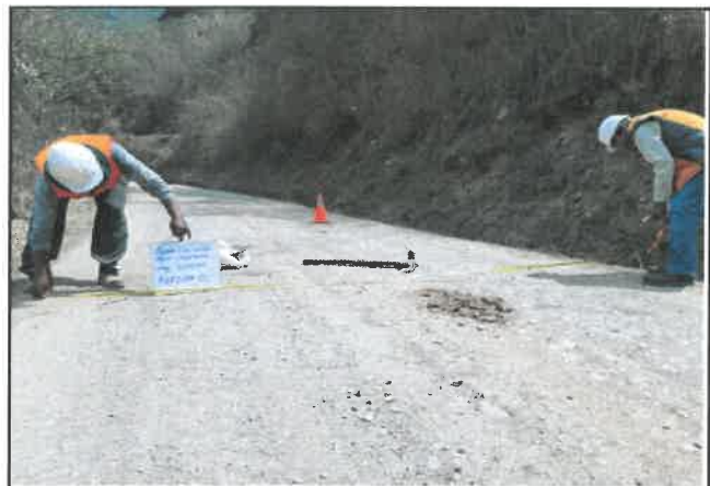
Foto 12: Ancho del pavimento de 3.70 m, progresiva 00+750.
