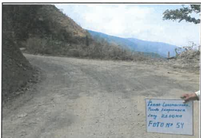
foto 54: Daño en pavimento, Presencia de erosion, progresiva De 03+500 a 03+750
