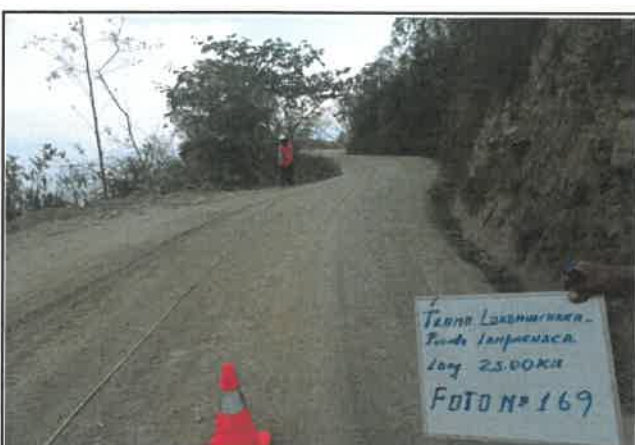
foto:169 Daño en pavimento, Presencia de erosion, progresiva De 11+000 a 11+250
