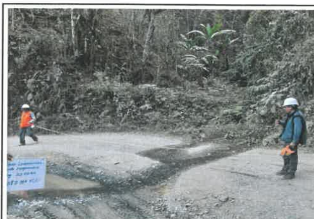
foto:100 Daño en pavimento, cruce de agua 8.00 x 9.50 no hay baden, progresiva 06+110
