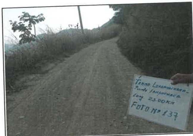
foto:137 Daño en pavimento, Presencia de erosión, progresiva De 08+750 a 09+000
