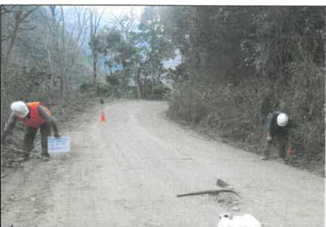
Foto 326: Ancho del pavimento de 5.60 m, progresiva 21+500.
