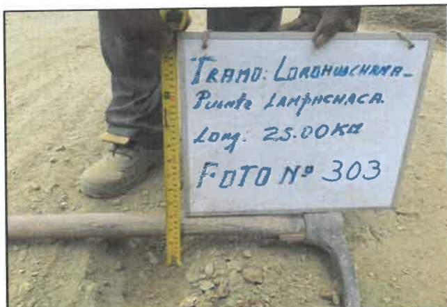
Foto 303: Espesor en pavimento de 6 cm, progresiva 20+000.
