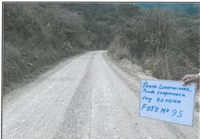
foto:95 Daño en pavimento, Presencia de erosión, progresiva De 06+000 a 06+250
