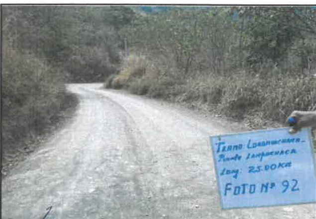
foto:92 Daño en pavimento, Presencia de erosion, progresiva De 05+750 a 06+000
