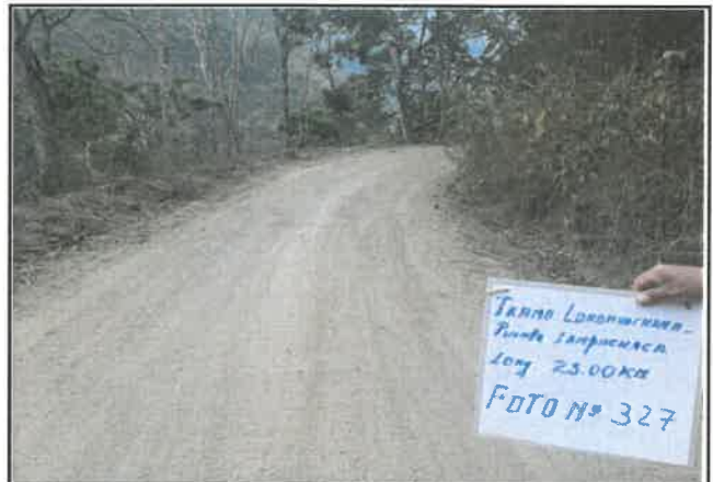
foto:327 Daño en pavimento, Presencia de erosion, progresiva De 21+500 a 21+750
