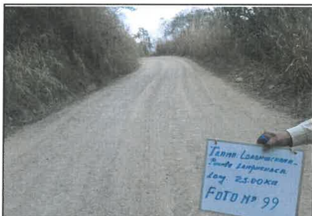
foto:99 Daño en pavimento, Presencia de erosión, progresiva De 06+250 a 06+500
