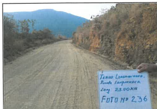
foto:236 Daño en pavimento, Presencia de erosion, progresiva De 15+500 a 15+750
