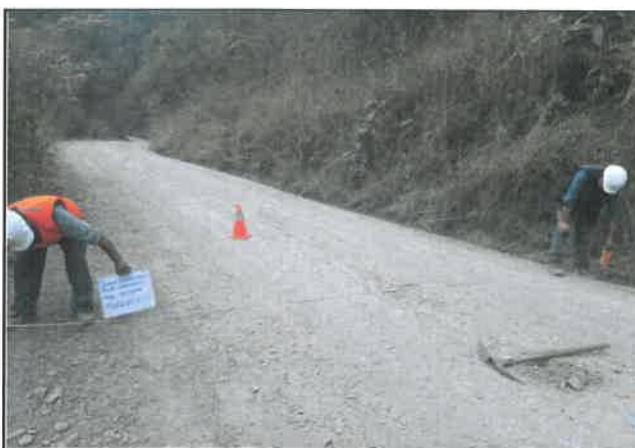
Foto 330: Ancho del pavimento de 5.20 m, progresiva 21+750.
