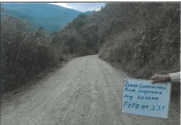
foto:331 Daño en pavimento, Presencia de erosion, progresiva De 21+750 a 22+000
