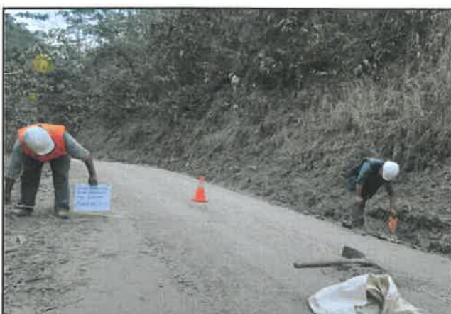
Foto 343: Ancho del pavimento de 4.60 m, progresiva 22+750.
