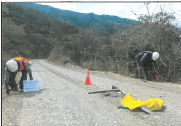
Foto 94: Ancho del pavimento de 5.40 m, progresiva 06+000.
