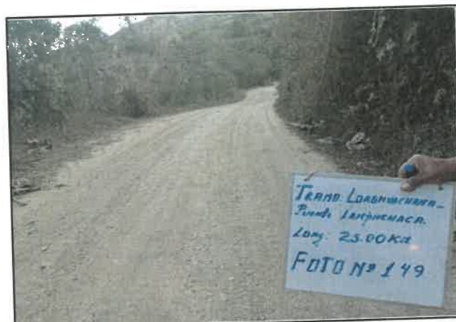
foto:149 Daño en pavimento, Presencia de erosión, progresiva De 09+500 a 09+750
