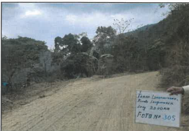
foto:305 Daño en pavimento, Presencia de erosion, progresiva De 20+000 a 20+250
