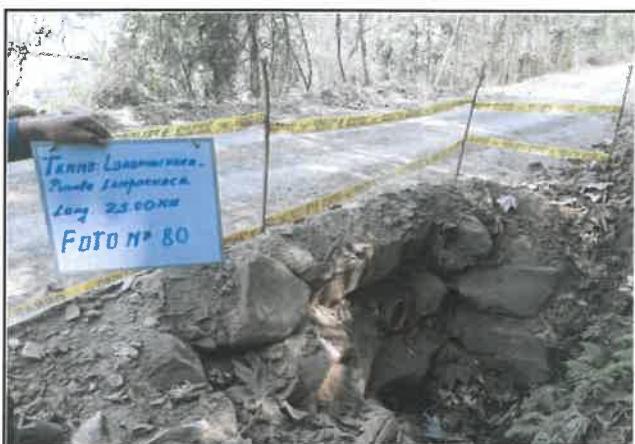
Foto 80: Alcantarilla de concreto simple en estado regular, progresiva 04+940.
