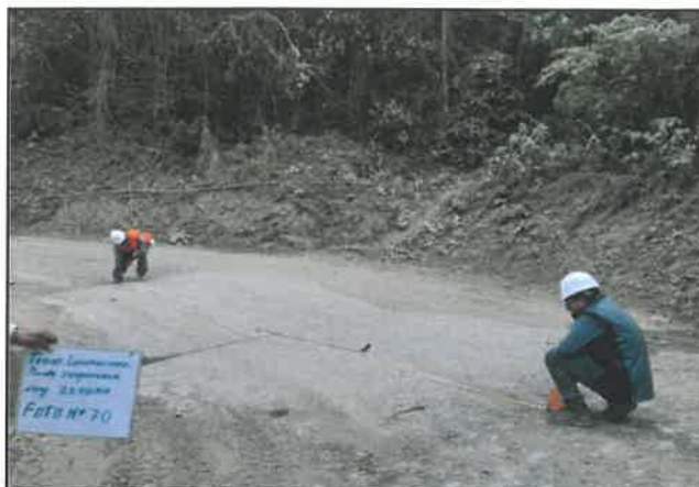
Foto 70: Baden de concreto simple en estado regular, progresiva 04+360.
