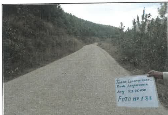
foto:188 Daño en pavimento, Presencia de erosión, progresiva De 12+250 a 12+500
