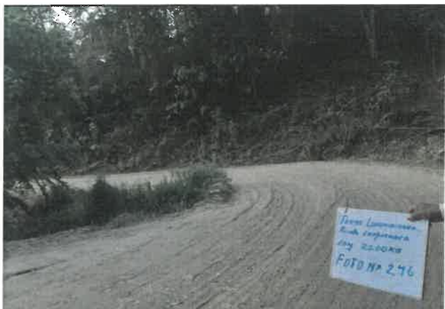
foto:246 Daño en pavimento, Presencia de erosión, progresiva De 16+250 a 16+500
