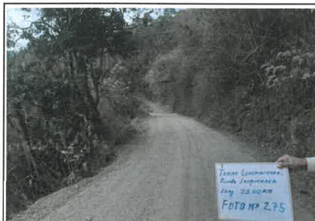
foto:275 Daño en pavimento, Presencia de erosion, progresiva De 18+000 a 18+250
