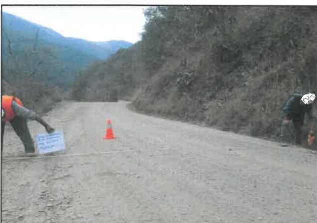
Foto 333: Ancho del pavimento de 5.50 m, progresiva 22+000.
