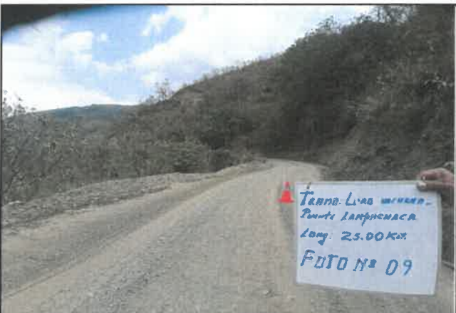
Foto 09: Daño en pavimento, Presencia de erosión, progresiva De 00+500 a 00+750
