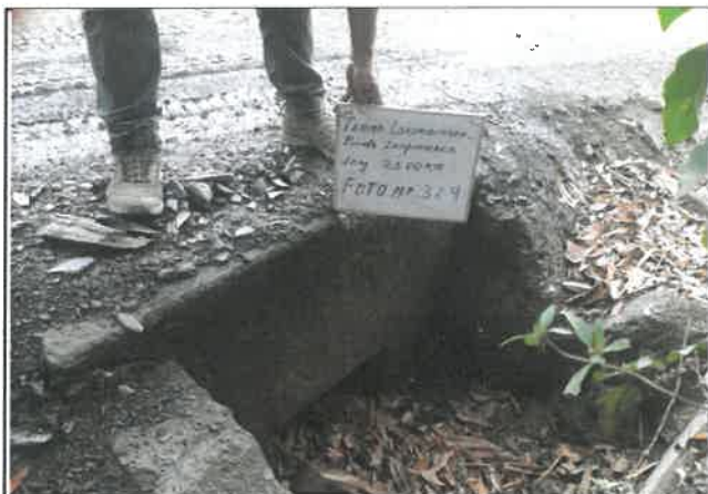
Foto 324: Alcantarilla de concreto simple en estado regular, progresiva 21+410.
