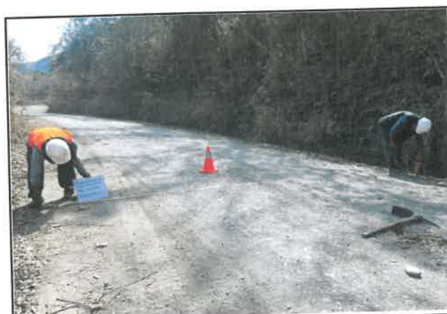
Foto 122: Ancho del pavimento de 5.60 m, progresiva 07+750.
