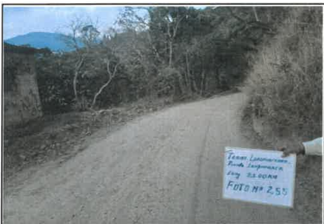
foto:255 Daño en pavimento, Presencia de erosión, progresiva De 16+750 a 17+000
