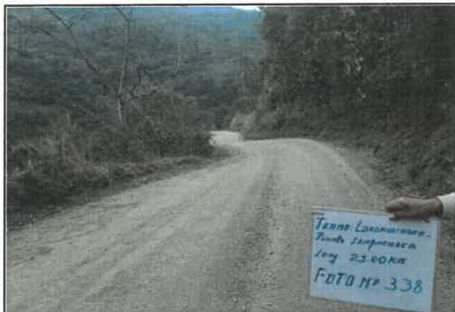
foto:338 Daño en pavimento, Presencia de erosión, progresiva De 22+250 a 22+500
