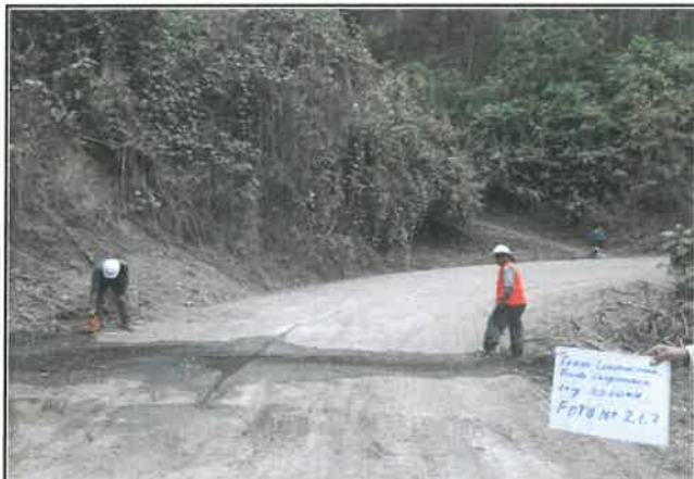
Foto 267: Baden de concreto simple en estado regular, progresiva 17+540.
