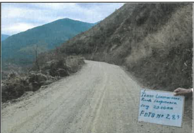
foto:289 Daño en pavimento, Presencia de erosion, progresiva De 18+750 a 19+000
