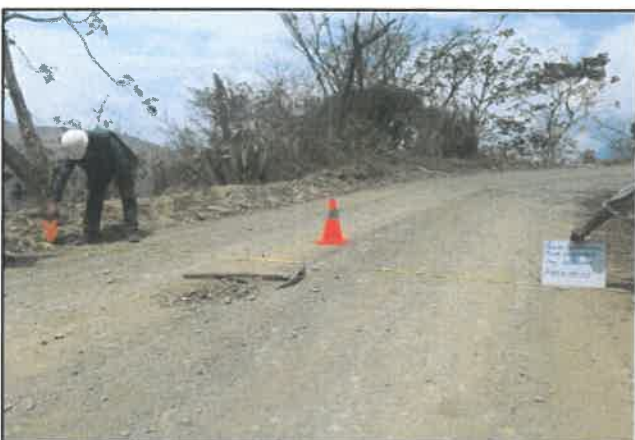
Foto 37: Ancho del pavimento de 5.10 m, progresiva 02+500.
