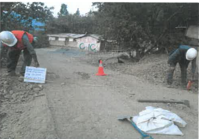
Foto 257: Ancho del pavimento de 4.00 m, progresiva 17+000.
