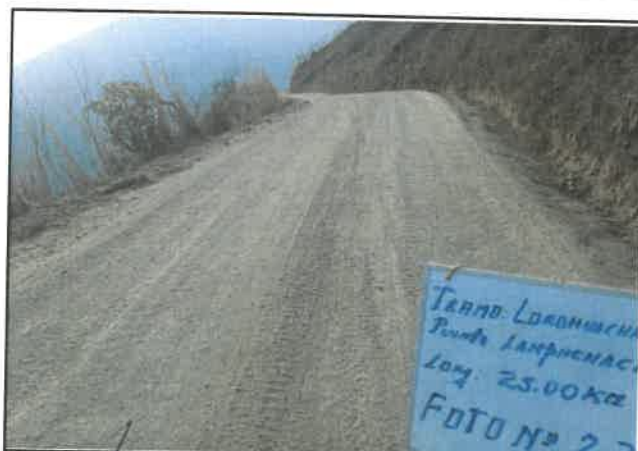
foto:222 Daño en pavimento, Presencia de erosion, progresiva De 14+500 a 14+750
