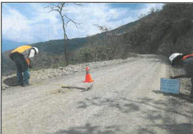
Foto 34: Ancho del pavimento de 4.20 m, progresiva 02+250.
