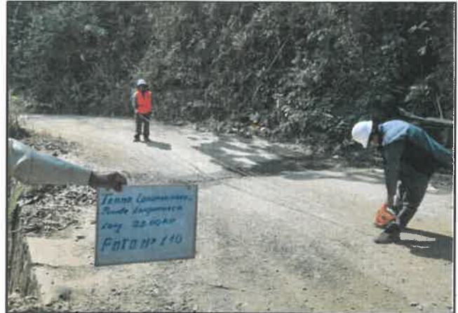
Foto 110: Baden de concreto simple en estado regular, progresiva 06+620.
