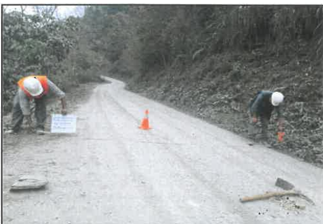
Foto 351: Ancho del pavimento de 4.20 m, progresiva 23+000.
