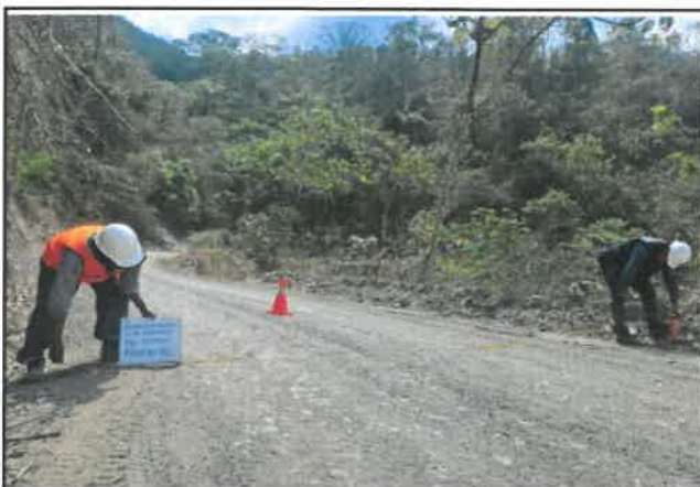
Foto 72: Ancho del pavimento de 5.40 m, progresiva 04+750.
