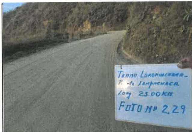
foto:229 Daño en pavimento, Presencia de erosion, progresiva De 15+000 a 15+250
