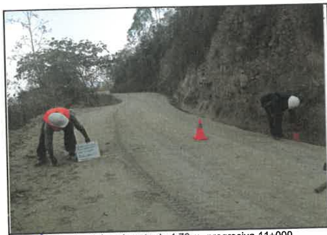
Foto 168: Ancho del pavimento de 4.70 m, progresiva 11+000.
