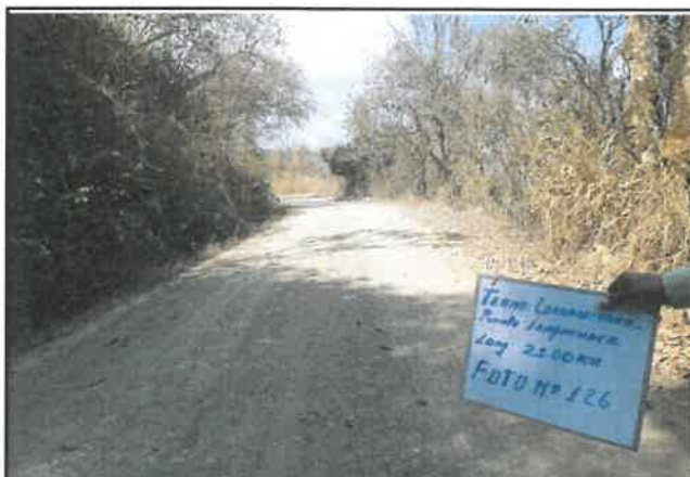
foto:126 Daño en pavimento, Presencia de erosión, progresiva De 08+000 a 08+250
