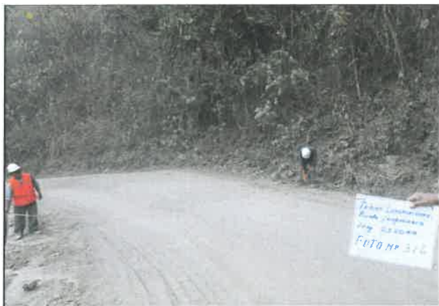
Foto 322: Badén de concreto simple en estado regular, progresiva 21+320.
