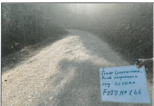
foto:166 Daño en pavimento, Presencia de erosion, progresiva De 10+750 a 11+000
