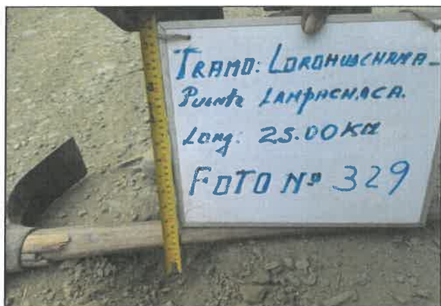
Foto 329: Espesor en pavimento de 5 cm, progresiva 21+750.
