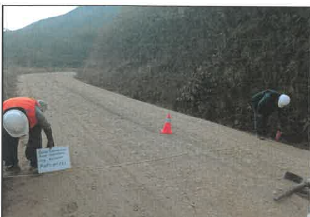
Foto 156: Ancho del pavimento de 5.20 m, progresiva 10+000.
