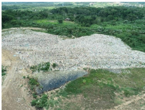
Imagen 03. Presencia de Lixiviados en el botadero de Moyobamba
