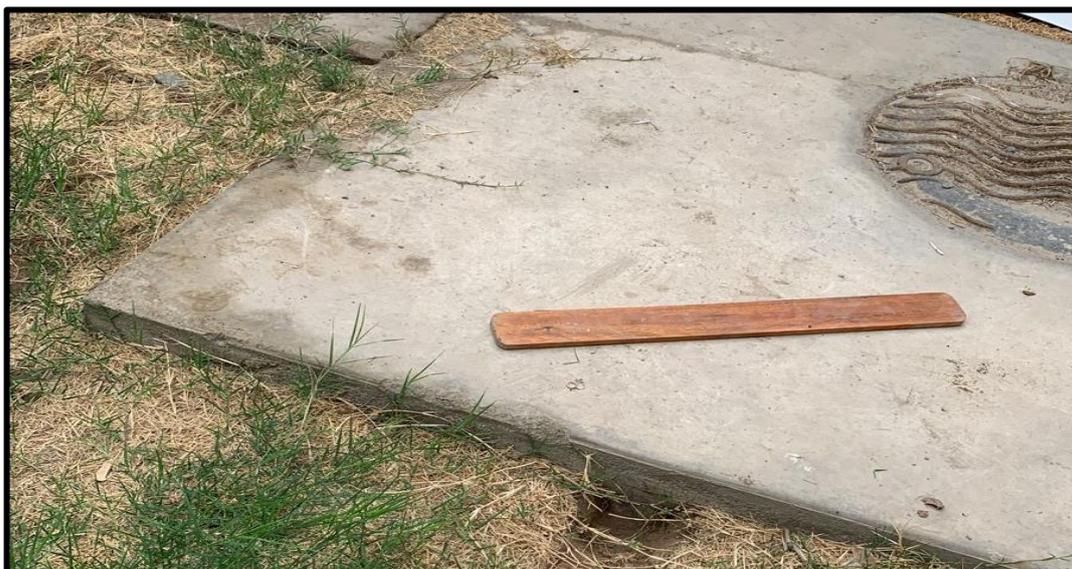
**Fotografía 07:** En la fotografía se puede observar la medición de la profundidad de la losa donde se encuentra el módulo de drywall existente en el terreno donde se realizará el laboratorio.
