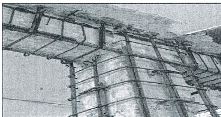
Figura n° 22: Reforzamiento de columnas mediante "Encamisado"
