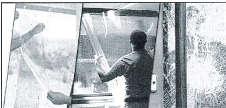
Figura n° 26: Implementación de láminas de seguridad
