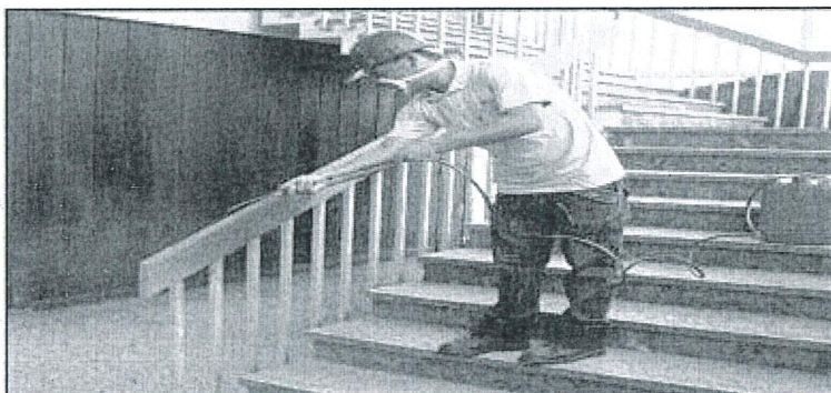
Figura n° 27: Aplicación de retardante ignífugo en estructuras de madera
