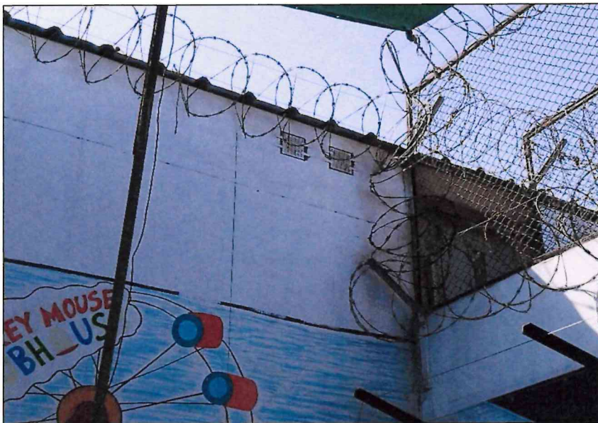
Patio con concertinas caídas, mal instaladas y en mal estado (oxidadas)
