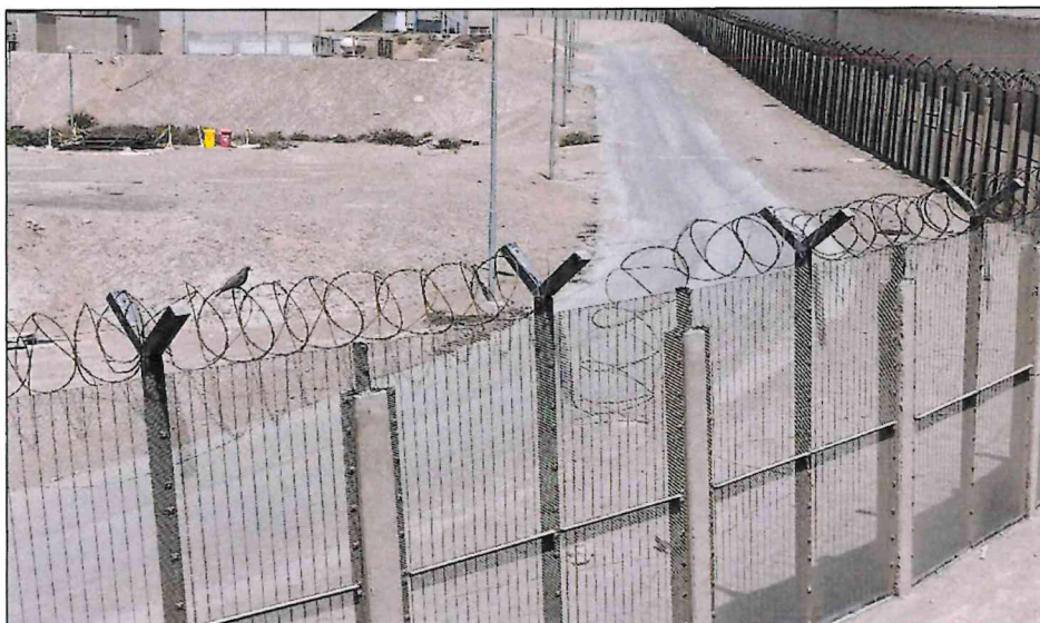
Cerco de mallas metálico tipo Prodac existente entre pista vehicular y TN.
