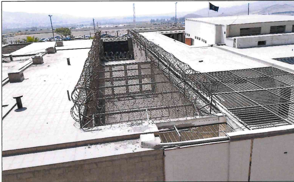
Concertinas y parantes oxidados en muy mal estado de conservación
