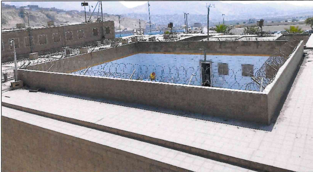
Concertinas en mal estado en techos de patios de pabellones, debido a la cercanía a la playa éstas se oxidan muy rápido y necesitan reposición de concertinas a 45°
