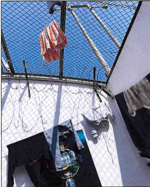
Patio con malla en techo, pero le faltan concertinas perimétricas en todos lados Aquí el Jefe de seguridad recomienda concertinas en 45° grados de inclinación
