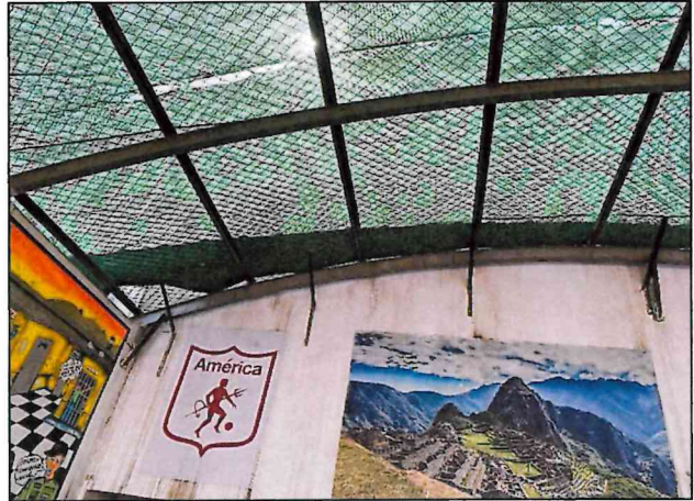
Patio con malla en techo, pero le faltan concertinas perimétricas en todos lados Aquí el Jefe de seguridad recomienda concertinas en 45° grados de inclinación
