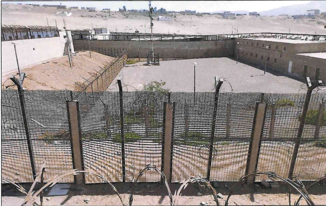
Zonas sin concertinas, oxidadas, rotas o caídas que vulneran la seguridad
