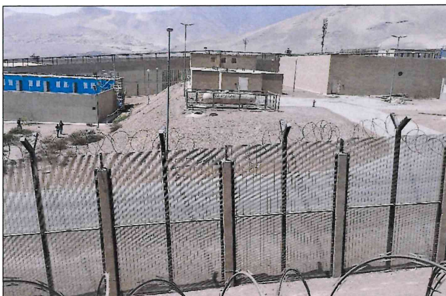
Concertinas deformes, caídas, sin cable tensor y con el tipo de cuchilla no adecuadas
