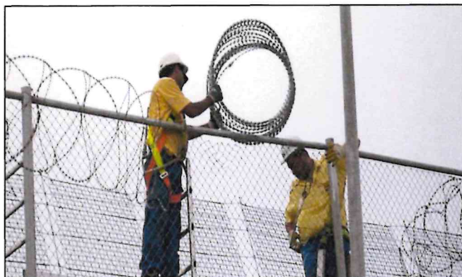
Imágenes Referenciales de instalación sobre malla metálica
