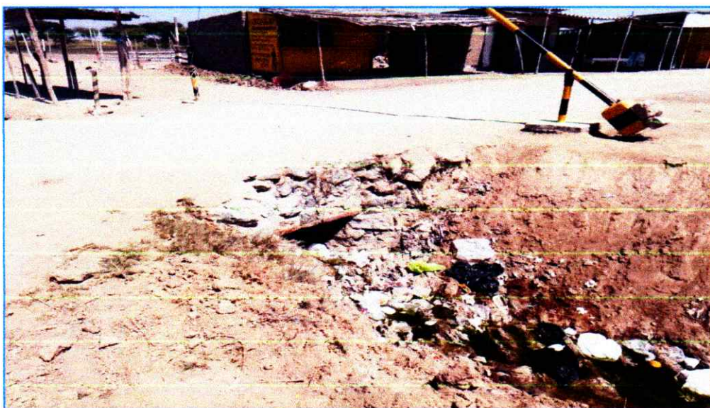
FOTO N° 01. -En la avenida Simón Ruiz se observa un cruce de canal de aguas de drenaje con presencia de desorden ambiental (polvo y basura), con necesidad de una obra de arte (Pontón de concreto armado)
