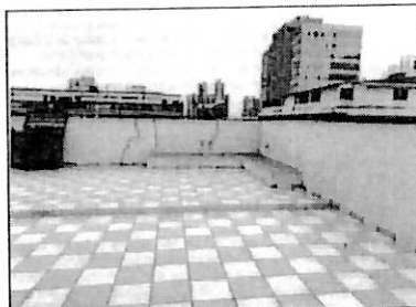
Fisuramientos en el piso 8 colindante con el Jr. Sebastián Barranca N° 1629.
