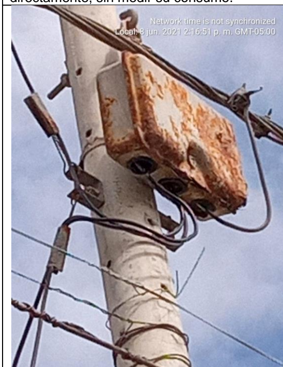
Caja de derivacion en estado de oxidacion
