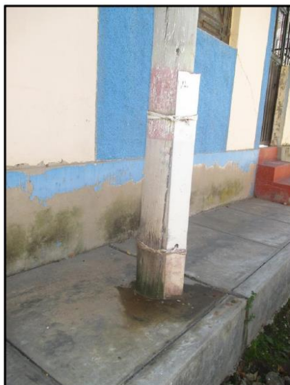
Fig. N° 07: Postes en mal estado Tallapuquio
