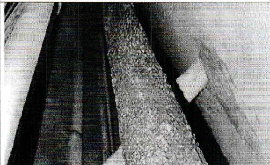
FOTOGRAFIA 01: TUBERIAS CORROIDAS REQUIEREN CAMBIO
