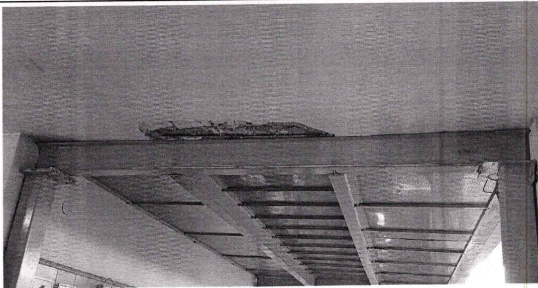
Imagen 01: Desprendimiento de los elementos de la losa aligerada.
