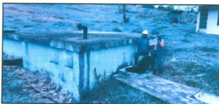
Imagen 3. Captación de ladera "El Suro", con deterioro moderado.
