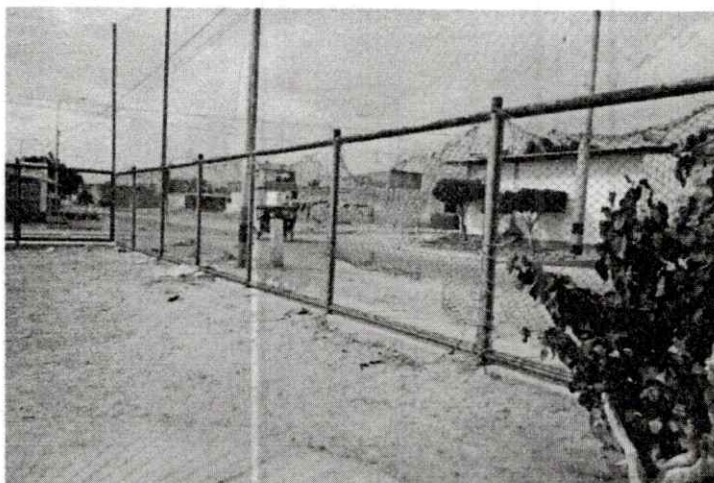
Presencia de corrosión en todo el perímetro del cercado del área deportiva, tanto la malla galvanizada, y los tubos de soporte.
