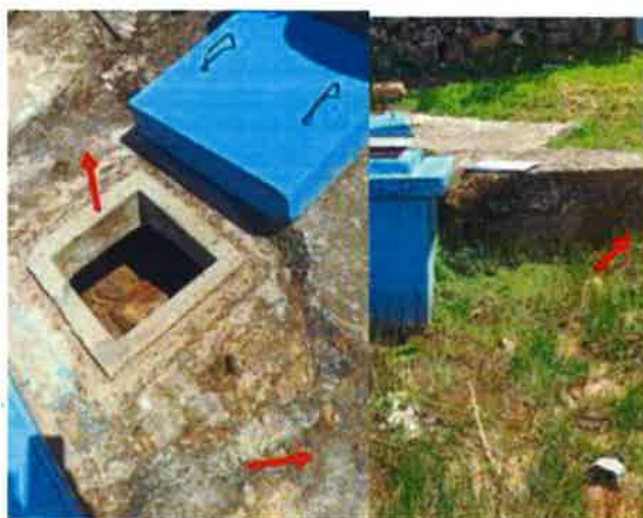
Figura 11 Estado actual de Cámara Recolectora, paredes y techo
