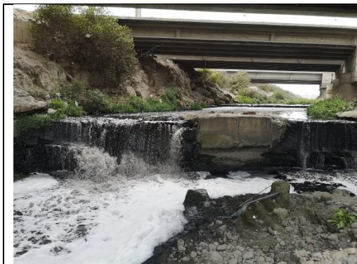
Foto 01: Año 2021, deterioro del dado de protección por la corriente del río Rímac.
