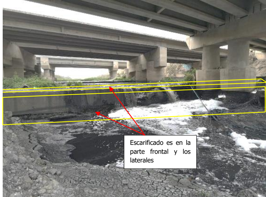
Figura 02: Vista del dado de protección y las zonas que requerirán la escarificación
